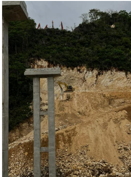
Gambar 3. 48 Jalan Akses Menuju Abutment 1
