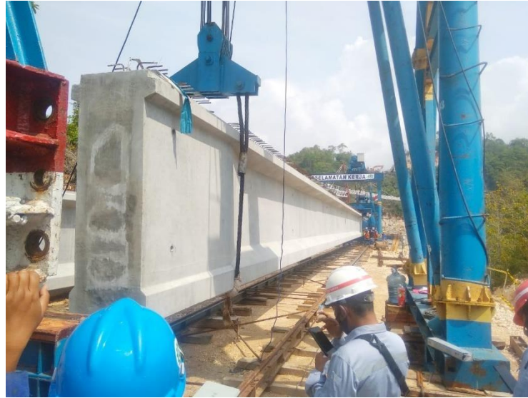
Gambar 3. 45 Proses Pindahkan Girder Menuju Trolley Rail Menggunakan Portal Gantry (Sumber: Dokumentasi Kerja Praktik Proyek Pembangunan Jalan Baru Planjan-Baron-Tepus)
