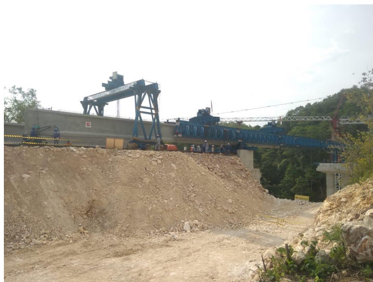
Gambar 3. 46 Proses Pindahkan Girder Menuju Pier Jembatan
