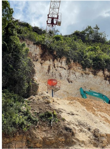
Gambar 3. 49 Proses Pengecoran Borepile Menggunakan Bucket Cor
