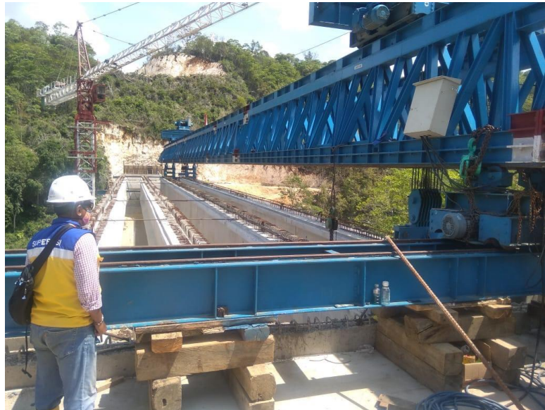
Gambar 3. 47 Antar Segmen Girder Telah Terpasang Brassing
