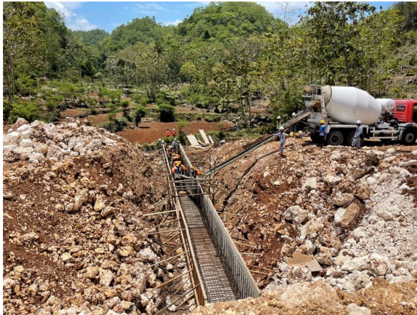
Pengecoran box culvert di STA 1+850
