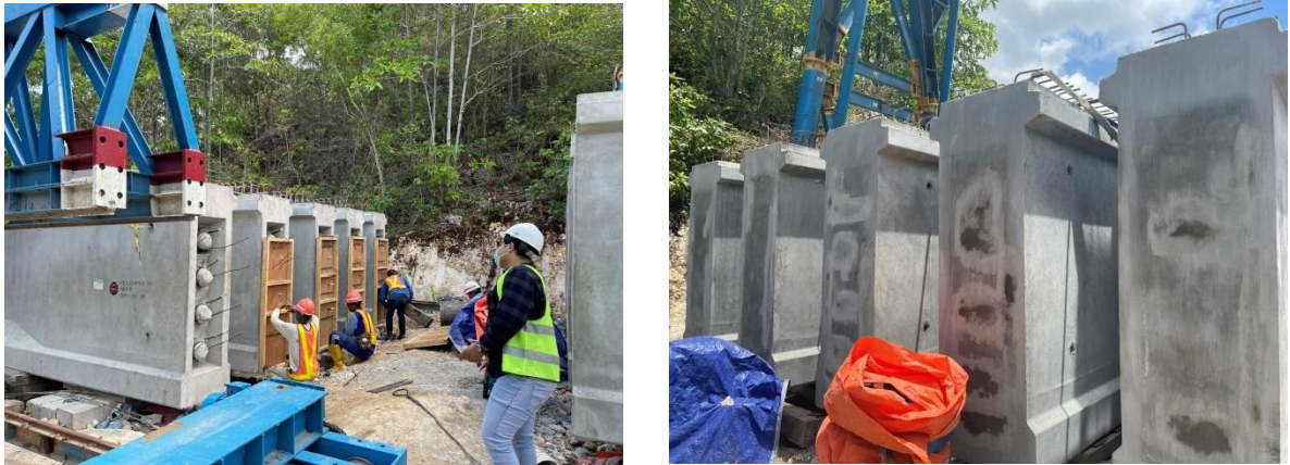
Gambar 3. 37 Proses patching (kiri), Semen pada patching telah kering (kanan)
