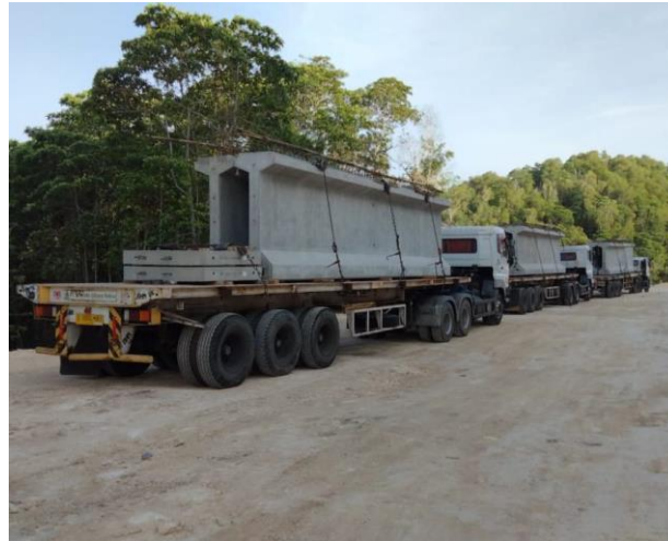
Gambar 3. 19 Balok girder telah sampai pada STA 8+700
