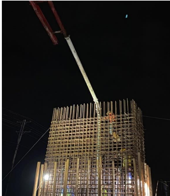
Gambar 3. 31 Proses pengecoran pilar tahap 1
