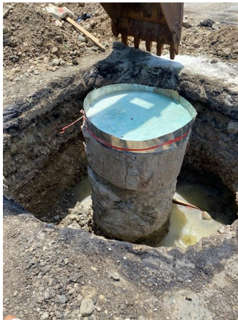
Gambar 3. 43 Capping pada permukaan bored pile
