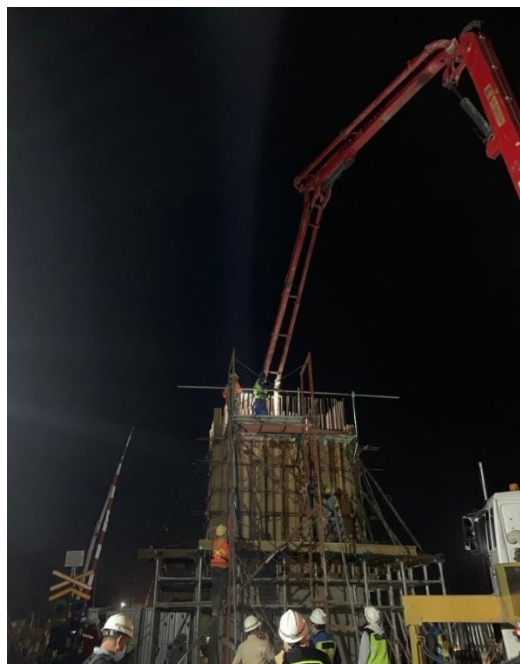
Gambar 3. 32 Proses pengecoran pilar tahap 2
