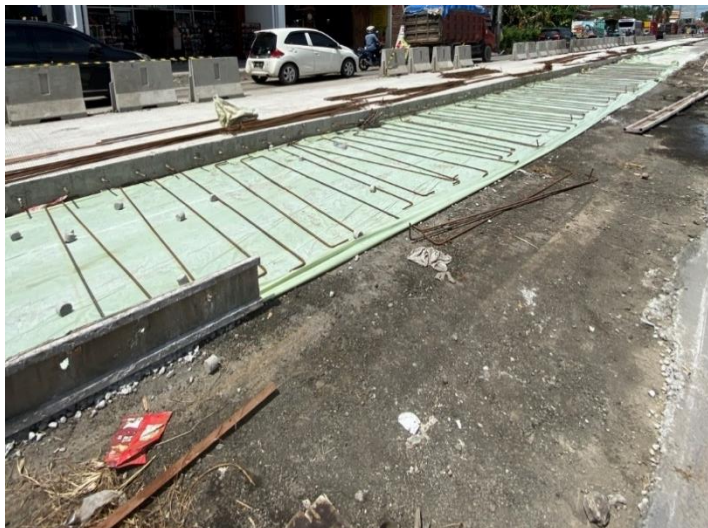
Gambar 3. 17 Proses pemasangan bekisting
