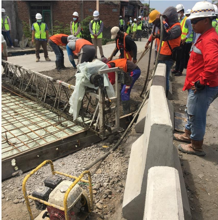
Gambar 3. 26 Proses pemerataan permukaan rigid menggunakan bantuan mesin
