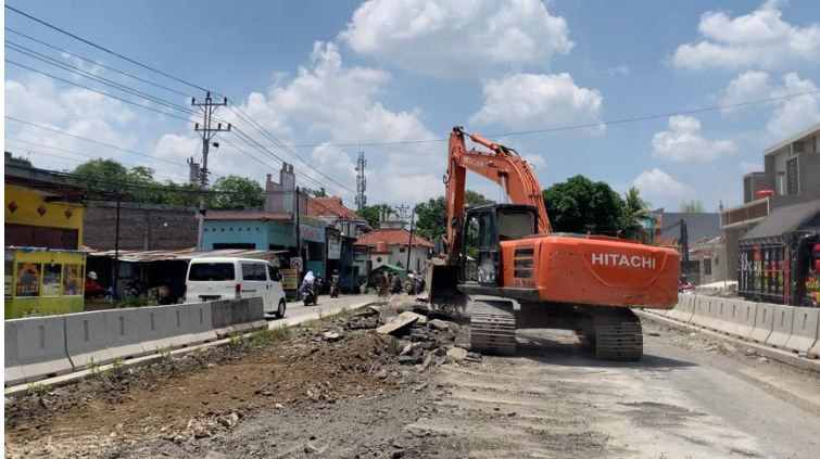
Gambar 3. 16 Excavator sedang membuang bekas pekerjaan galian
