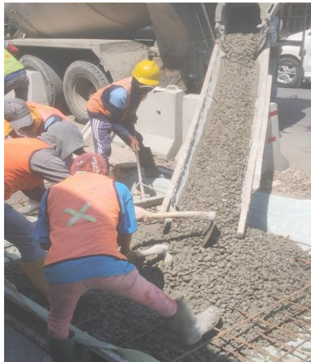
Gambar 3. 22 Proses pemerataan ready mix
