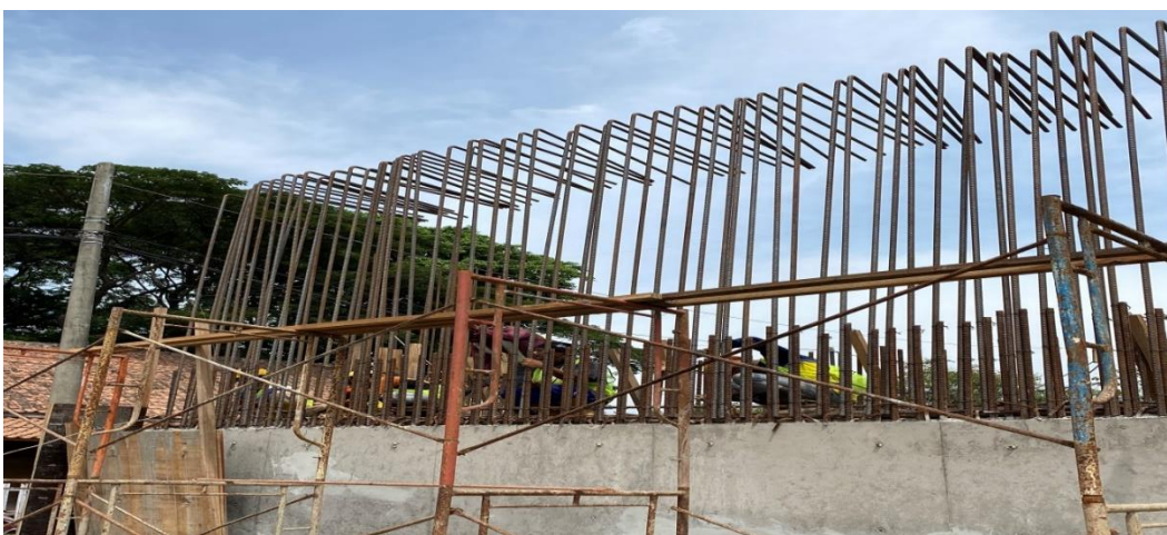
Gambar 3. 29 Tulangan pada pilar
