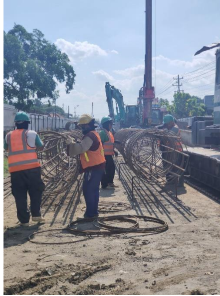
Gambar 3. 34 Proses perakitan tulangan besi sebagai tulangan besi struktur pile
