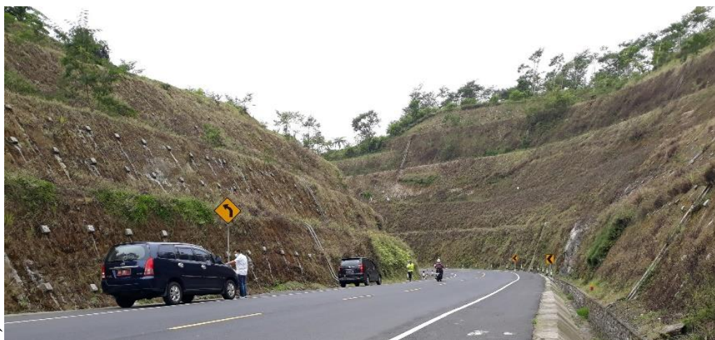
Gambar 1.5 Dokumentasi existing lapangan lereng galian dengan perkuatan soil nailing (Satker PJN Wilayah III Provinsi Bali)
