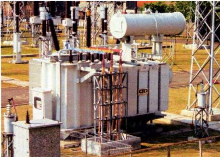
Gambar 3. 1 Transformator Daya 150 kV di Gardu Induk Kenjeran
