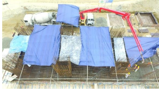
Gambar 5 19 Penggunaan Truck Mixer dan Concrete Pump
