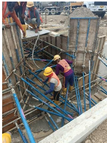
Gambar 5 20 Penuangan dan Penggetaran Beton Segar
