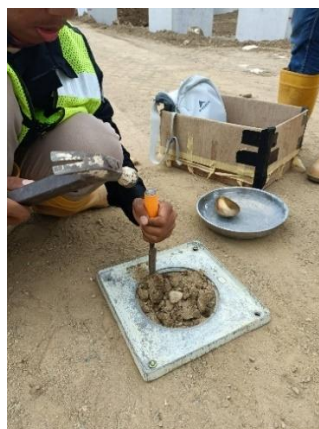
Gambar 7 10 Uji Sand Cone Lapangan
