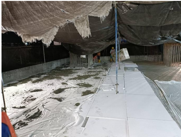
Gambar 5 21 Pemasangan Styrofoam dan Plastik
