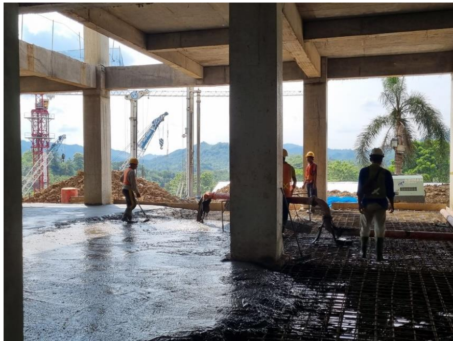
Gambar 4.61. Pengecoran pelat (Sumber : Dokumentasi pribadi)
