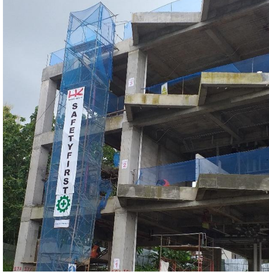
Gambar 3.24. Pemasangan safety net (Sumber : Dokumentasi pribadi)
