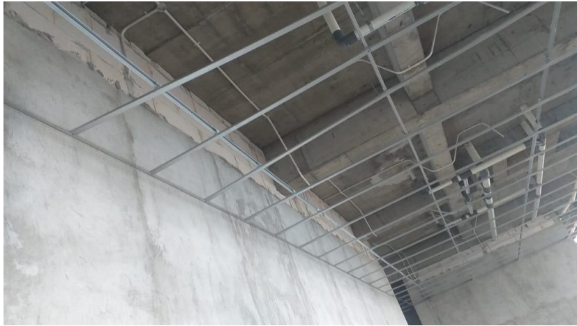
Gambar 4.79. Instalasi penggantung plafon pada struktur beton (Sumber : Dokumentasi pribadi)
