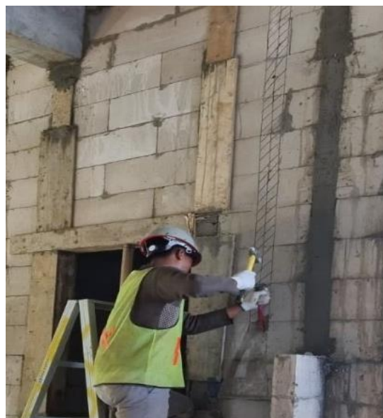
Gambar 4.76. Proses pembuatan coakan untuk instalasi listrik (Sumber : Dokumentasi pribadi)
