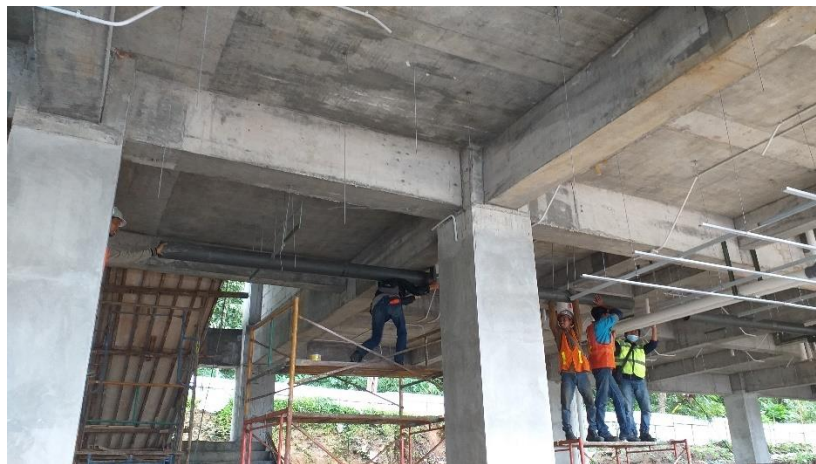
Gambar 4.75. Proses instalasi perpipaan atas (Sumber : Dokumentasi pribadi)
