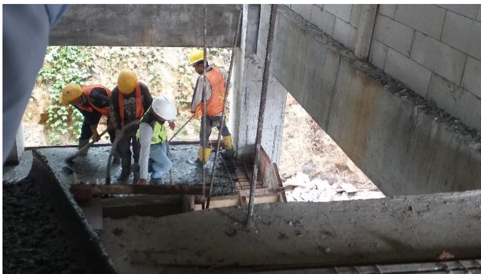
Gambar 4.57. Pengecoran tangga (Sumber : Dokumentasi pribadi)
