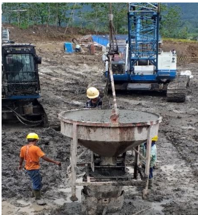
Gambar 4.42. Pengecoran bored pile (Sumber : Dokumentasi pribadi)
