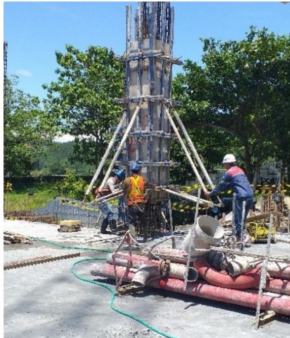
Gambar 4.50. Penurunan bekisting kolom (Sumber : Dokumentasi pribadi)
