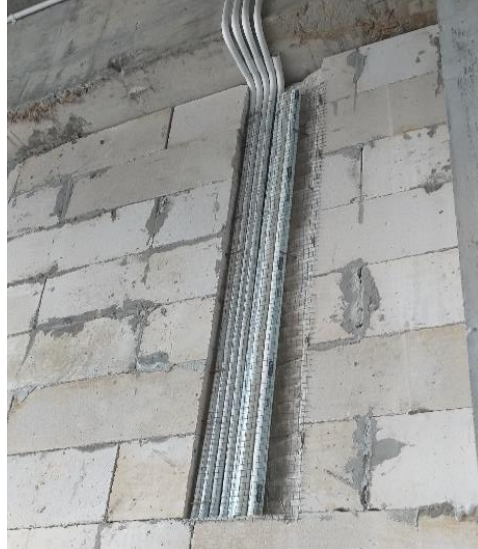
Gambar 4.77. Instalasi listrik (Sumber : Dokumentasi pribadi)
