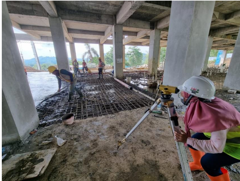
Gambar 4.62. Pengecekan elevasi pengecoran (Sumber : Dokumentasi pribadi)
