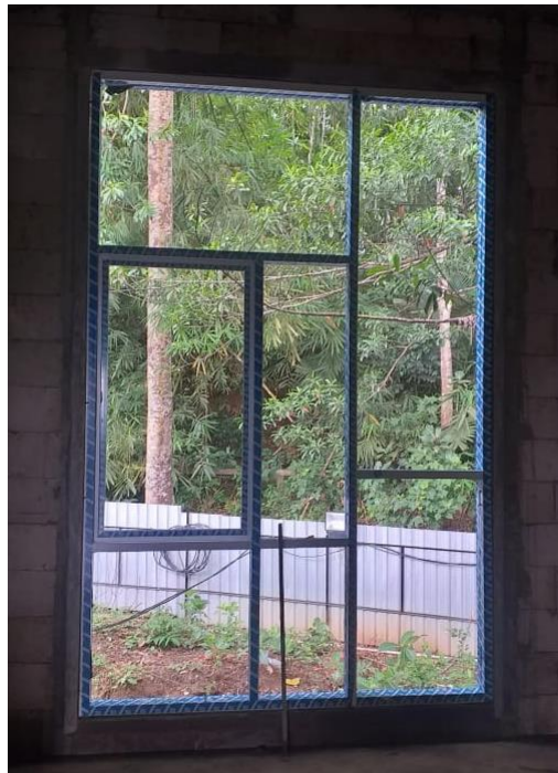
Gambar 4.72. Pemasangan kusen (Sumber : Dokumen pribadi)
