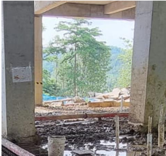
Gambar 4.74. Proses instalasi perpipaan bawah (Sumber : Dokumentasi pribadi)
