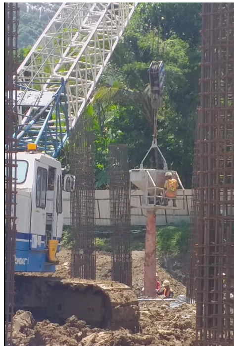
Gambar 4.44. Pengecoran pile cap (Sumber : Dokumentasi pribadi)
