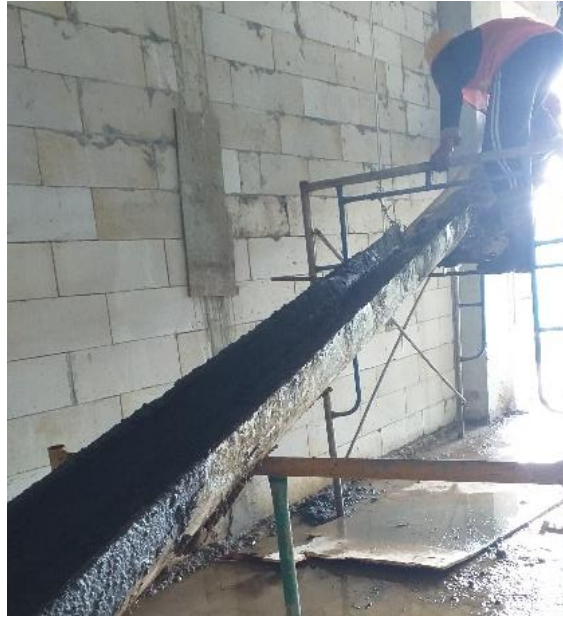
Gambar 4.58. Penyaluran campuran beton (Sumber : Dokumentasi pribadi)
