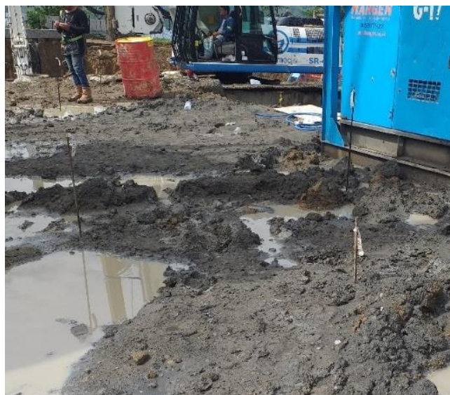
Gambar 4.36. Penandaan titik bored pile (Sumber : Dokumentasi pribadi)
