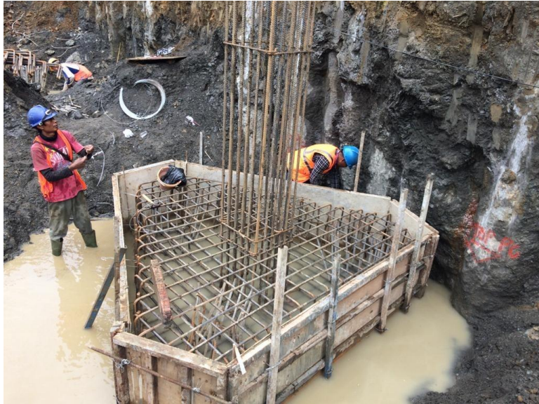
Gambar 4.43. Pemasangan bekisting pile cap (Sumber : Dokumentasi pribadi)
