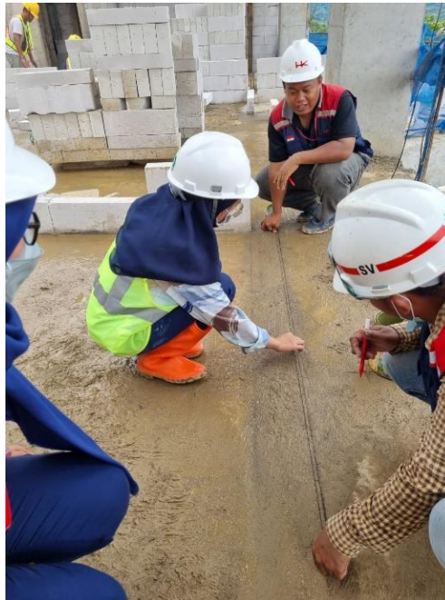
Gambar 4.68. Marking pasangan hebel beserta finishingnya (Sumber : Dokumentasi pribadi)
