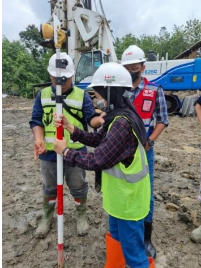
Gambar 4.35. Penentuan titik bored pile menggunakan tongkat prisma (Sumber : Dokumentasi pribadi)
