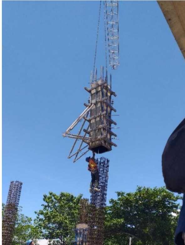
Gambar 4.49. Pengangkatan bekisting kolom (Sumber : Dokumentasi pribadi)
