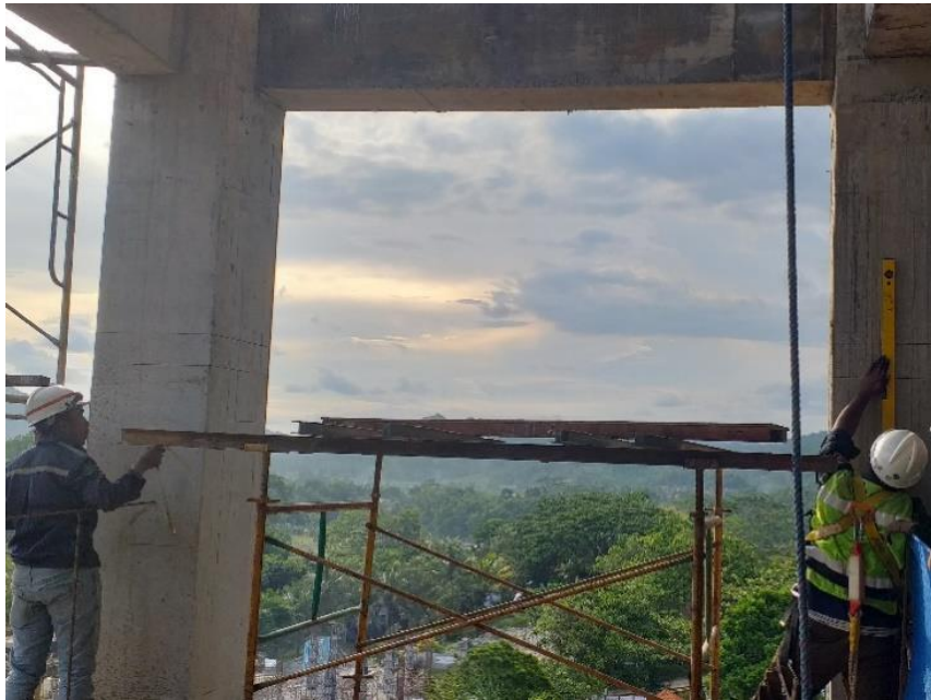
Gambar 4.54. Marking balok bordes tangga (Sumber : Dokumentasi pribadi)
