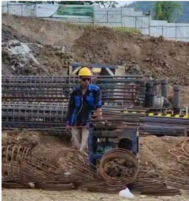
Gambar 4.37. Proses bar bending sengkang spiral (Sumber : Dokumentasi pribadi)
