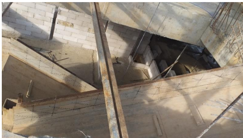
Gambar 4.53. Marking bekisting anak tangga (Sumber : Dokumentasi pribadi)
