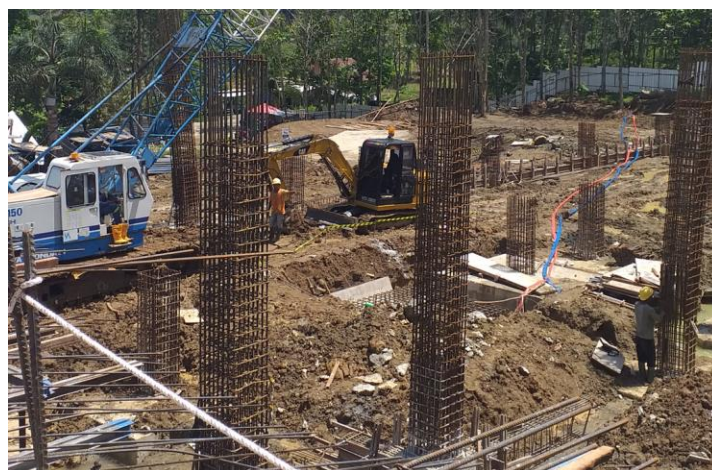
Gambar 4.46. Pembesian kolom gedung dormitory (Sumber : Dokumentasi pribadi)
