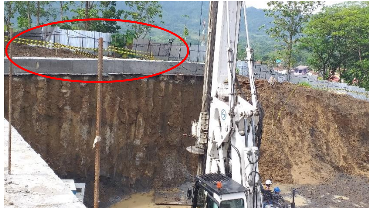
Gambar 3.23. Pemasangan safety line (Sumber : Dokumentasi pribadi)
