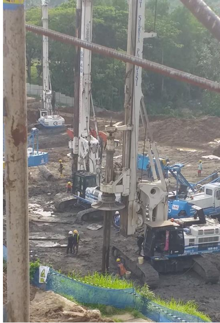
Gambar 4.39. Proses pengeboran bored pile (Sumber : Dokumentasi pribadi)
