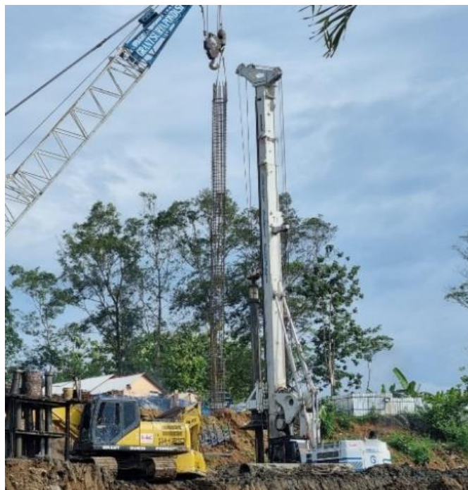
Gambar 4.40. Instalasi tulangan bored pile (Sumber : Dokumentasi pribadi)
