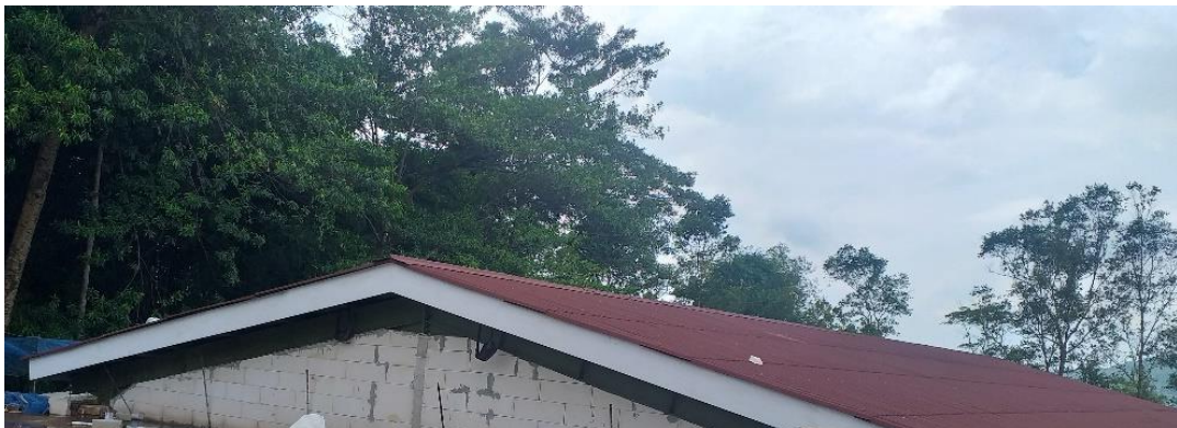
Gambar 4.67. Penutup atap dormitory (Sumber : Dokumentasi pribadi)
