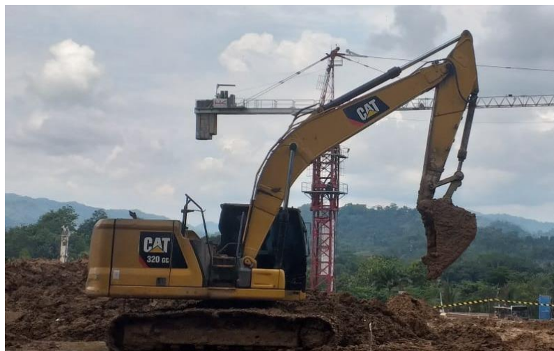
Gambar 4.82. Excavator Catterpillar (Sumber : Dokumentasi pribadi)
