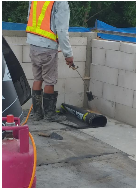
Gambar 4.80. Pemasangan waterproofing (Sumber : Dokumentasi pribadi)
