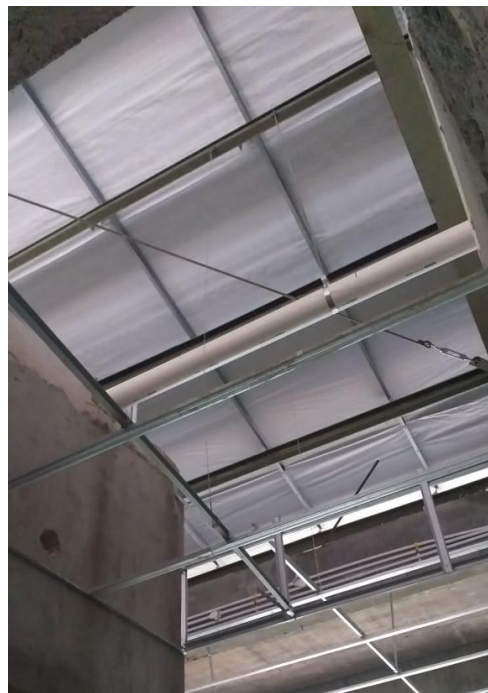
Gambar 4.78. Instalasi penggantung plafon pada struktur baja (Sumber : Dokumentasi pribadi)
