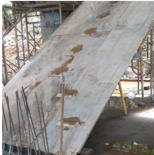
Gambar 4.52. Marking bekisting tepi tangga (Sumber : Dokumentasi pribadi)
