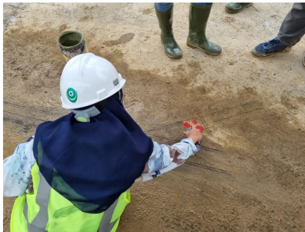
Gambar 4.69. Marking kolom praktis (Sumber : Dokumentasi pribadi)
