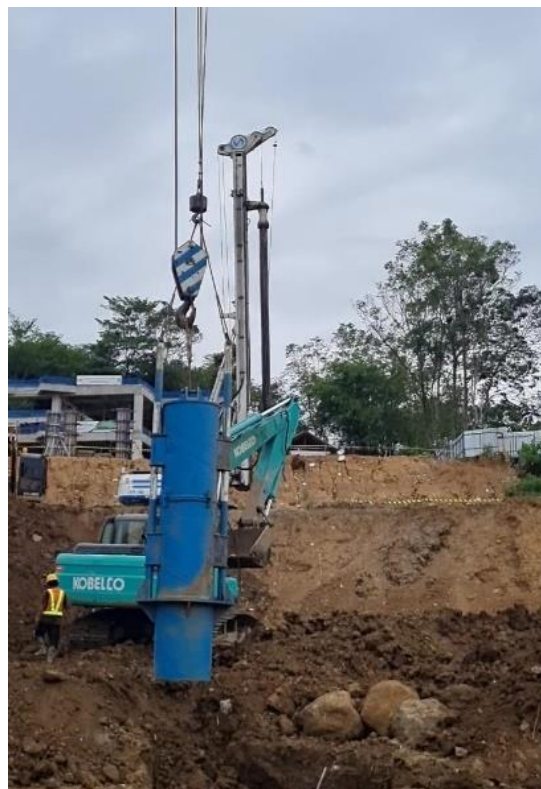
Gambar 4.30. Proses tes PDA (Sumber : Dokumentasi pribadi)
