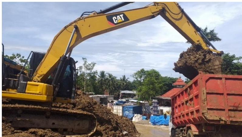
Gambar 4.32. Proses pekerjaan buangan tanah (Sumber : Dokumentasi pribadi)
