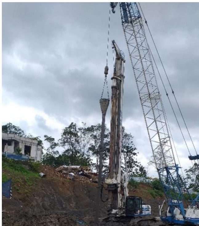
Gambar 4.41. Instalasi pipa tremie (Sumber : Dokumentasi pribadi)
