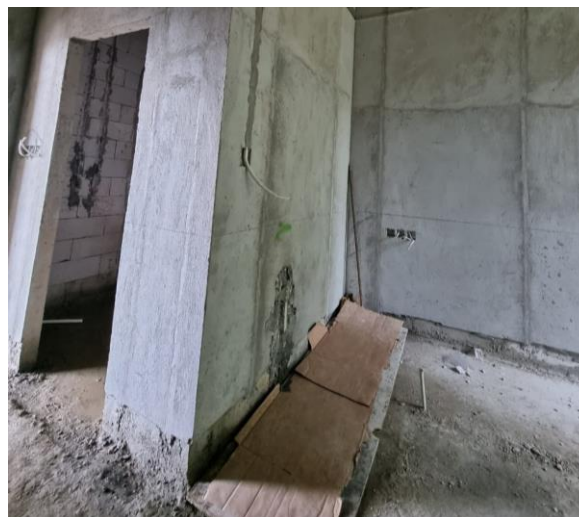
Gambar 4.71. Pekerjaan plesteran dinding (Sumber : Dokumentasi pribadi)
