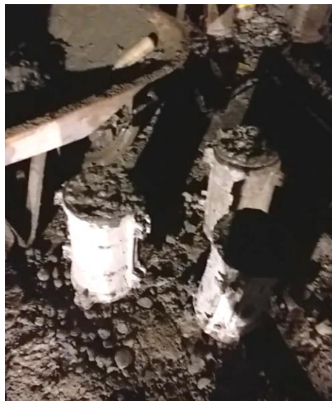
Gambar 4.34. Pembuatan benda uji beton (Sumber : Dokumentasi pribadi)
