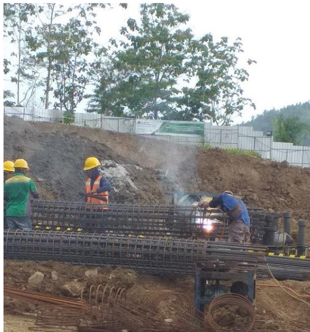
Gambar 4.38. Proses pengelasan sengkang bored pile (Sumber : Dokumentasi pribadi)
