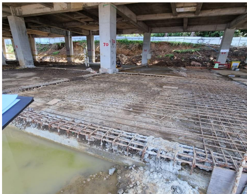
Gambar 4.59. Pengecekan pembesian pelat lantai (Sumber : Dokumen pribadi)
