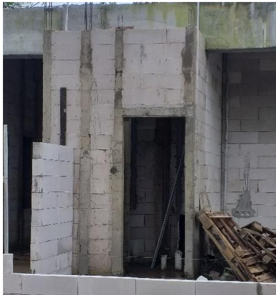
Gambar 4.70. Pasangan bata ringan, kolom praktis, dan opening (Sumber : Dokumentasi pribadi)
