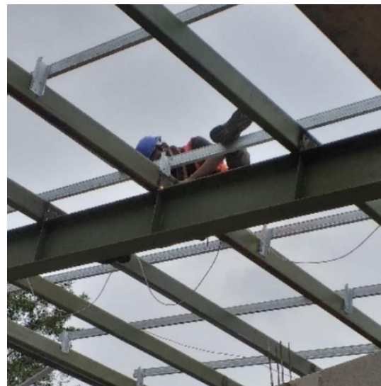
Gambar 4.65. Pengelasan sambungan gording (Sumber: Dokumentasi pribadi)
