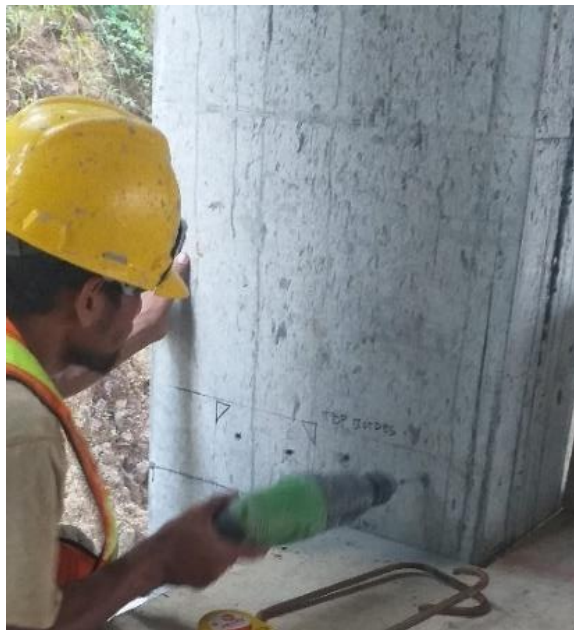
Gambar 4.55. Pengeboran tulangan balok bordes (Sumber : Dokumentasi pribadi)
