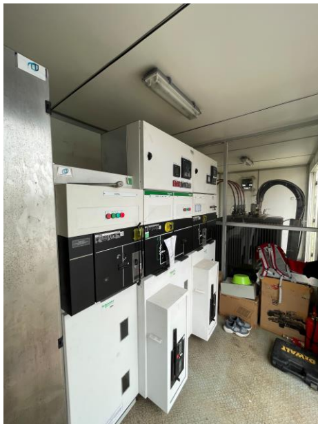
Fig. 3. 3 Cubikel IM 630A/16KA & Cubikel DM1-W 630A/16KA
