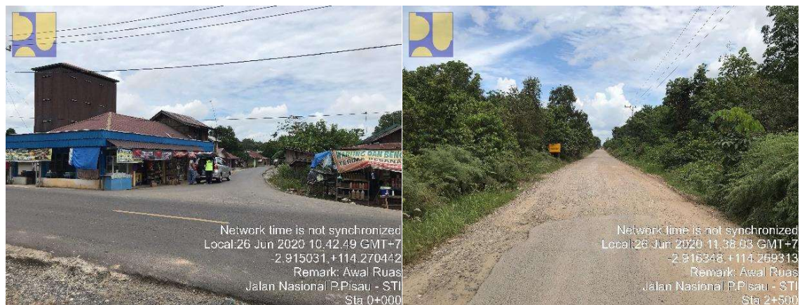
Gambar 1.5. Titik awal Ruas Sp.3 Janas – STI (Sta. 0+000) dan akhir jalan aspal satu lapis (Sta. 2+450) (KPIJ Balai Pelaksanaan Jalan Nasional Prov. Kalimantan Tengah, 2020)
