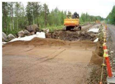
Gambar 2.7 Metode pengelupasan tanah gambut (Ma'ruf & Yulianto, 2016)
