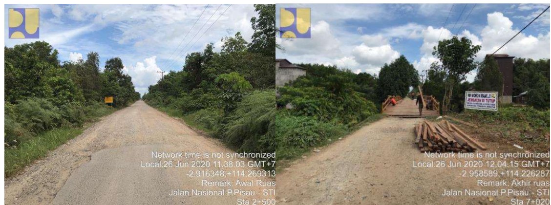
Gambar 1.6 Titik awal jalan agregat, Ruas Sp.3 Janas – STI (Sta. 2+450) dan akhir dari jalan agregat (Sta. 6+895) (KPIJ Balai Pelaksanaan Jalan Nasional Prov. Kalimantan Tengah, 2020)
