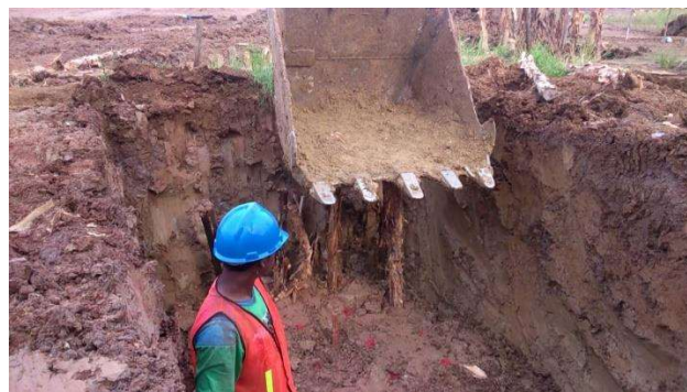
Gambar 2.10 Penggunaan kayu galam sebagai pondasi pada gambut. (Video Pekerjaan pondasi cerucuk dolken https://www.youtube.com/watch?v=8Rg3CW_sgOs ; 2016)
