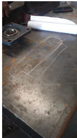
Gambar 19 Proses Marking Pada Proses Fabrikasi
