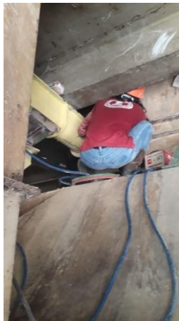
Gambar 33 Assembling Screw Conveyor pada Bucket Elevator
