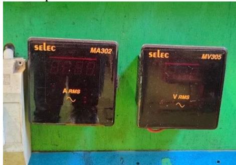
**Gambar 3. 6 Amperemeter dan Voltmeter**
