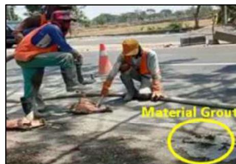
**Gambar 1.5** Sebaran material *grouting* menyembur ke lubang pipa terdekat dan
