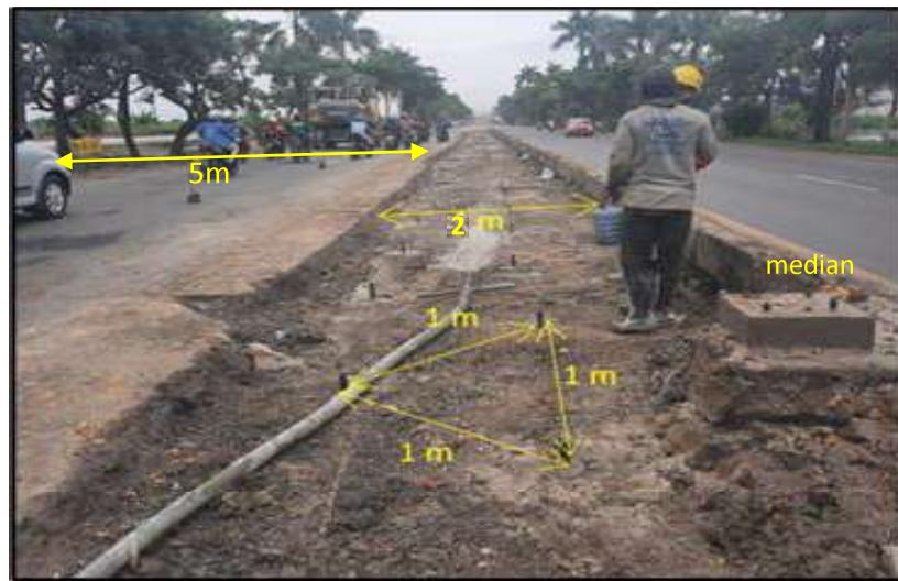
**Gambar 1.4** Penentuan Titik Lubang *Grouting*
