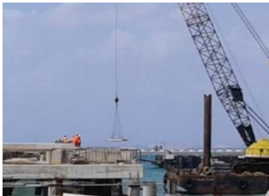
Gambar 3.6 Pemasangan Precast Slab
