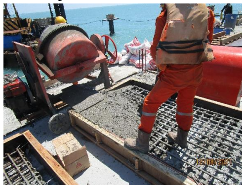
Gambar 3.17 Dokumentasi Pouring Beton
