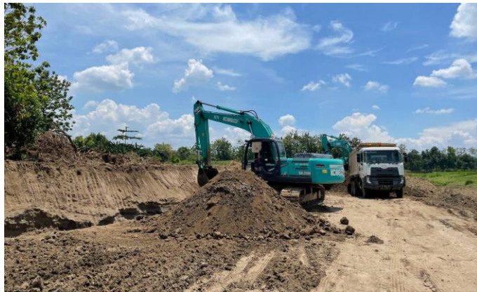
Gambar 4. 3 EXC 46 Kobelco SK 200 (Sumber: Dokumentasi Pribadi)
