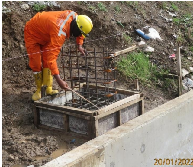
Gambar 3.21 Pemasangan Bekisting
