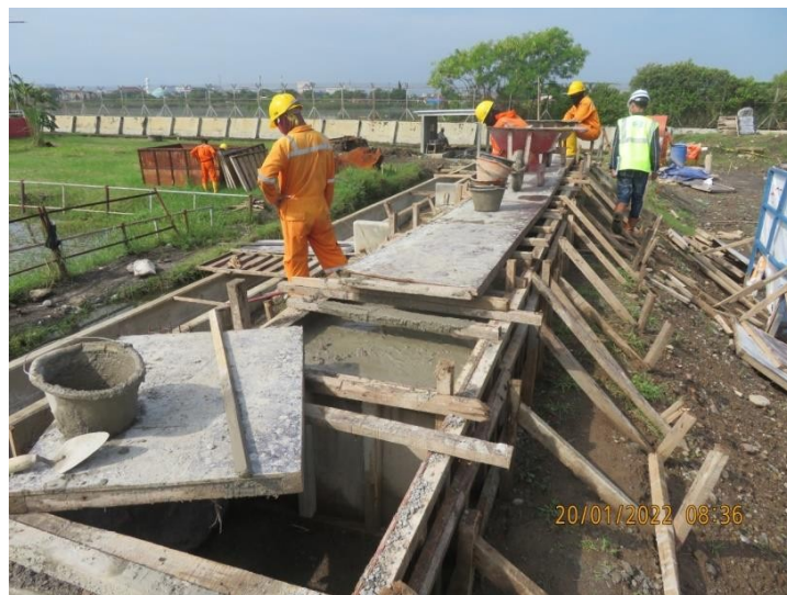
Gambar 3.9 Pemasangan Bekisting
