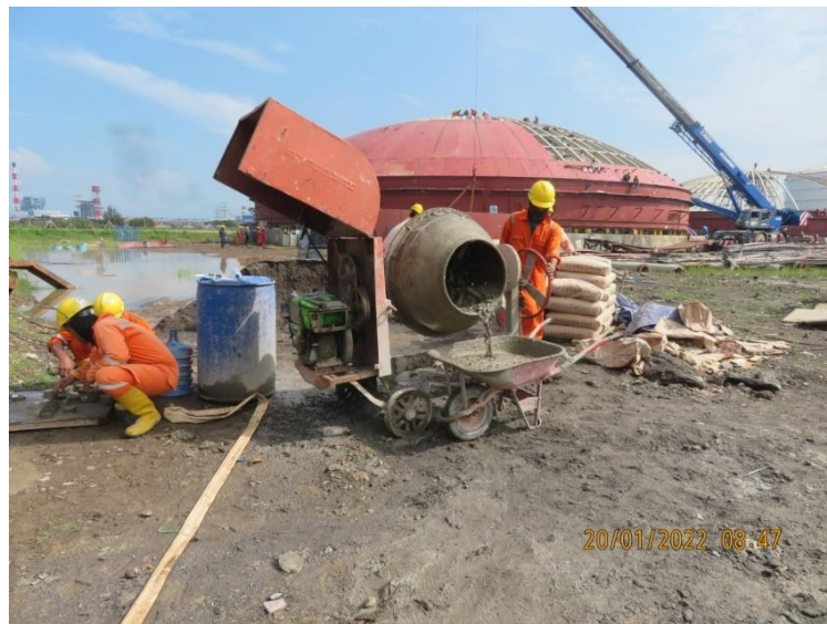
Gambar 3.11 Pengangkutan Campuran Beton
