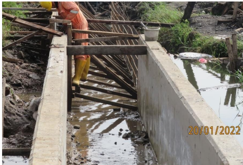
Gambar 3.30 Saluran Drainase Selesai Di Cor
