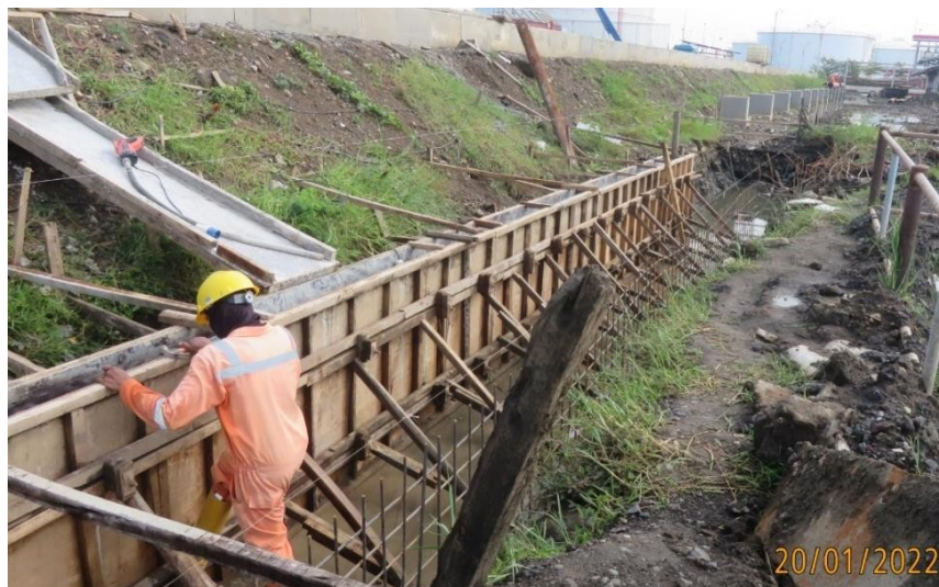
Gambar 3.28 Pemasangan Bekisting Saluran Drainase
