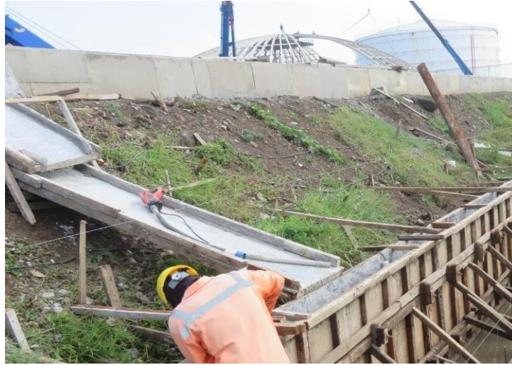
Gambar 3.29 Proses Pengecoran Saluran Drainase
