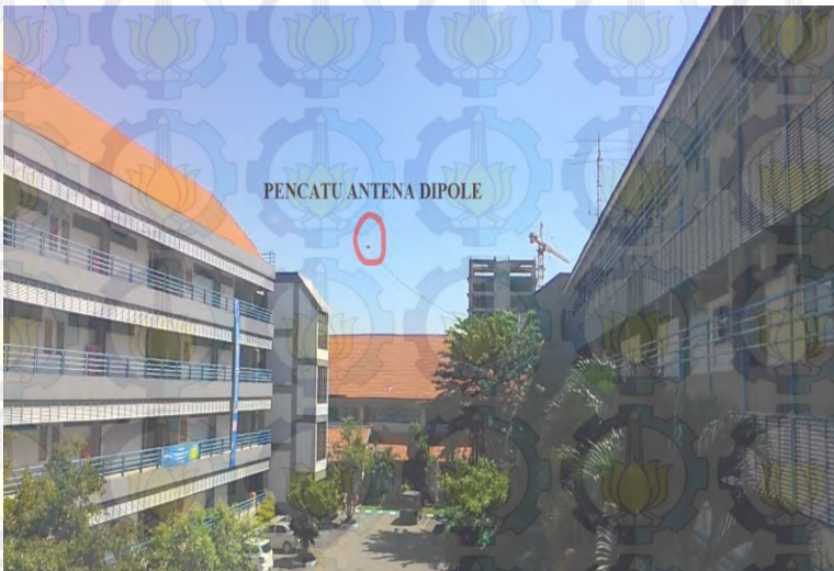
Gambar 4.1 Lokasi Antena di Jurusan Teknik Elektro ITS
