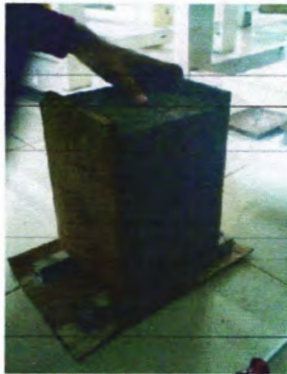
Gambar 4.33 pembukaan bekisting
