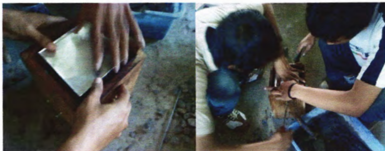
Gambar 4.30 proses penempatan box alluminium dalam bekisting
