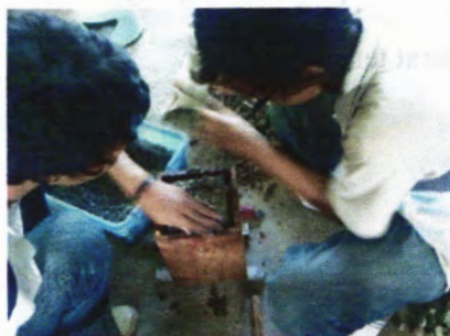
Gambar 4.31 proses pemasangan beton ke dalam bekisting yang terisi alluminium
