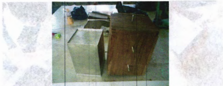
Gambar 4.27 box aluminium yang ditanam dalam beton dan bekisting pemberat terapung
