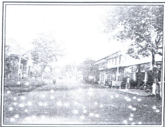
Ruas Jalan Wonoayu – Krian
