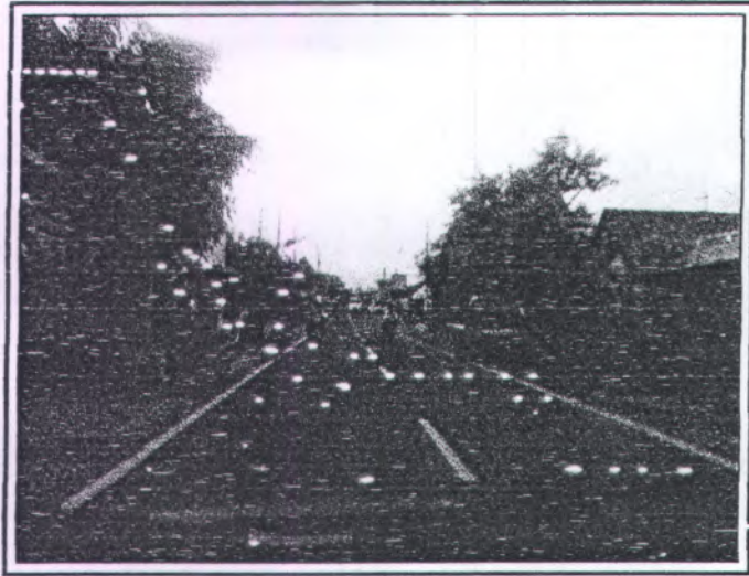
Ruas Jalan Tanggulangin – Tulangan
