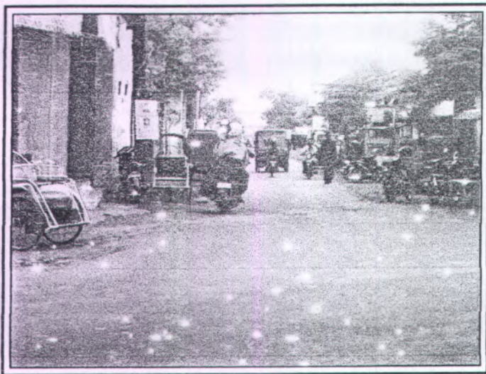
Ruas Jalan Wonoayu – Jedongcangkring
