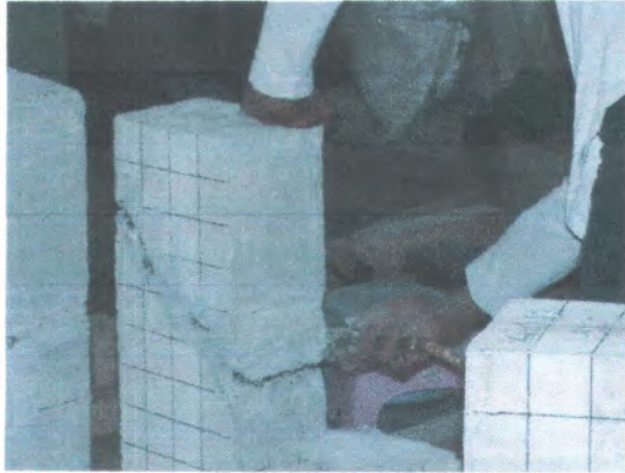
Foto Proses Pembersihan dan Memperlebar jalur retakan
