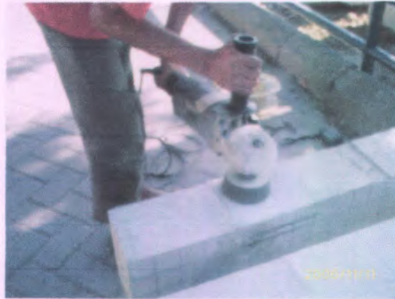
Foto Penghalusan Permukaan Balok Sebelum Pengujian Third Point Loading Test
