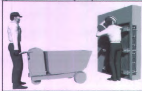
Gambar 2.12 Repair Dengan Metode Form and Pour Techniques
