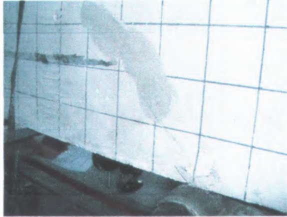
Foto Retak yang Terjadi Setelah Pengujian
