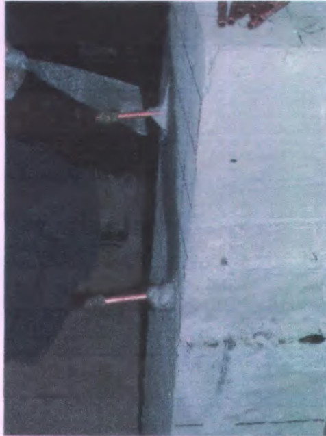
Foto Penutupan Jalur Retakan dan Pemasangan Nipple Injeksi
