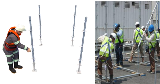
Gambar 3.8 Pemasangan standar diatas jack base
