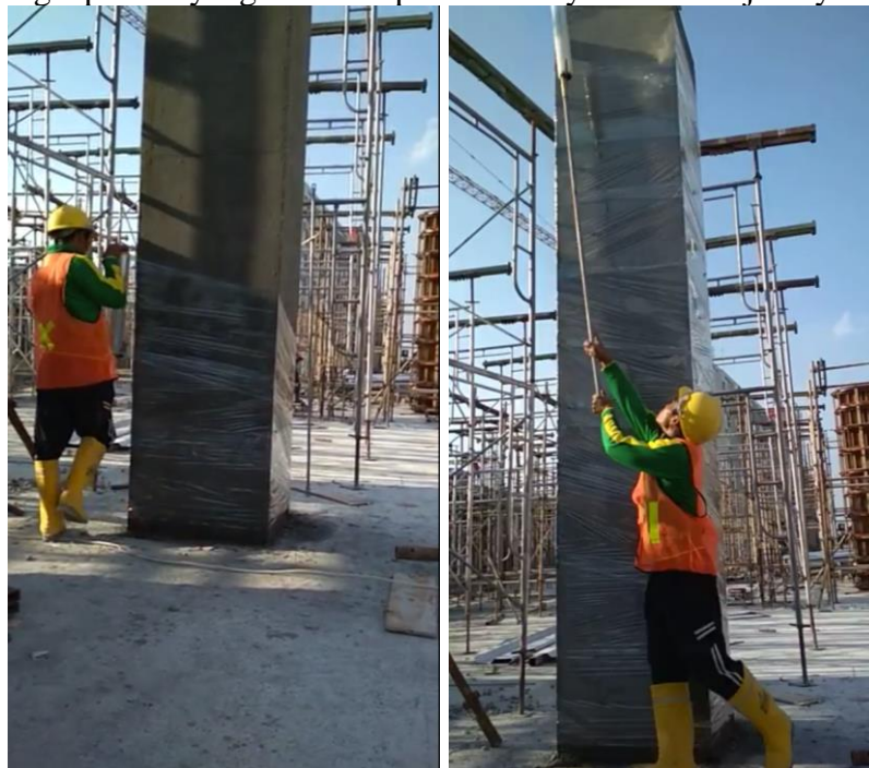
Gambar 3.31 Pekerjaan curing kolom
