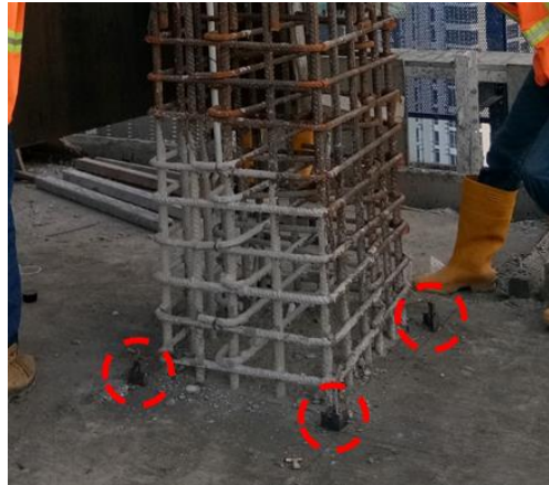
Gambar 3.26 Pemasangan sepatu kolom
