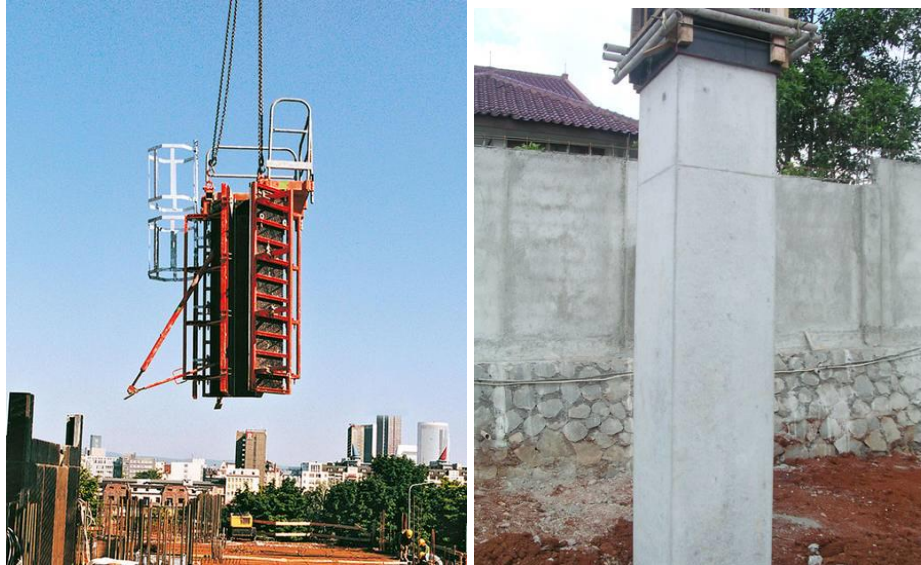
Gambar 3.30 Pengangkatan kolom setelah selesai cor
