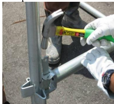
Gambar 3.3 Pemasangan toe board clip untuk menyambung prop dengan ledger
