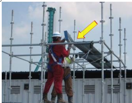
Gambar 3.22 Pemasangan steel plank untuk pekerjaan pembongkaran
