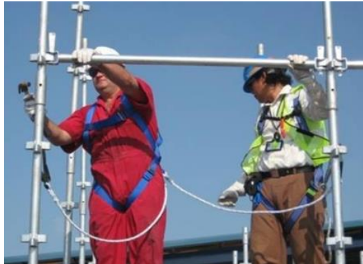
Gambar 3.4 Pemasangan ledger atas
