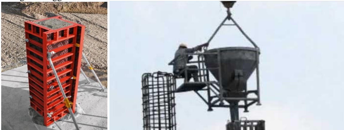
Gambar 3.29 Pengecoran kolom dengan bucket cor
