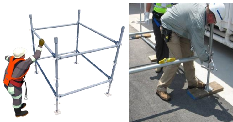
Gambar 3.9 Pemasangan ledger sebagai pengaku standar
