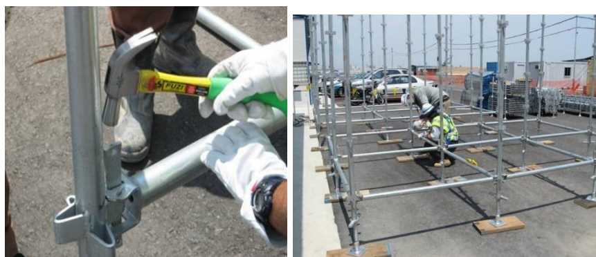
Gambar 3.10 Pemasangan baji pada pertemuan ledger dan standar
