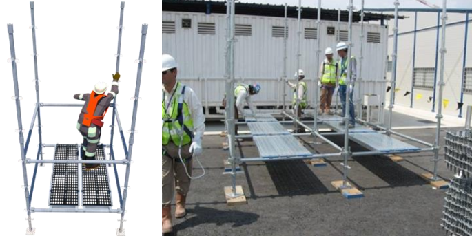
Gambar 3.14 Pemasangan ledger untuk lapisan kedua dan seterusnya
