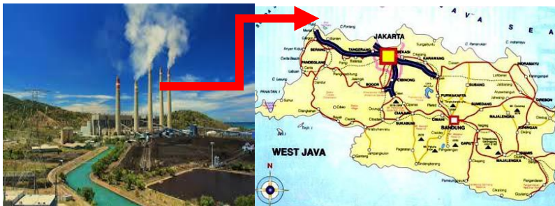
Gambar 2.2 Lokasi PLTU Suralaya
