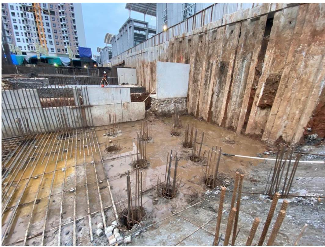
Gambar 4.11 Foto Spun Pile di bawah Raft Foundation
