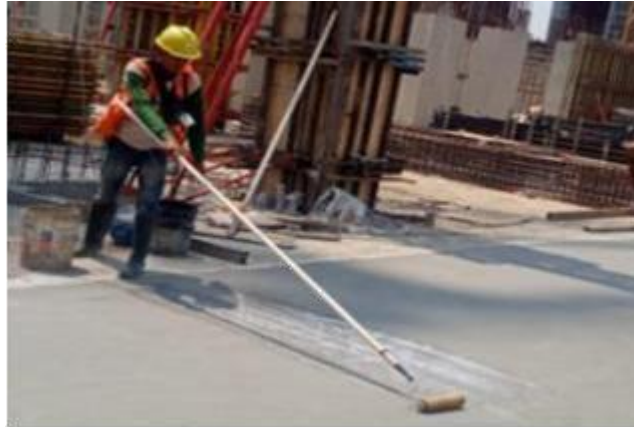
Gambar 2.58 Pekerjaan Curing Beton
