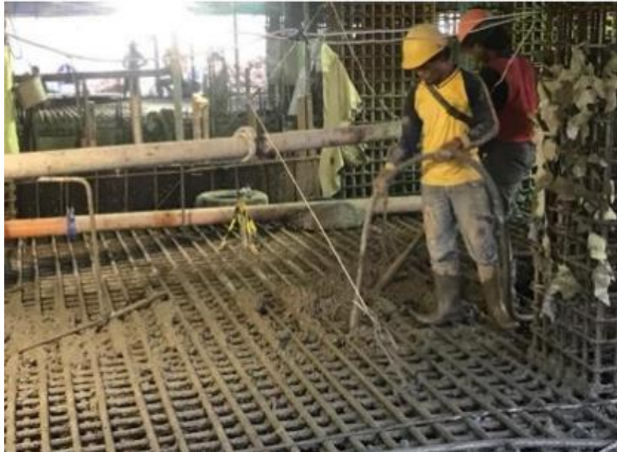
Gambar 2.55 Alat Bantu Cor dengan Vibrator
