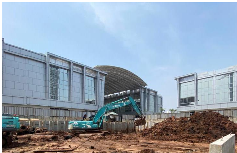
Gambar 2.3 Pengangkutan Material Galian dengan Excavator
