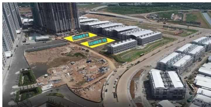
Gambar 1.2 Kondisi Proyek Apartemen Tokyo Riverside Tower 9 dan 10
