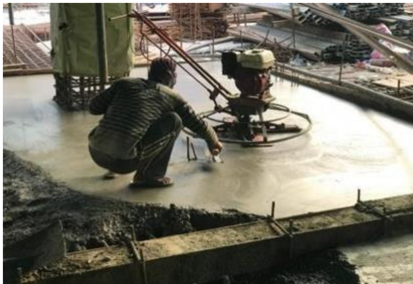
Gambar 2.56 Perataan Beton dengan Mesin Trowel
