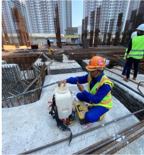
Gambar 2.12 Pencampuran Obat Anti Rayap
