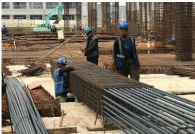
Gambar 2.22 Fabrikasi Menjadi Kolom atau Shear Wall
