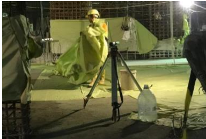
Gambar 2.57 Pengecekan Level Ketinggian dengan Theodolite
