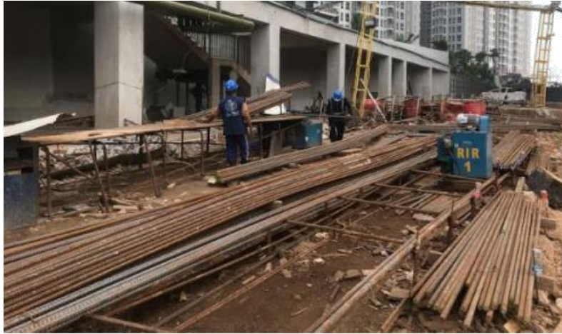
Gambar 2.21 Lokasi Pemotongan dan Pembengkokan Besi
