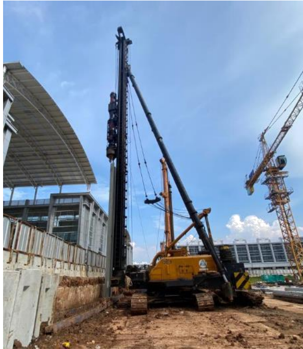
Gambar 2.8 Pemancangan Sheet Pile
