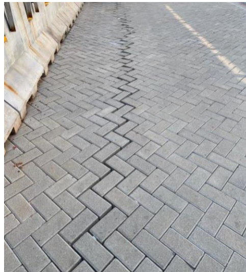
Gambar 3.6 Pergeseran Tanah pada Ruko
