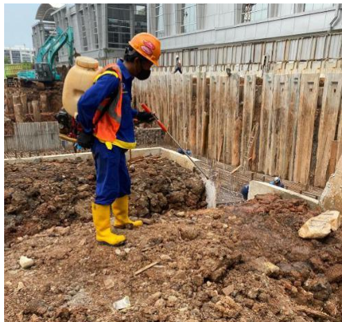
Gambar 2.13 Penyemprotan Anti Rayap
