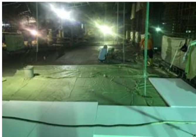
Gambar 2.59 Menutupi Lapisan Atas Beton dengan Plastik dan Styrofoam 2.12 Perawatan Beton
