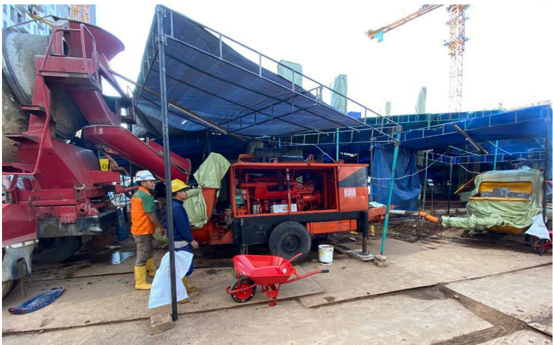
Gambar 2.54 Alat Bantu Cor Pompa Kodok
