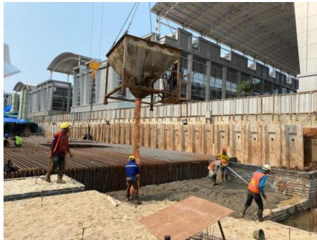
Gambar 2.19 Pengecoran Lantai Kerja dengan Bucket Cor
