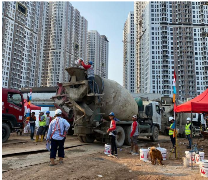
Gambar 2.52 Penyampuran Integral ke TM
