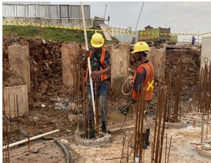
Gambar 3.3 Penyedotan Air Pada Spun Pile
