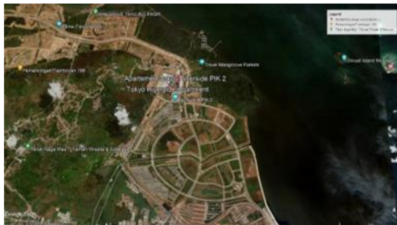
Gambar 1.1 Lokasi Proyek Pembangunan Apartment Tokyo Riverside PIK 2
