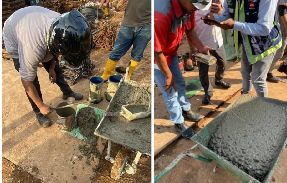
Gambar 2.50 Slump Test dan Uji Suhu
