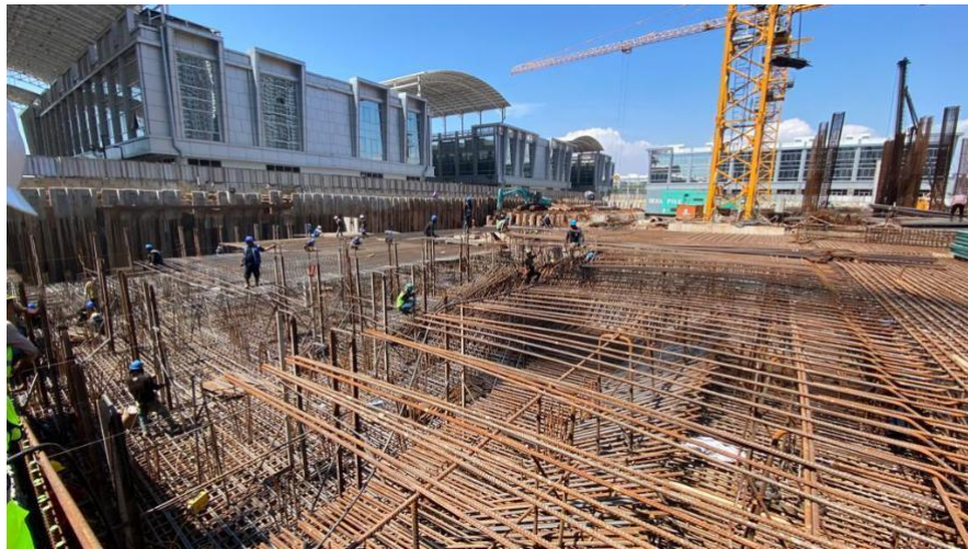
Gambar 2.28 Pekerjaan Pembesian Layer Atas
