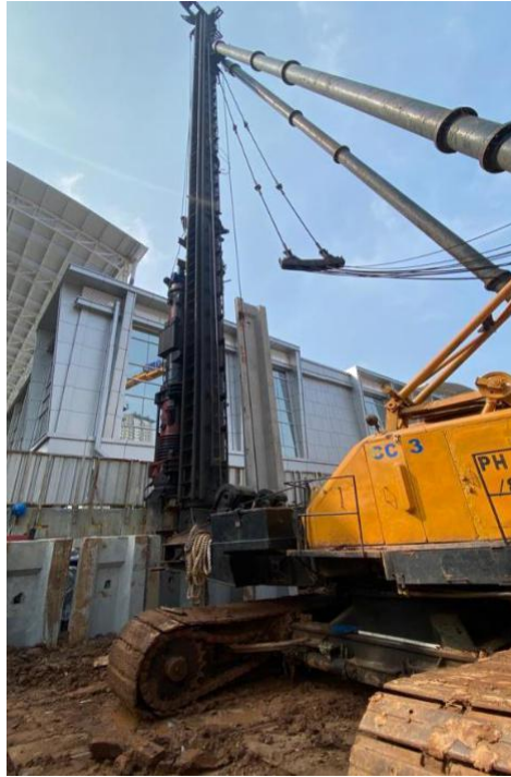
Gambar 3.7 Proses Pemasangan Sheet Pile
