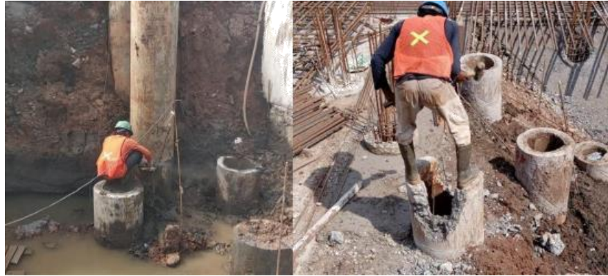
Gambar 2.5 Potong dan Bobok Spun Pile
