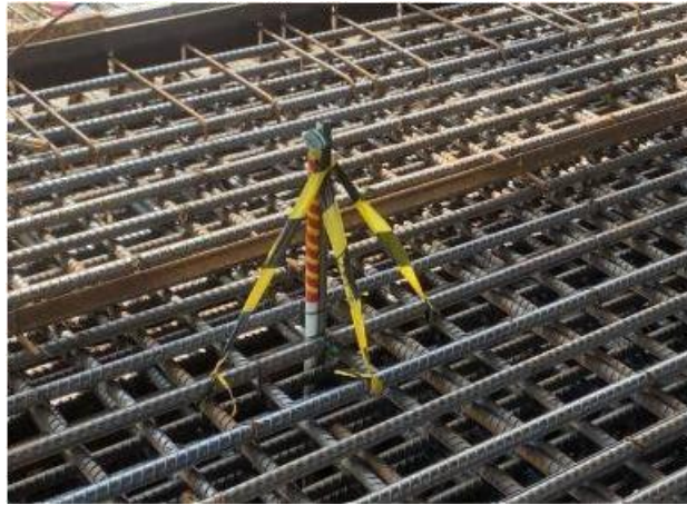
Gambar 2.41 Thermocouple yang Sudah Terpasang
