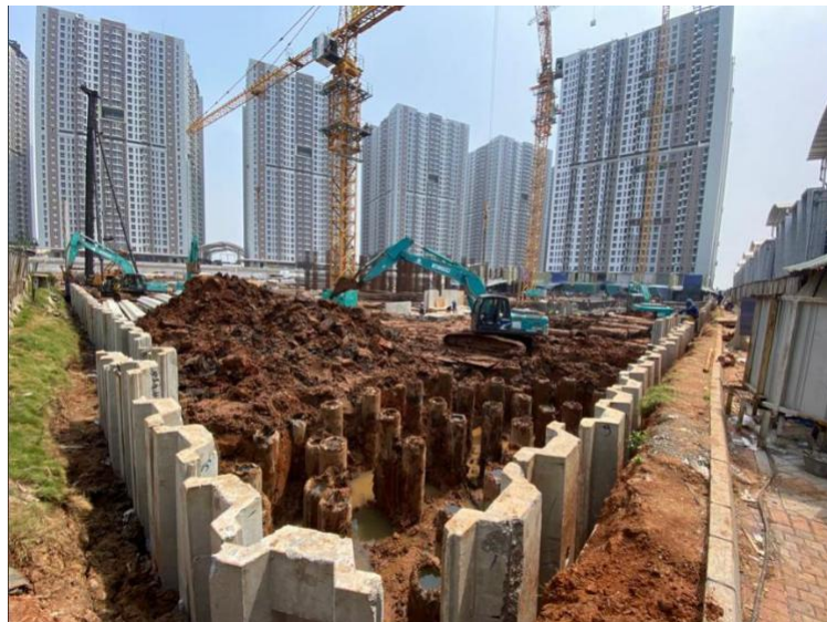
Gambar 2.9 Kondisi Setelah Dipasang Sheet Pile
