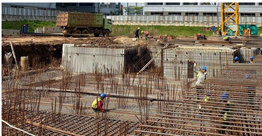
Gambar 2.26 Pekerjaan Pembesian Layer Bawah
