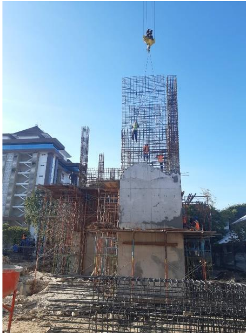
Gambar 3.19 Pekerjaan Pemasangan Tulangan Shear Wall
