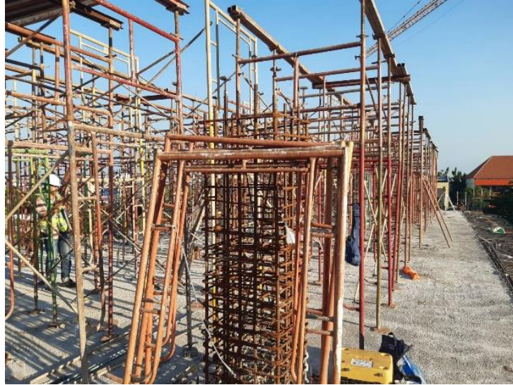
Gambar 3.7 Pemasangan dan Pembongkaran Scaffolding
