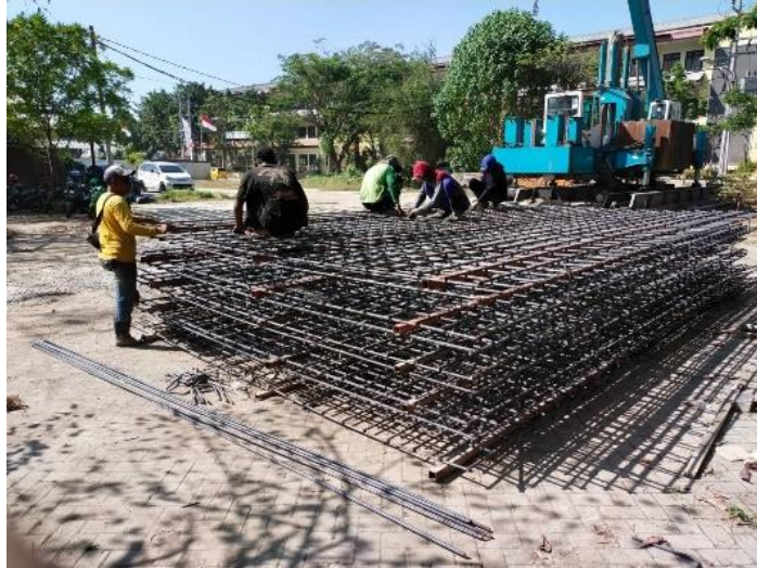
Gambar 3.17 Pekerjaan Penulangan Shear Wall
