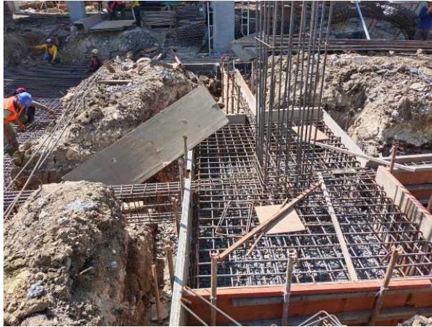
Gambar 3. 12 Pekerjaan Penempatan Tulangan dan Bekisting Pile Cap
