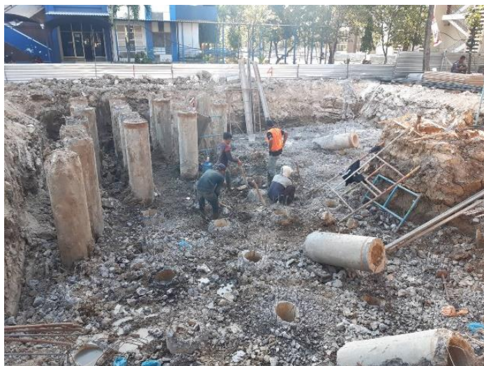
Gambar 3.6 Pekerjaan Pembobokan Tiang Pancang
