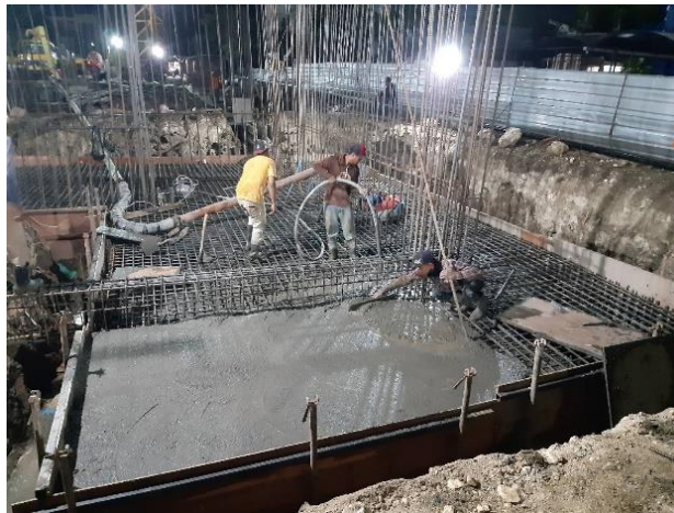
Gambar 3.13 Pekerjaan Pengecoran Pile Cap
