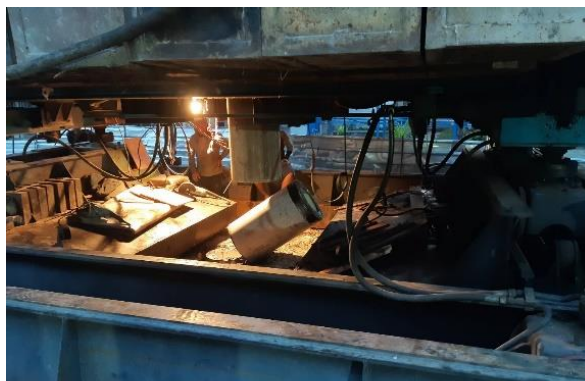
Gambar 3. 28 Pekerjaan Pemotongan Tiang Pancang yang Lebih
