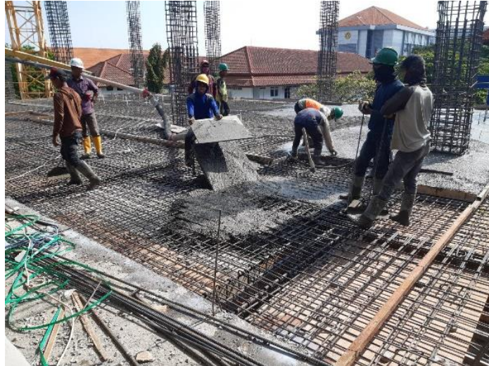
Gambar 3. 27 Pekerjaan Pengecoran Balok dan Pelat
