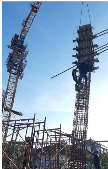
Gambar 3.8 Pemasangan dan Pembongkaran Bekisting
