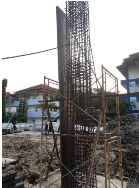
Gambar 3.31 Keadaan Kolom Sebelum Roboh
