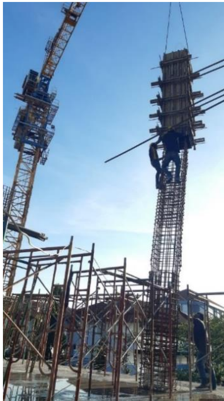
Gambar 3.23 Pekerjaan Pemasangan Tulangan dan Bekisting Kolom
