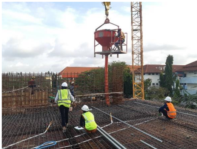
Gambar 3.20 Pekerjaan Pengecoran Shear Wall
