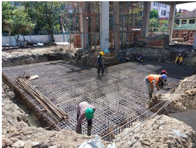
Gambar 3.10 Pekerjaan Penulangan Pile Cap
