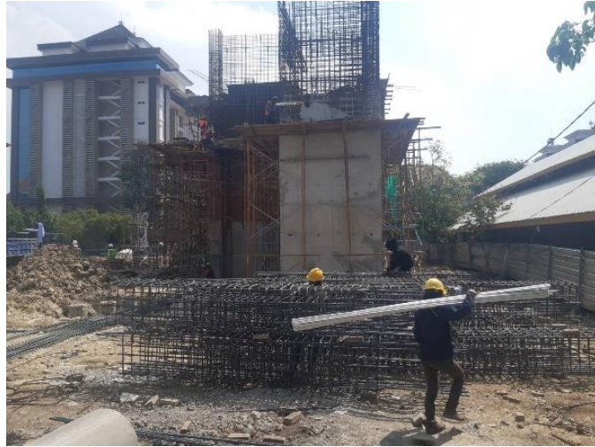
Gambar 3.22 Pekerjaan Penulangan Kolom
