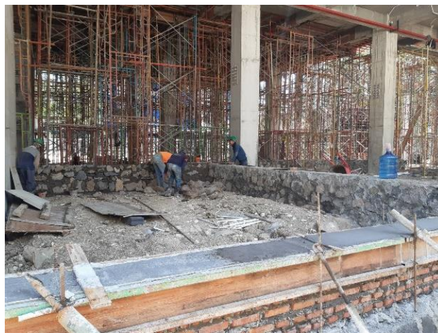
Gambar 3.15 Pekerjaan Pondasi Batu Kali
