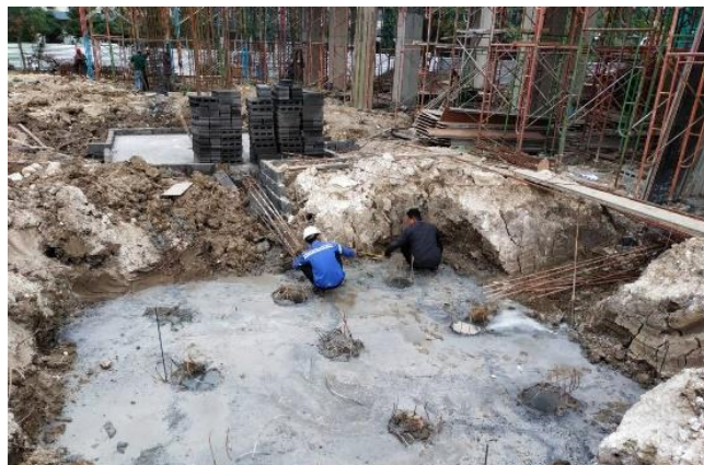
Gambar 3.11 Pekerjaan Lantai Kerja
