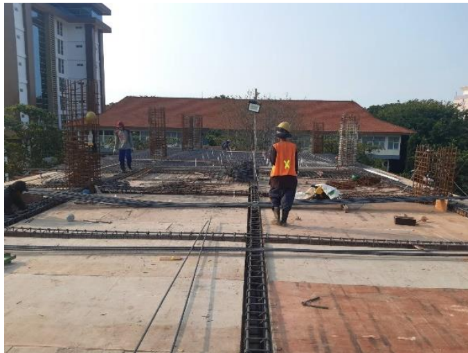
Gambar 3.26 Pekerjaan Pemasangan Tulangan dan Bekisting Balok dan Pelat
