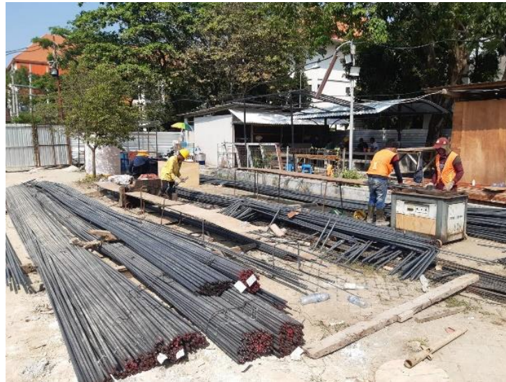
Gambar 3.29 Tulangan Baja Proyek
