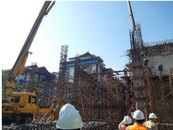
Gambar 3.24 Pekerjaan Pengecoran Kolom
