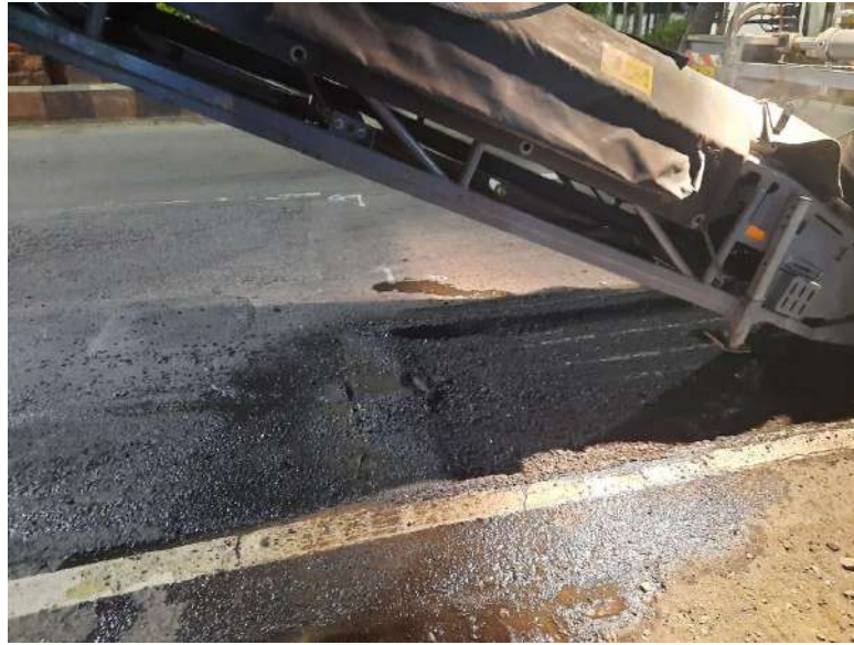
Gambar 3. 12 Pekerjaan Pembongkaran Jalan Menggunakan CMM
