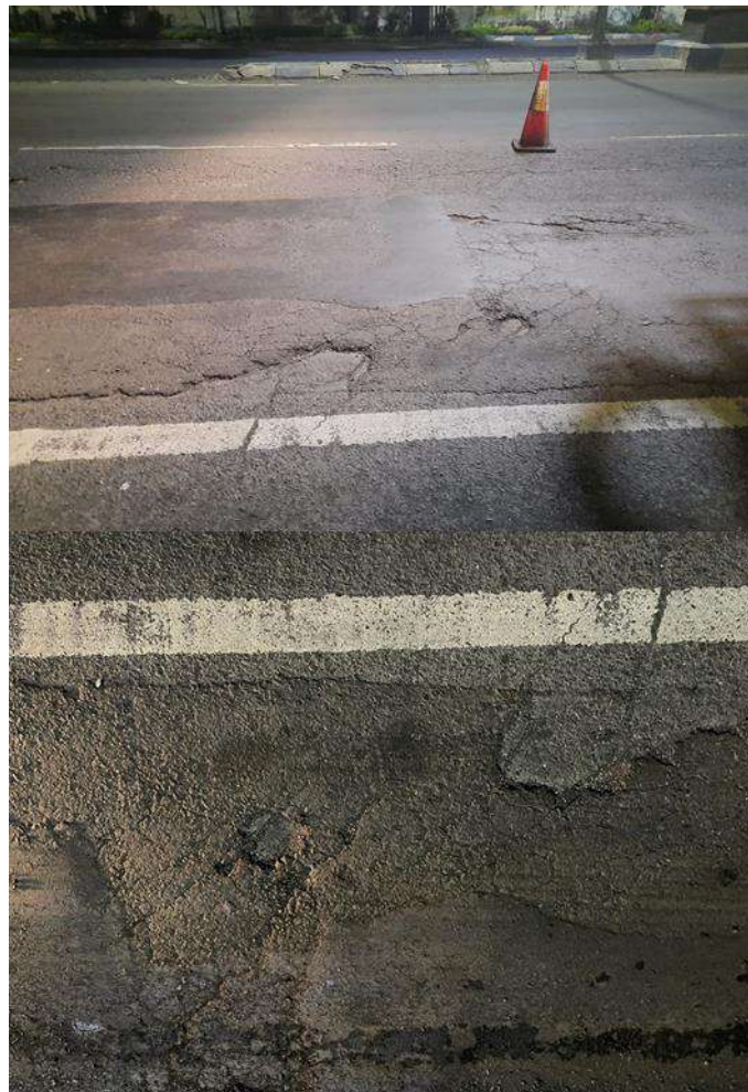
Gambar 3. 10 Kondisi Eksisting Sebelum Pekerjaan Pengaspalan pada Jalan P. Sudirman Probolinggo
