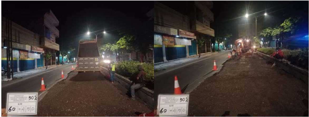
Gambar 3. 14 Pekerjaan Penghamparan Agregat Kelas A pada KM 60+450
