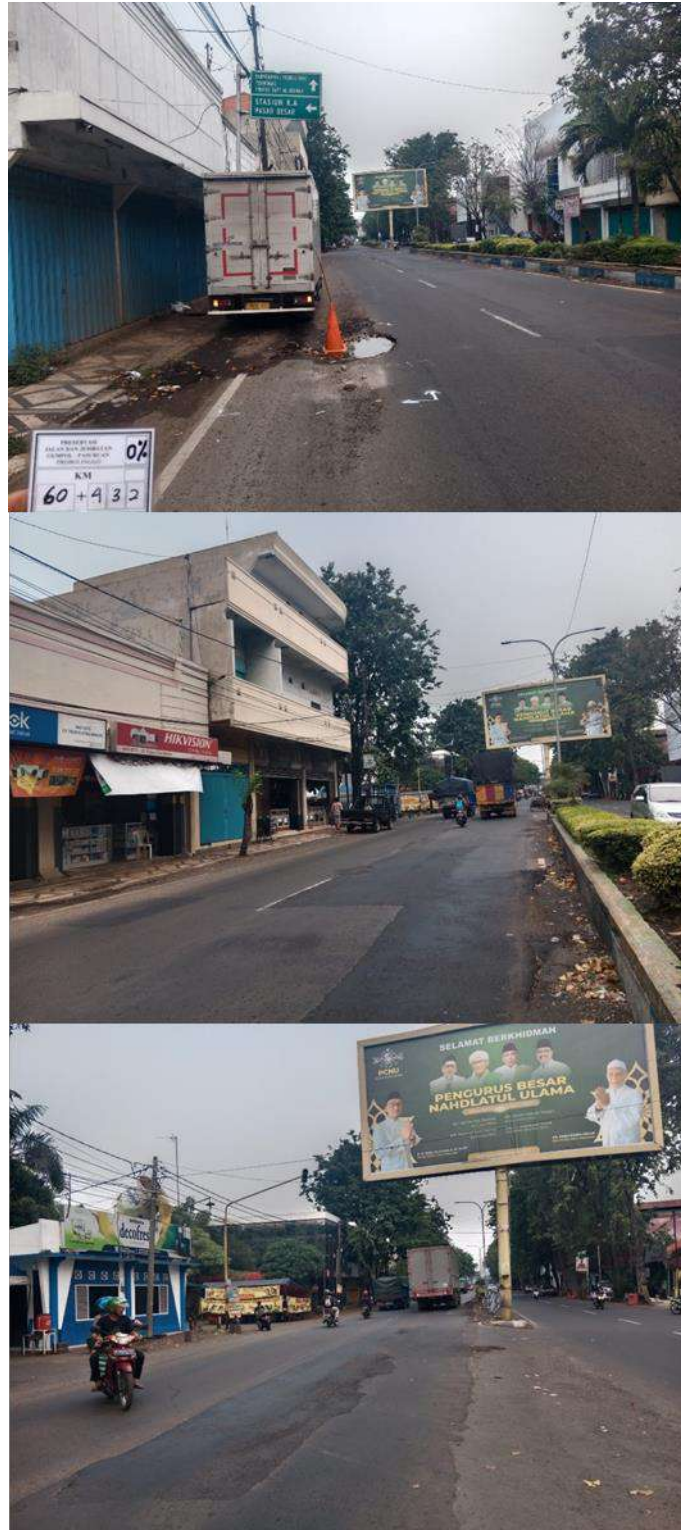
Gambar 3. 8 Kondisi Eksisting Sebelum Pekerjaan Pengaspalan pada KM 6+432
