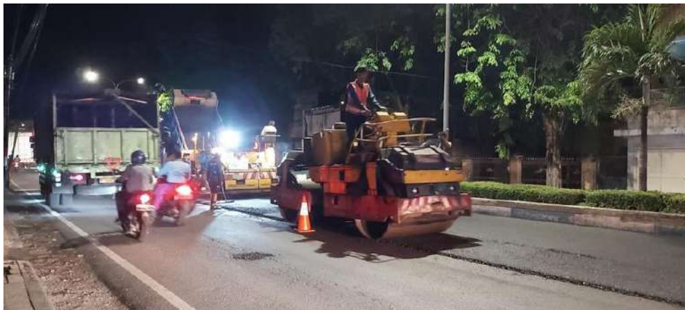
Gambar 3. 19 Pemasatan Aspal Menggunakan Tandem Roller
