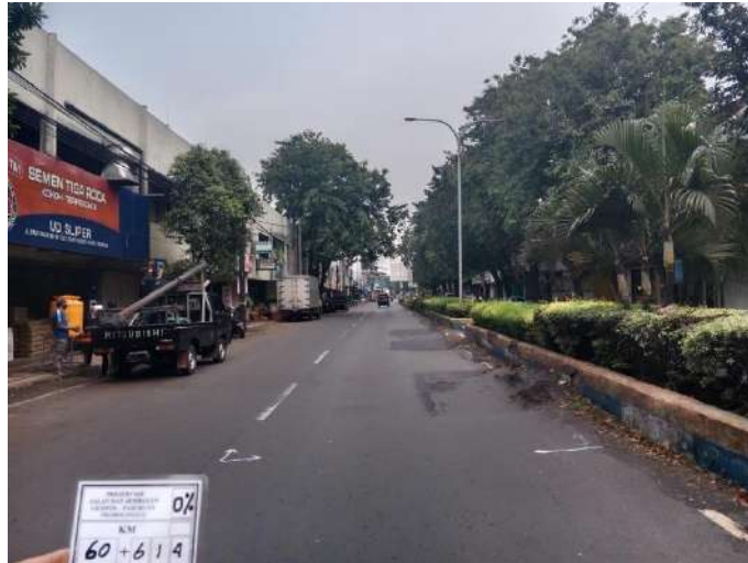
Gambar 3. 9 Kondisi Eksisting Sebelum Pekerjaan Pengaspalan pada KM 6+614
