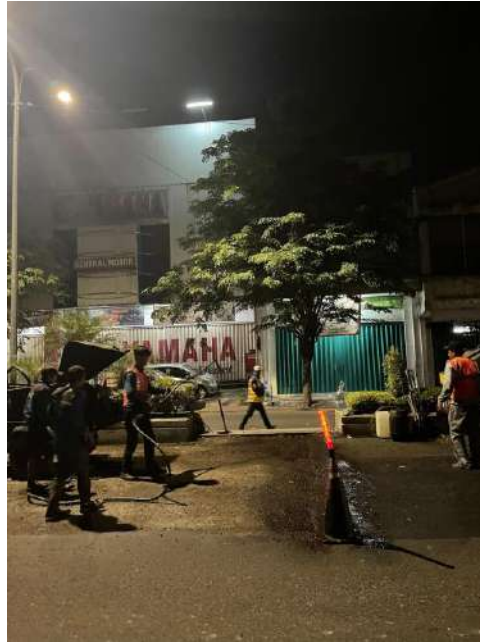
Gambar 3. 16 Penyemprotan Prime Coat di Lapangan
