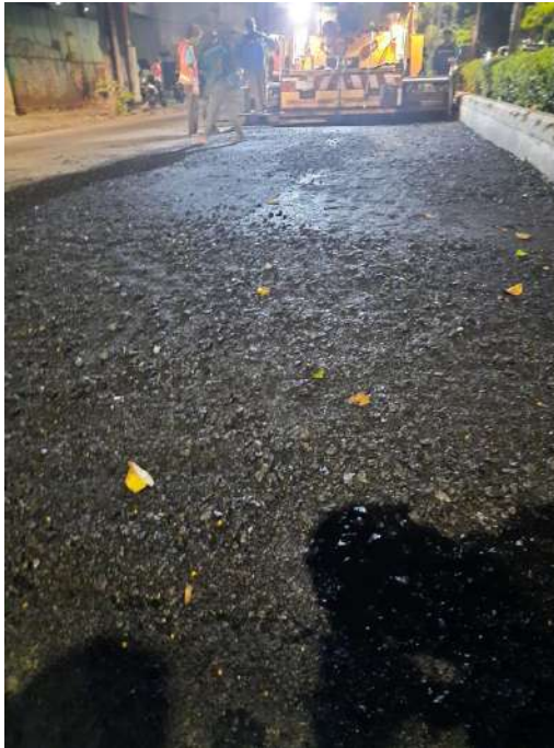
Gambar 3. 18 Persiapan Coating Sebelum Penghamparan Aspal
