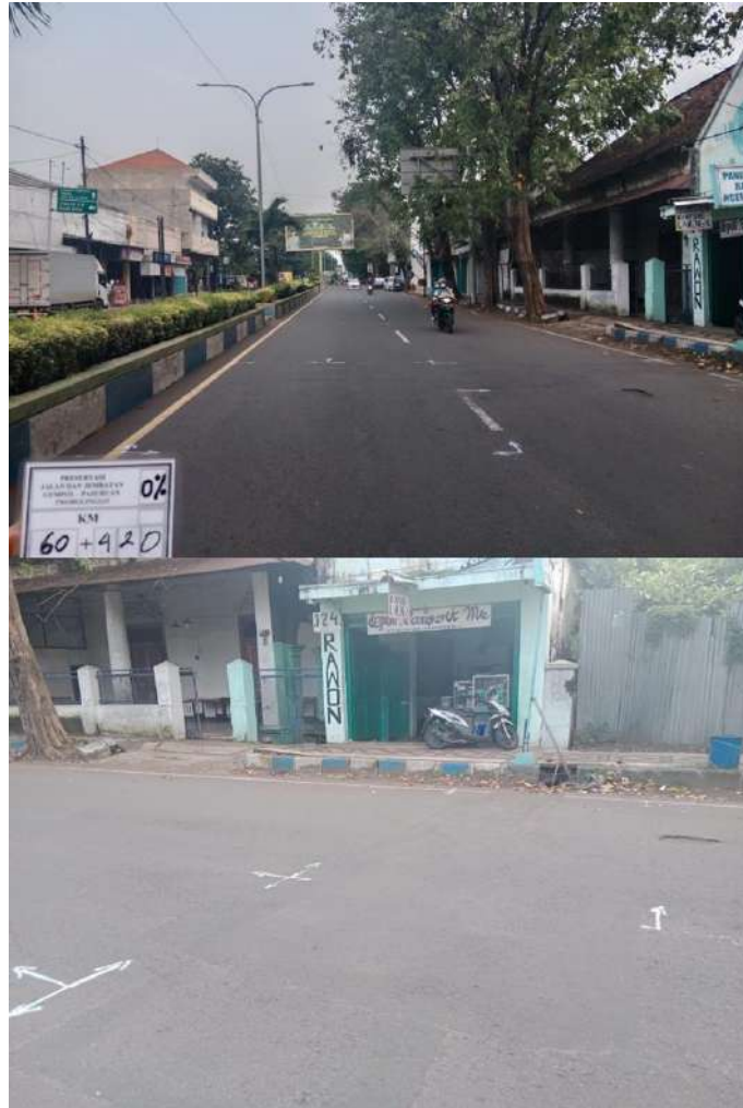
Gambar 3. 7 Kondisi Eksisting Sebelum Pekerjaan Pengaspalan pada KM 6+420
