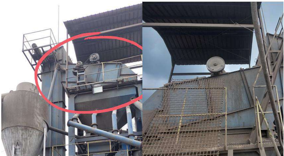
Gambar 3. 28 Hot Bin AMP PT Surya Marga Utama
