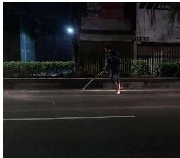
Gambar 3. 15 Proses Pembersihan Permukaan dengan Power Broom
