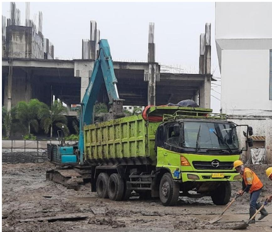
**Gambar 4.43** Proses pengangkutan tanah ke truk
