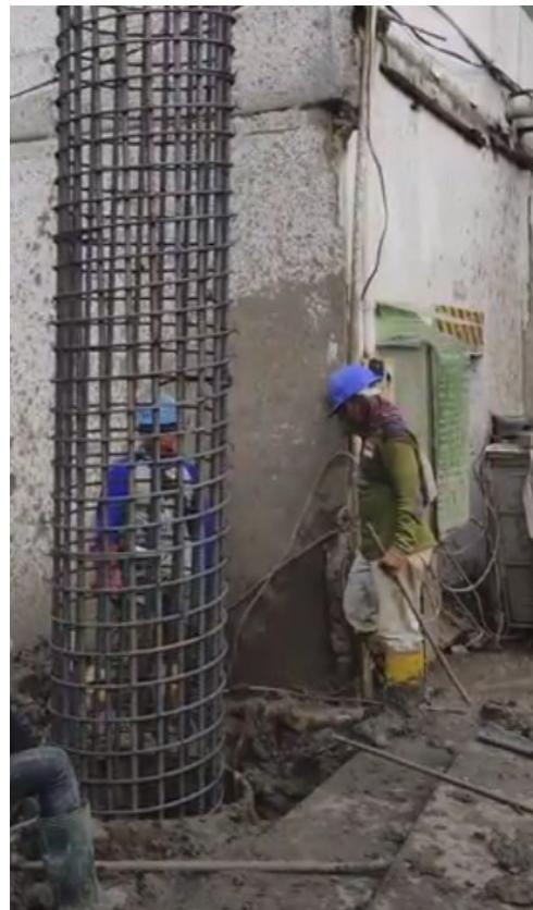
**Gambar 4.40** Proses peletekkan tulangan ke lubang bor
