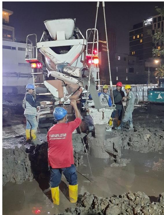
**Gambar 4.42** Proses penuangan cor beton ke lubang bor
