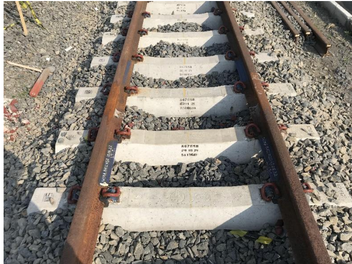
Gambar 2 8 Pengecekan Jumlah Bantalan (Sumber: Dokumen Pribadi)
