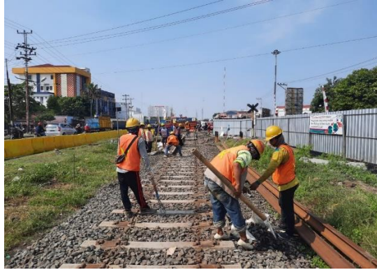
Gambar 2 20 Proses Pemasangan Bantalan Beton
