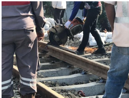
Gambar 2 16 Proses Pemotongan Rel Eksisting
