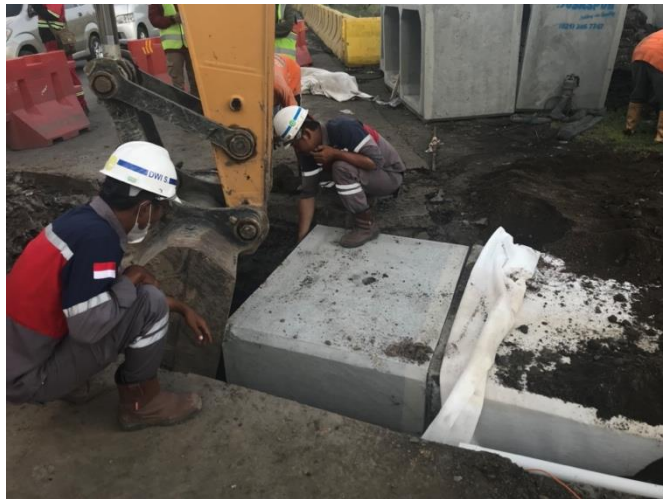
Gambar 3 8 Pemasangan Box Culvert
