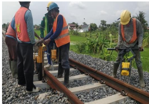
Gambar 2 21 Proses Pemadatan Menggunakan Hand Tie Tamper (HTT)
