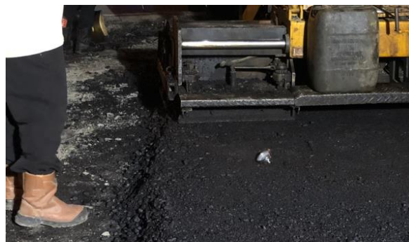
Gambar 3 4Proses Pengukuran Suhu (Sumber : Dokumentasi Pribadi)
