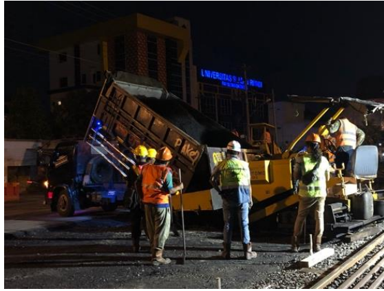
Gambar 3 1 Proses Penuangan Aspal dari Dump Truck (Sumber : Dokumentasi Pribadi)
