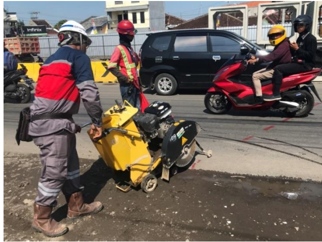
Gambar 3 10 Pemotongan Aspal untuk Sodetan
