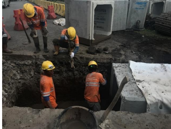
Gambar 2 25 Proses Pemasangan Box Culvert
