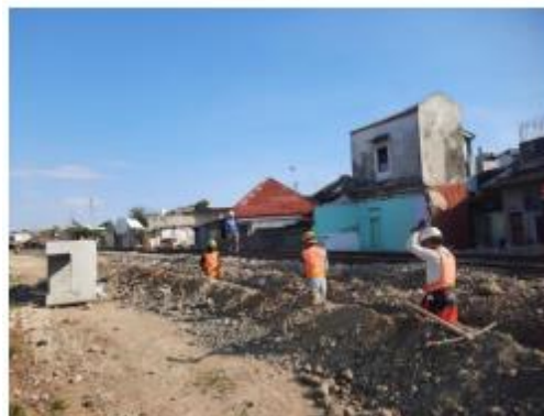
Gambar 2 26 Relokasi Utilitas pada Zona 2
