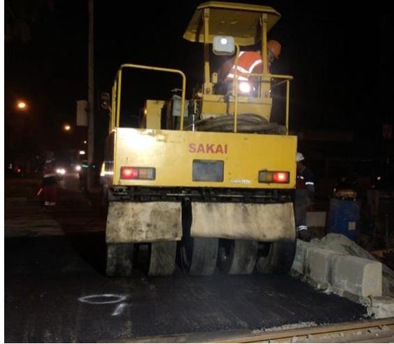
Gambar 3 6 Proses Pemadatan Menggunakan Pneumatic Tyredd Roller
