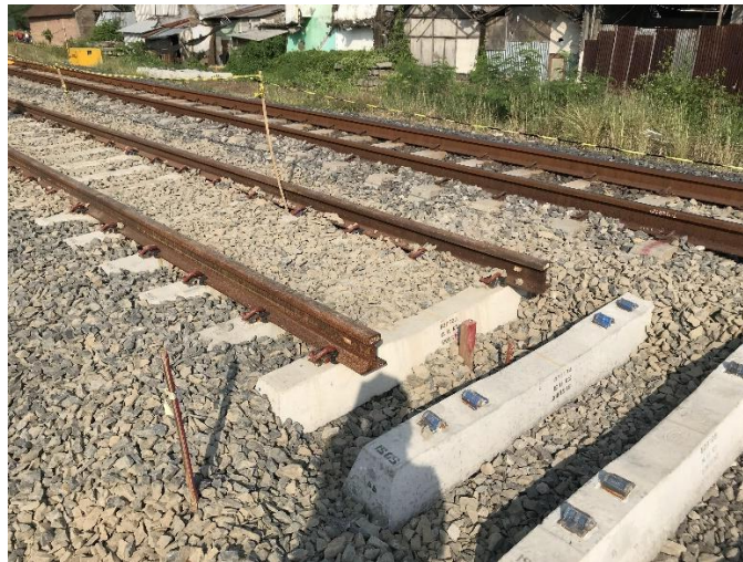
Gambar 2 9 Pengecekan Kondisi Bantalan yang Baru Terpasang (Sumber: Dokumen Pribadi)
