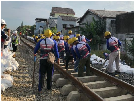
Gambar 2 15 Proses Pergeseran Jalur Eksisting
