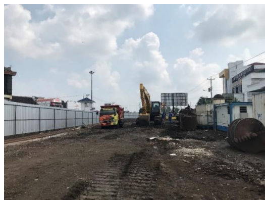
Gambar 2 32 Proses Clearing Area Pada zona P1 (P11)
