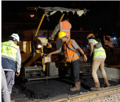
Gambar 3 3 Proses Pengecekan Ketebalan
