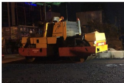
Gambar 3 5Proses Pemadatan Menggunakan Tandem Roller (Sumber : Dokumentasi Pribadi)
