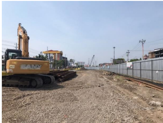
Gambar 2 33 Proses Clearing Area pada Zona 2 (P10)
