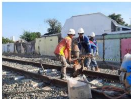
Gambar 2 29 Pekerjaan Las Thermit / Pengelasan Rel
