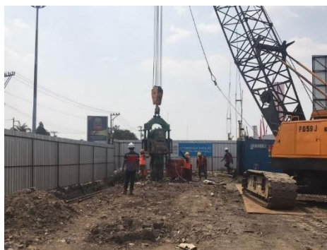
Gambar 2 36 Pemasangan SSP pada Zona 1
