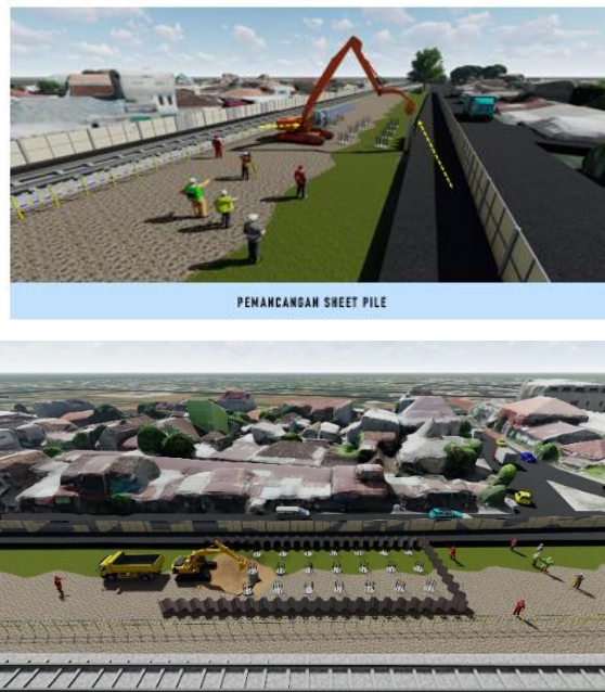
Gambar 2 34 Ilustrasi Pemasangan Steel Sheet Pile (SSP) pada Zona 1 (P11)
