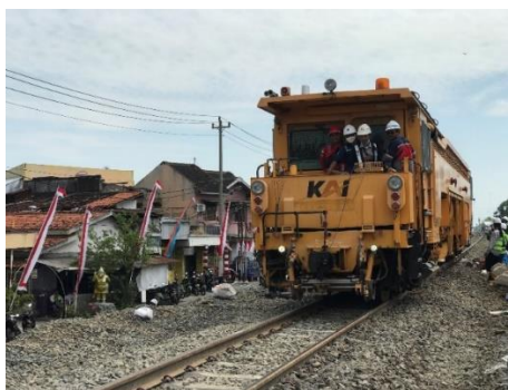
Gambar 2 17 Angkat Listring dengan Alat Berat MTT
