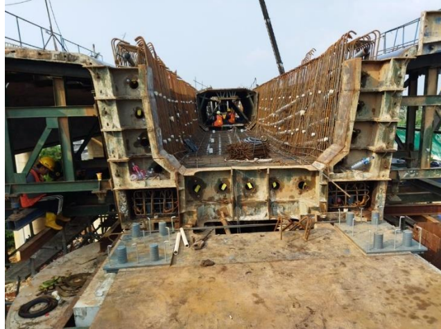
Gambar 4. 7 Proses penulangan bottom slab dan dinding
