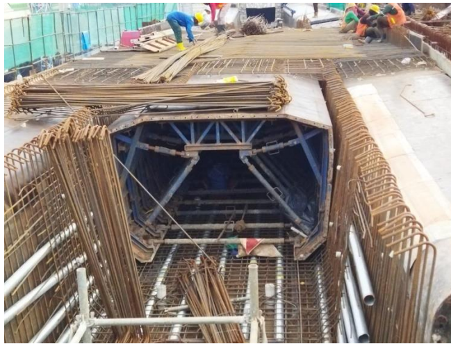
Gambar 4. 12 Proses penulangan top slab dan sayap
