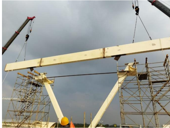
Gambar 4. 37 Proses pengangkatan beam memanjang
