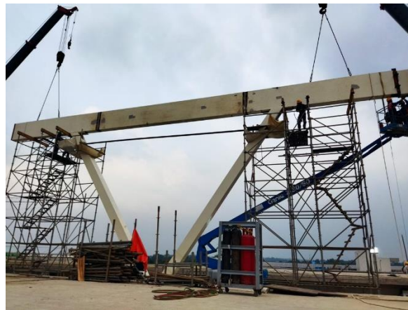
Gambar 4. 38 Beam memanjang setelah terpasang
