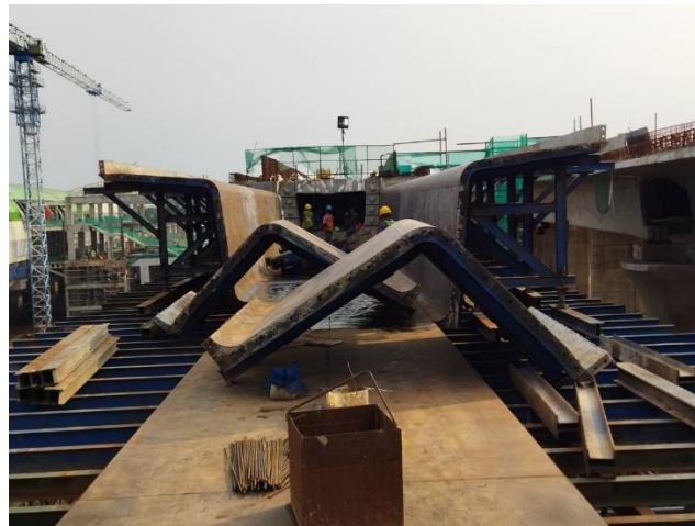
Gambar 4. 6 Penampakan bekisting outer yang sudah terpasang
