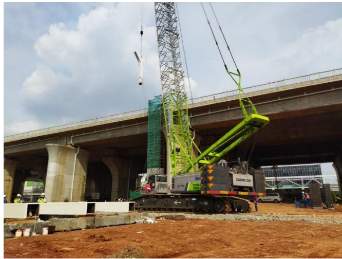
Gambar 4. 32 Proses pengangkatan kolom menggunakan crawler crane
