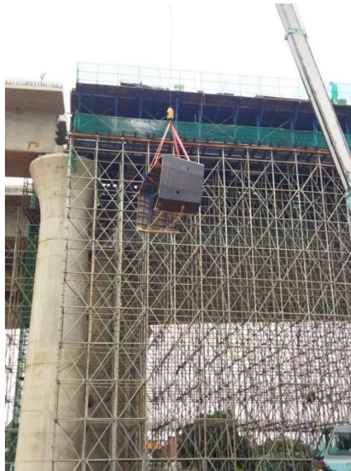
Gambar 4. 10 Proses pengangkatan bekisting inner
