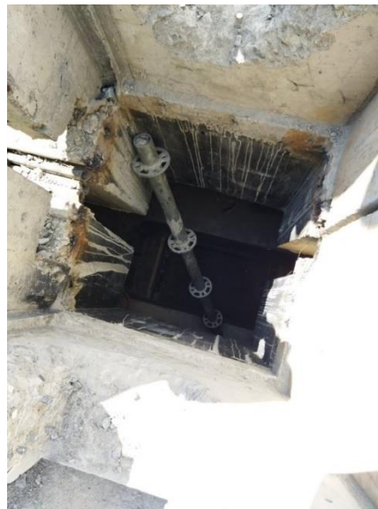
Gambar 6. 1 Dimensi lubang yang berbeda dari dimensi kolom
