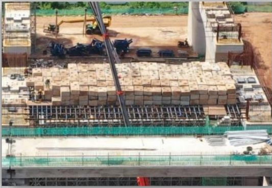
Gambar 4. 3 Pemberian preloading dilihat dari atas
