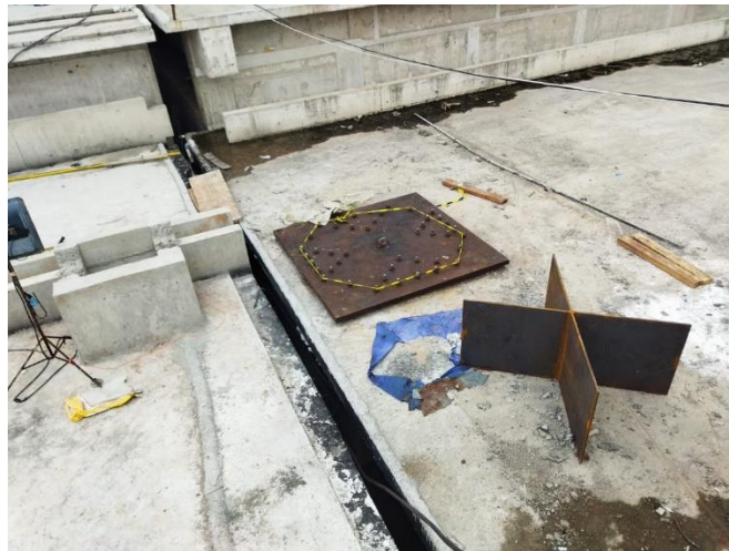
Gambar 4. 41 Penampakan dari pemasangan baseplate yang sudah dilengkapi dengan angkur
