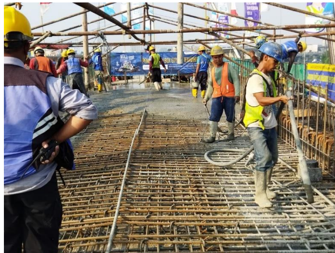
Gambar 4. 15 Proses pemadatan setelah mengecor menggunakan vibrator
