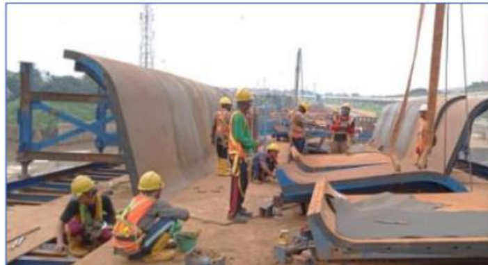
Gambar 4. 5 Proses pengangkatan bekisting outer
