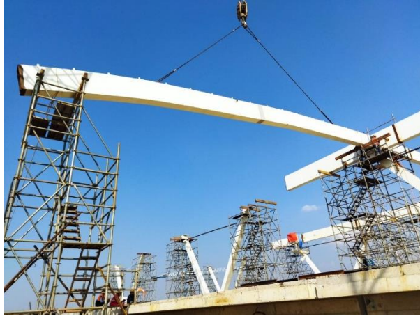
Gambar 4. 39 Penampakan rafter melintang yang sudah terpasang
