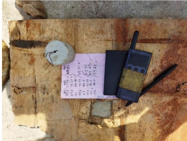
Gambar 4. 23 Kontrol perbandingan nilai stressing lapangan dan rencana
