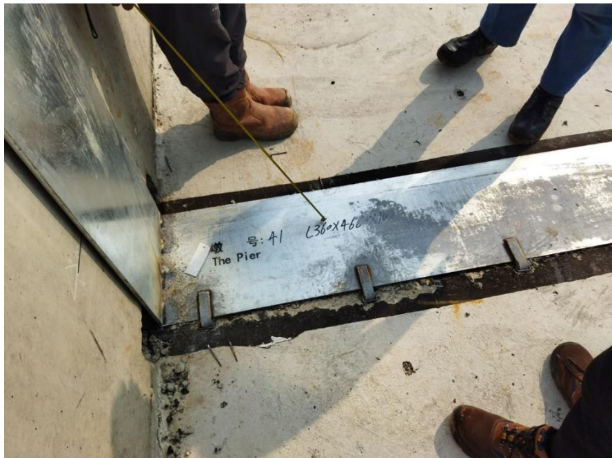
Gambar 4. 25 Waterproof rubber belt yang sudah melapisi expansion joint
