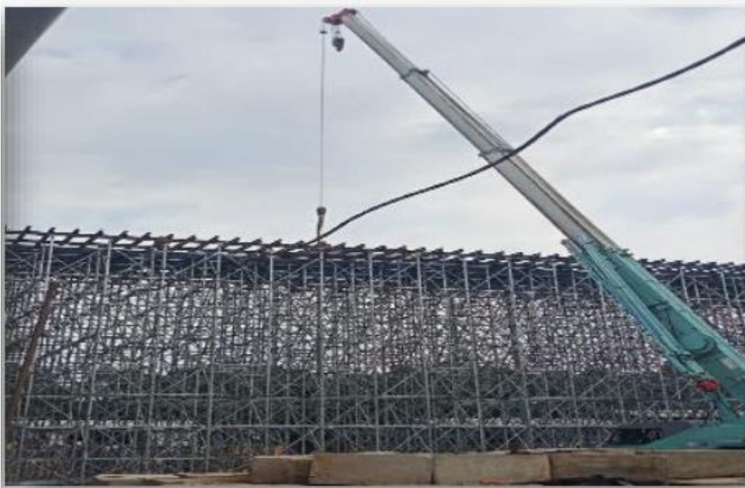
Gambar 4. 4 Pemberian preloading dilihat dari bawah
