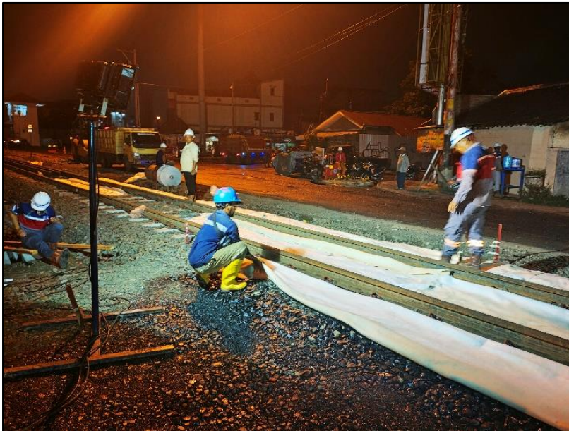
Gambar 2.12 Pelaksanaan Pemasangan Geotextile Separator
