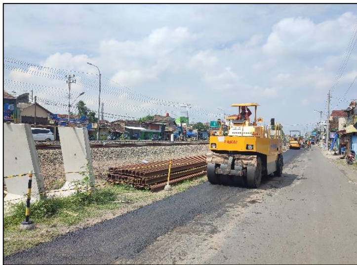
Gambar 2.16 Pelaksanaan Pengaspalan Jalan
