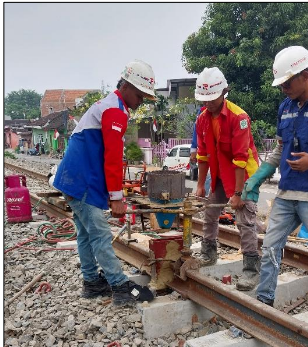
Gambar 2.35 Memasukkan Bubuk Thermit
