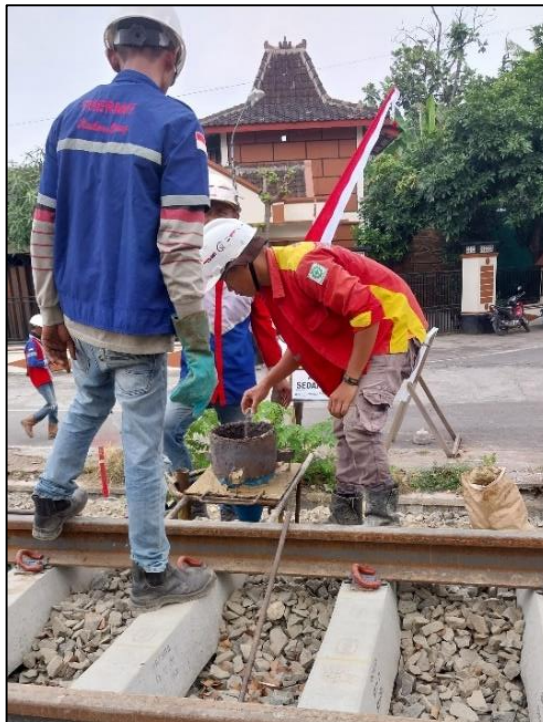
Gambar 2.34 Memasukkan Campuran Besi Oksida Panas
