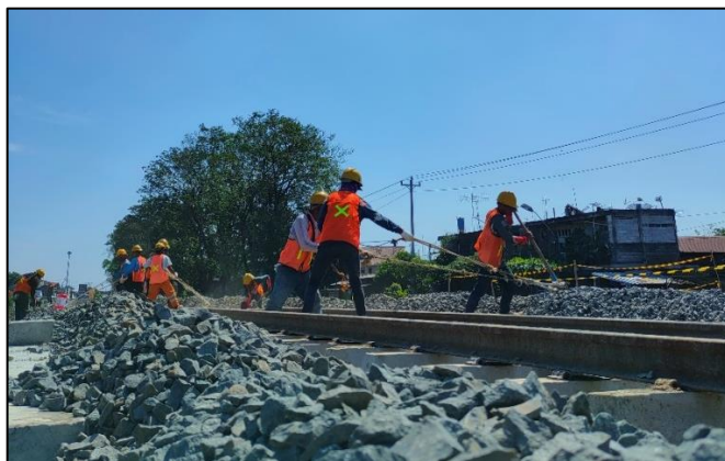
Gambar 2.23 Pelaksanaan Pekerjaan Pelangsiran Ballast
