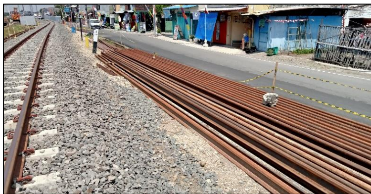
Gambar 2.28 Pelaksanaan Angkutan Rel R54 ke Lokasi Proyek
