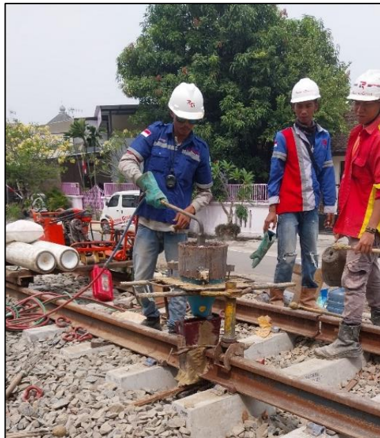
Gambar 2.37 Pemanasan Bubuk Thermit
