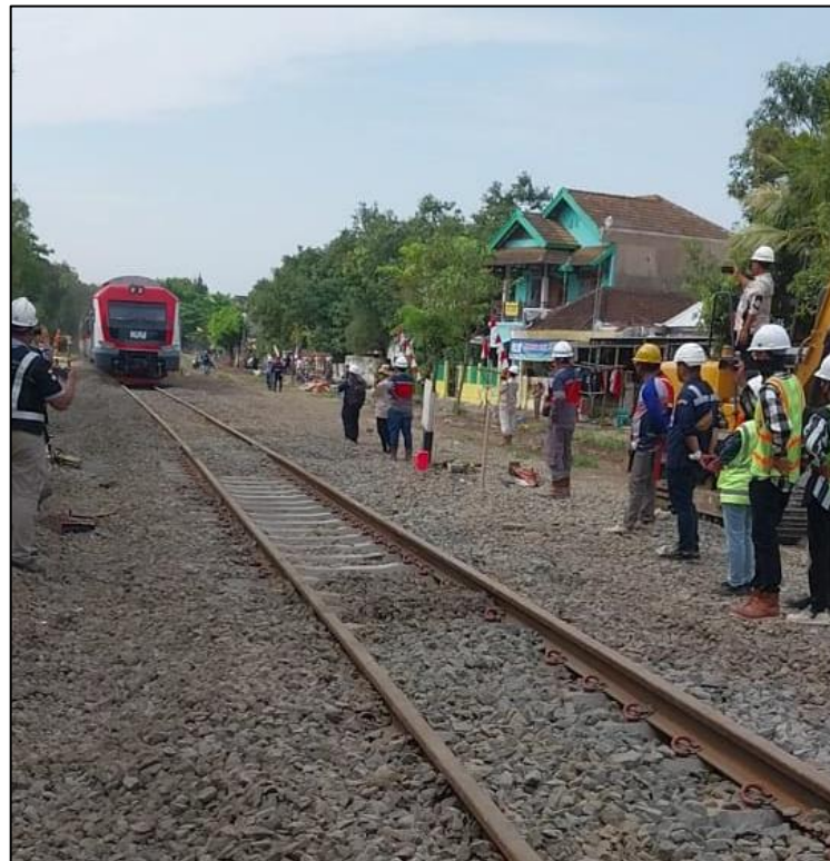
Gambar 2.47 Pekerjaan Switch Over
