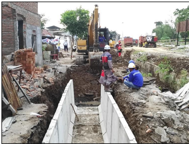
Gambar 2.14 Pelaksanaan Pekerjaan Saluran Pracetak (U-Ditch)
