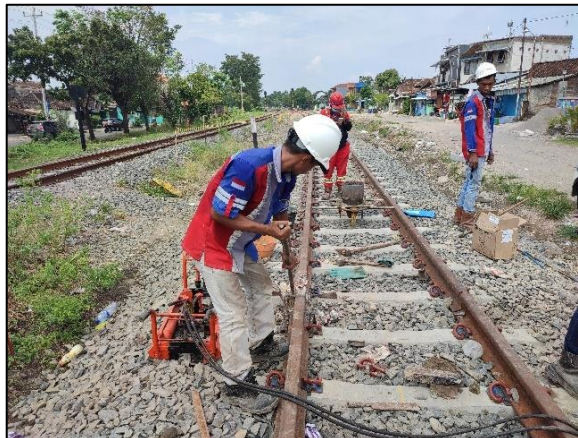
Gambar 2.39 Pembongkaran Cetakan Las Thermit
