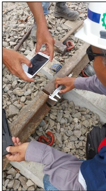
Gambar 2.31 Pengukuran Celah Antar Rel
