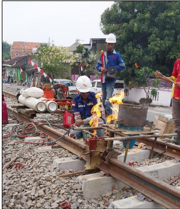
Gambar 2.36 Pemanasan Cetakan
