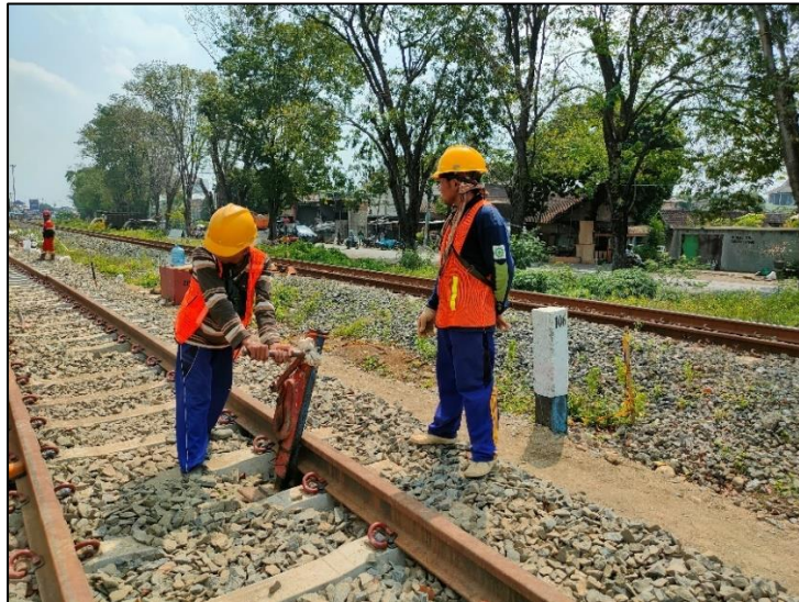
Gambar 2.44 Pelaksanaan Pekerjaan Pemasangan Rel R54, Bantalan Beton, dan Pemadatan Awal HTT
