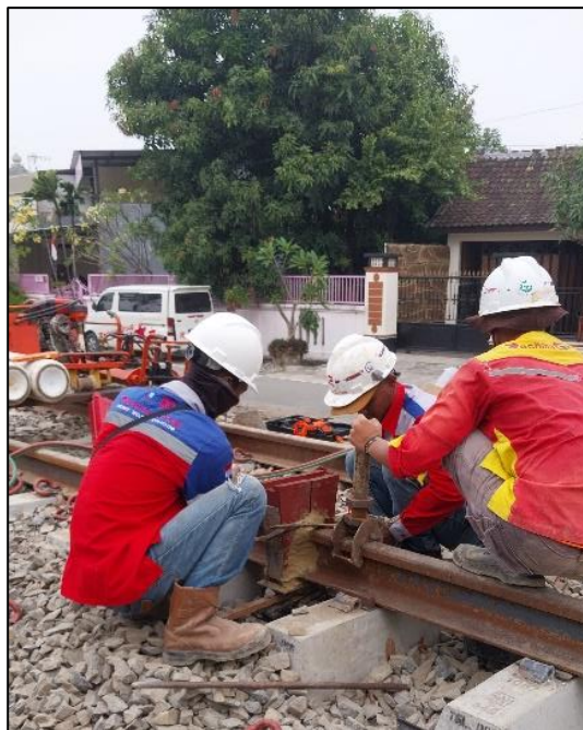
Gambar 2.33 Memasang Cetakan Las Thermit
