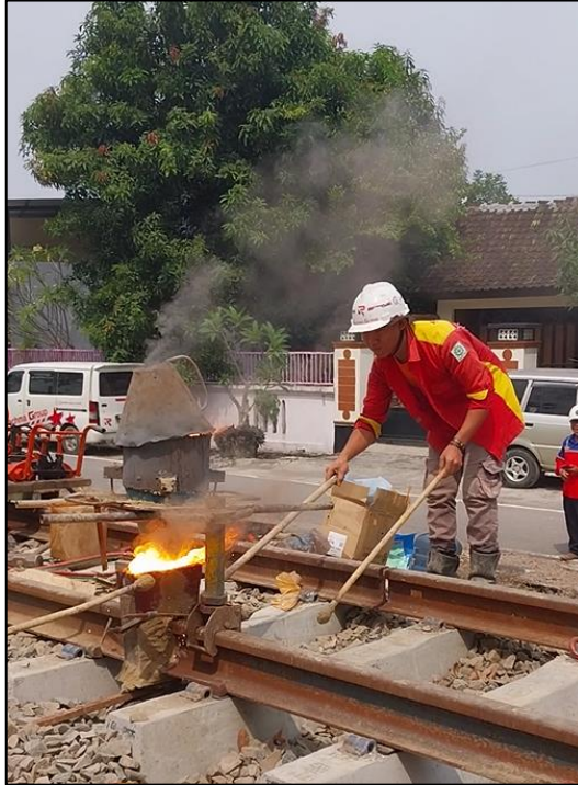
Gambar 2.38 Bubuk Thermit Masuk ke Dalam Cetakan
