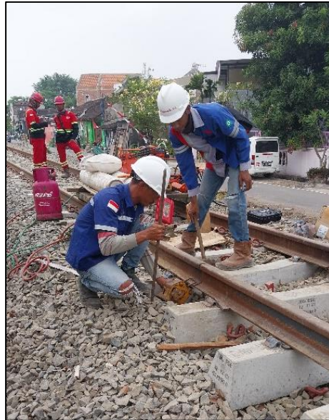
Gambar 2.32 Mendongkrak Rel Sebelum Dilakukan Pengelasan
