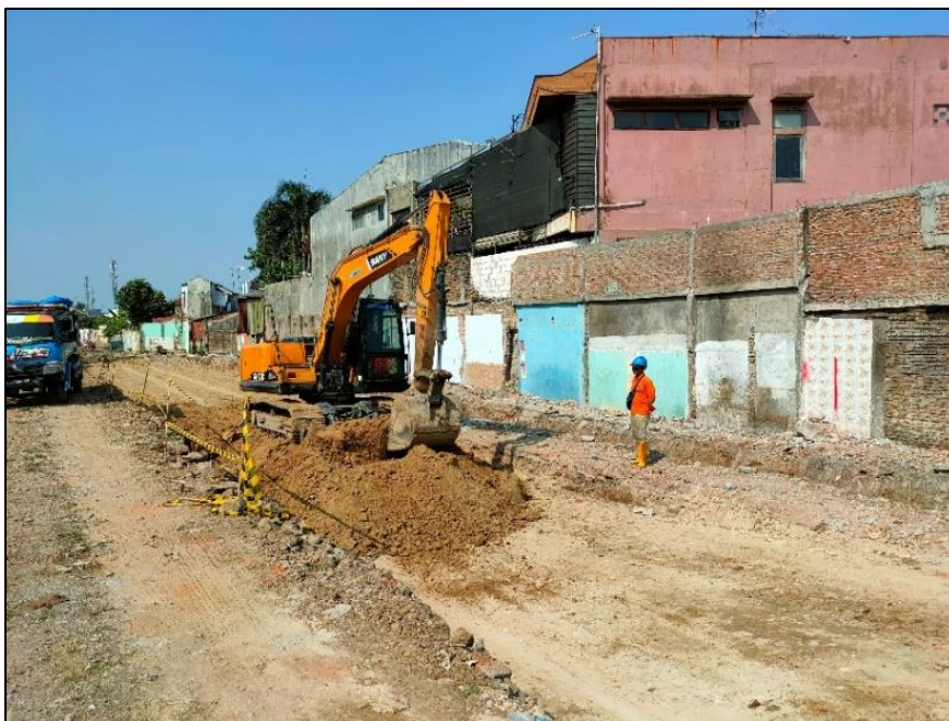
Gambar 2.21 Pelaksanaan Pekerjaan Timbunan Dengan Material Sub Ballast
