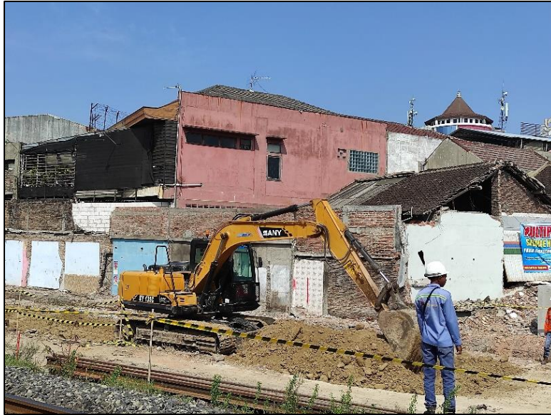
Gambar 2.8 Pelaksanaan Pekerjaan Galian Tanah
