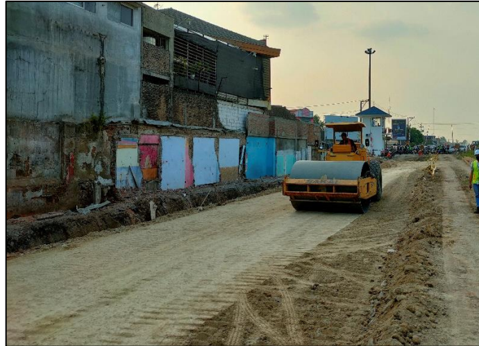
Gambar 2.10 Pelaksanaan Pekerjaan Timbunan Dengan Material Tanah Pilihan
