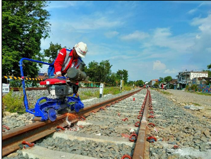
Gambar 2.40 Pengamplasan/Penggerindaan Las Thermit
