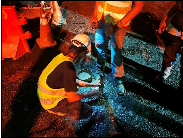
Gambar 2.20 Pelaksanaan Uji Core Drill Aspal
