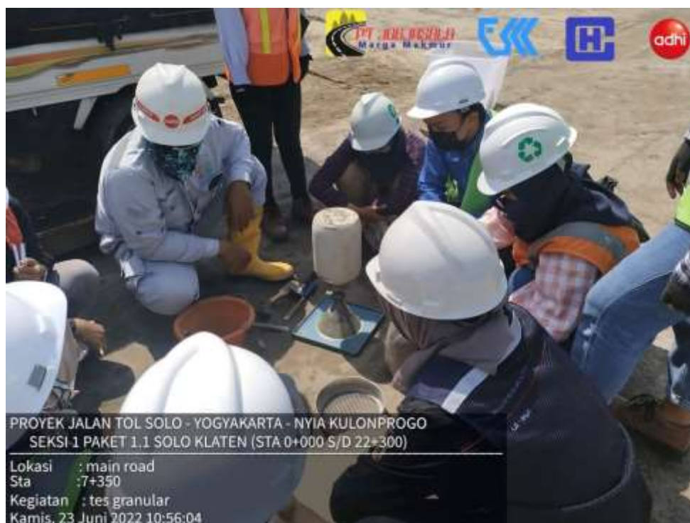
Gambar 4.2 Kegiatan Uji Sand Cone Test pada STA 7+350
