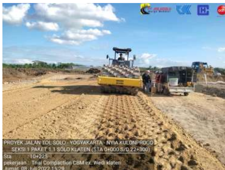
Gambar 2.4 Proses Pemadatan Tanah Menggunakan Sheep Foot dan Vibro Roller
