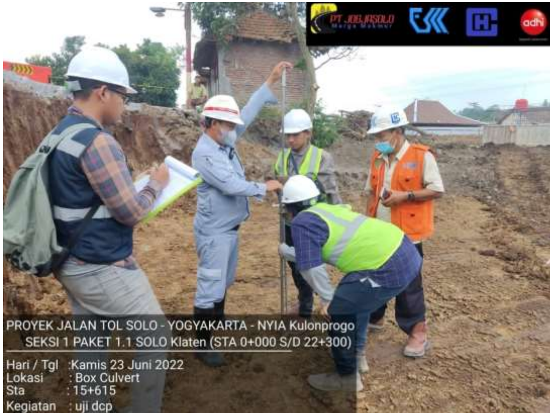
Gambar 4.3 Uji Dinamic Cone Penetrometer pada Lokasi Box Culvert
