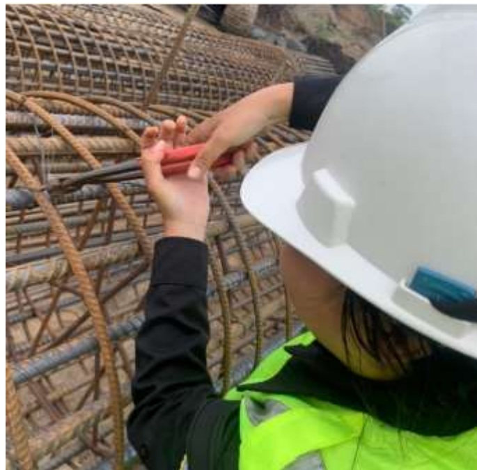
Gambar 2.12 Proses Fabrikasi Baja Tulangan Bored Pile
