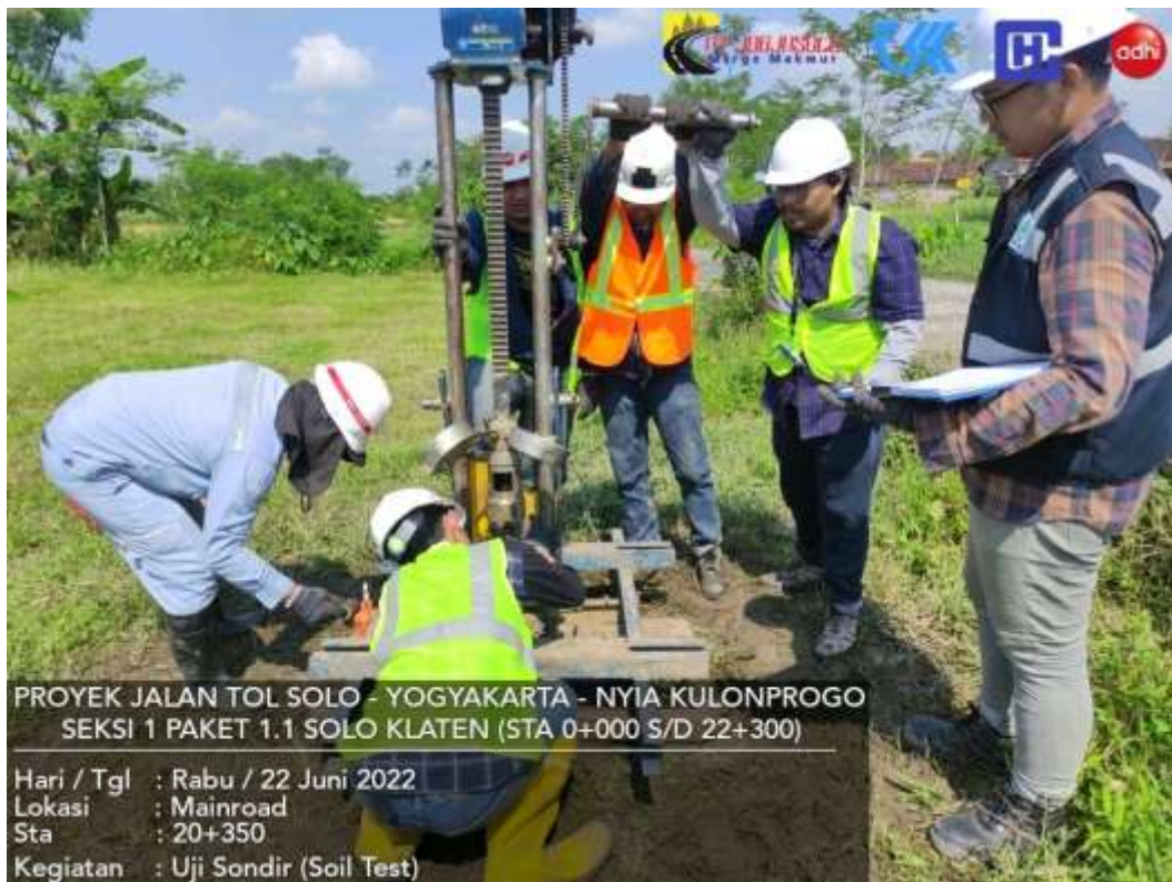
Gambar 4.4 Kegiatan Uji Sondir pada STA 20+350
