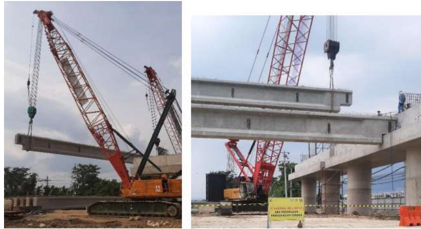
Gambar 2.28 Penempatan Girder pada titik yang di rencanakan
