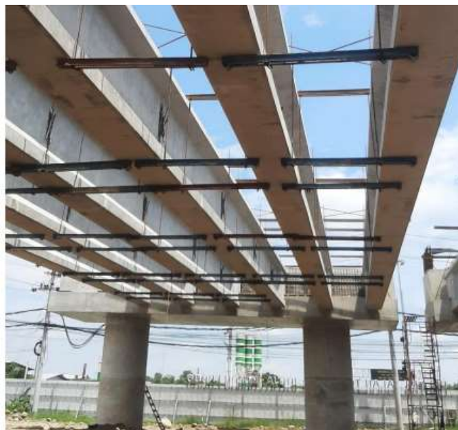
Gambar 2.50 Girder yang sudah terpasang dan terbracing
