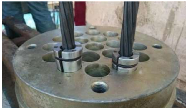
Gambar 2.22 Pemasangan Wedges
