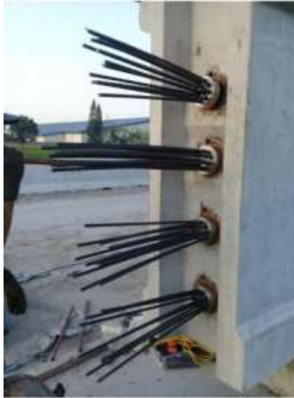
Gambar 2.21 Pemasangan Wedges Plates
