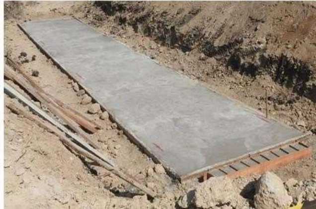
Gambar 2.30 Pengecoran Lantai Kerja
