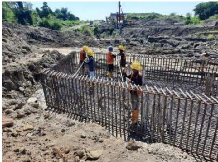
Gambar 2.31 Pembesian Box Culvert
