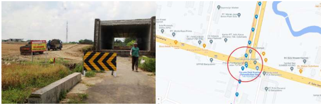
Gambar 3.4 Akses Jalan Masuk Kendaraan Proyek pada Jalan Umum
