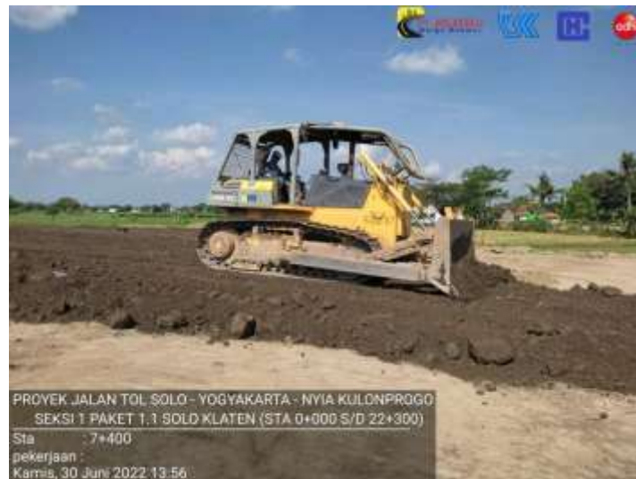
Gambar 2.3 Proses Penghamparan Tanah Timbunan Menggunakan Bulldozer
