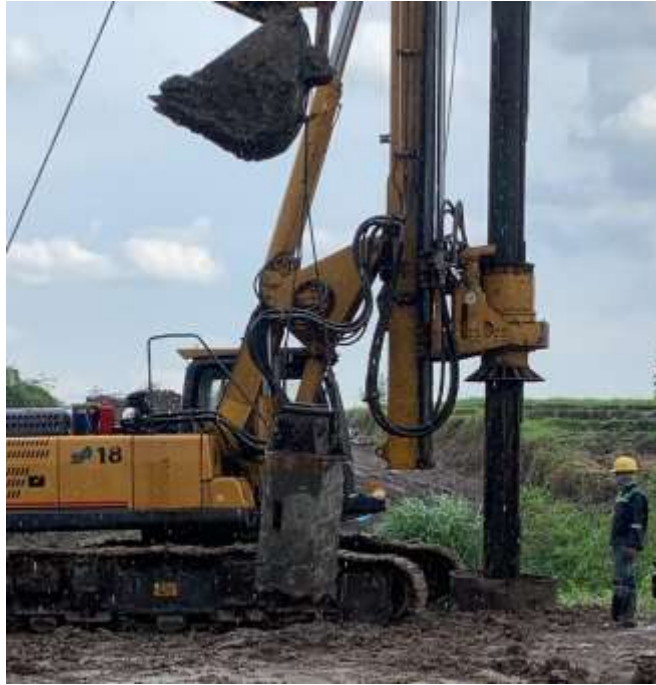
Gambar 2.11 Proses Pengeboran Tanah
