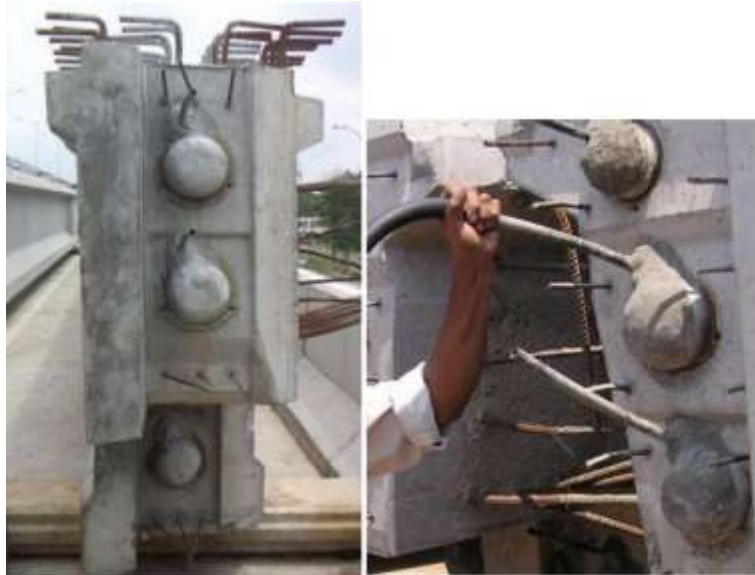
Gambar 2.41 Proses Memasukkan Beton ke dalam Girder
