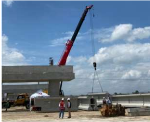
Gambar 2.19 Peletakan PCI Girder
