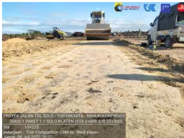
Gambar 2.16 Pemadatan Tanah Dasar
