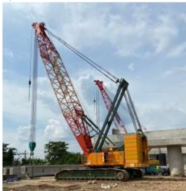
Gambar 2.27 Pengambilan Girder dari Stockyard
