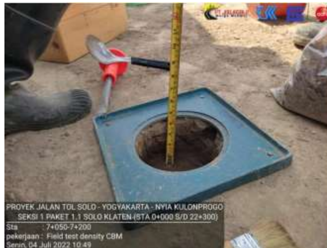
Gambar 2.36 Pengalihan Tanah untuk dilakukan Sandcone Test
