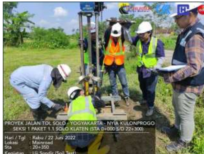
Gambar 2.51 Proses Menginstalasi alat sondir
