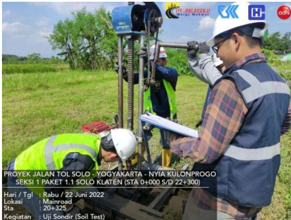
Gambar 4.5 Kegiatan Uji Sondir pada STA 20+325
