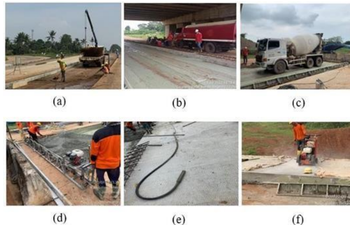
Gambar 2. 2 Alat Pekerjaan Rigid Manual ( Kolektor SS Setu Utara )
