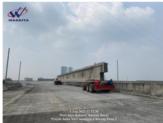
Gambar 3. 22 Mobilisasi Girder Menuju Area Lifting
