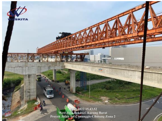
Gambar 3. 25 Placing Girder pada Bearing Pad
