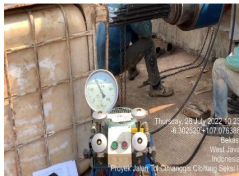
Gambar 2. 15 Stressing atau Melakukan Tarikan.
