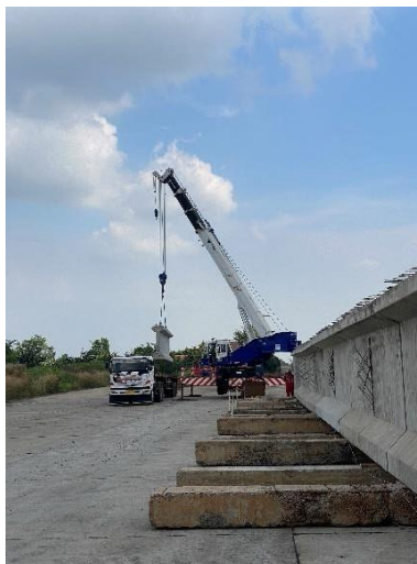
Lampiran 2 Mengawasi Pindahan Girder dari Transporter ke Stock Yard
