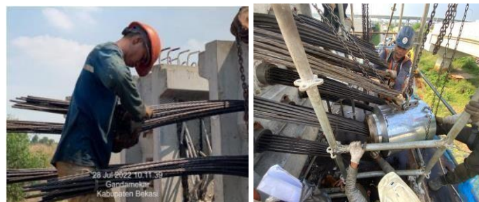
Gambar 2. 12 Instalansi Angkur dan Wedges.
