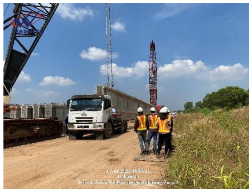
Lampiran 3 Menghitung waktu Transport Gider dari Stock Yard ke tempat loading Launcher Gantry
