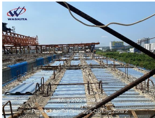
Lampiran 5 Meninjau Pemasangan Steel Deck untuk persiapan Rigid
