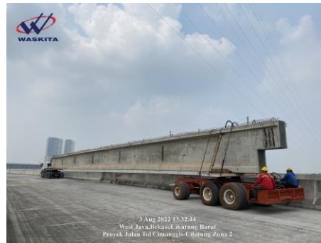
Gambar 3. 19 Mobilisasi Girder dengan Boogie
