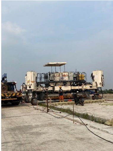
Lampiran 7 Meninjau Persiapan Rigid Paver untuk pekerjaan malam hari
