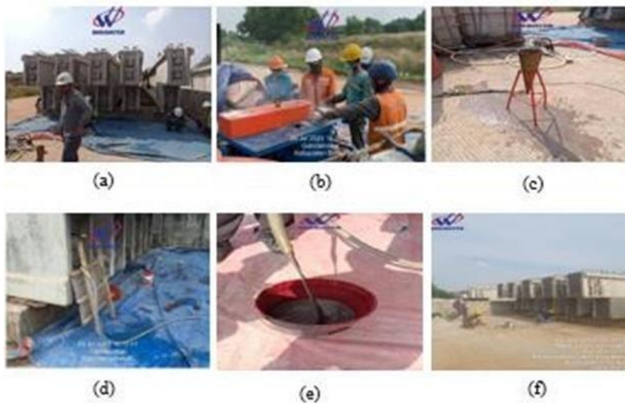
Gambar 2. 17 Tahap Pekerjaan Grouting.
