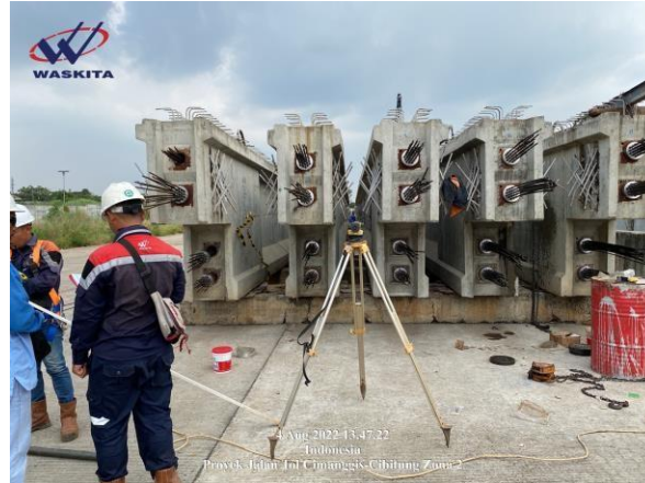
Gambar 2. 9 PCI Girder pada SPAN P19 – P20.
