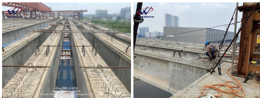
Gambar 3. 27 Pemasangan Bracing Girder
