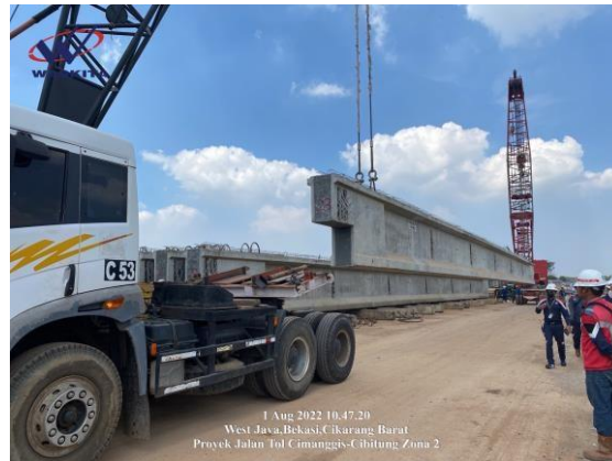
Gambar 3. 21 Proses Pengangkatan Girder ke Atas Mobil Boogie
