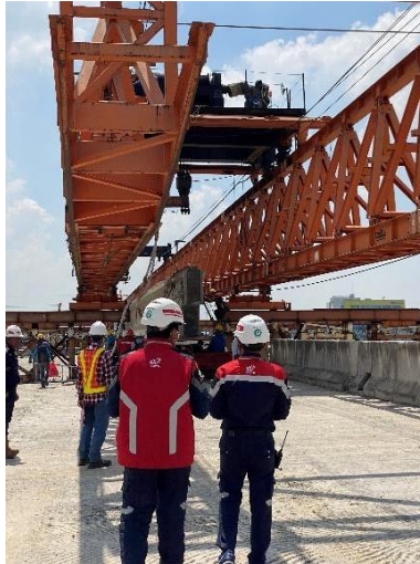
Lampiran 4 Menemani SOM untuk meninjau persiapan Launching Girder
