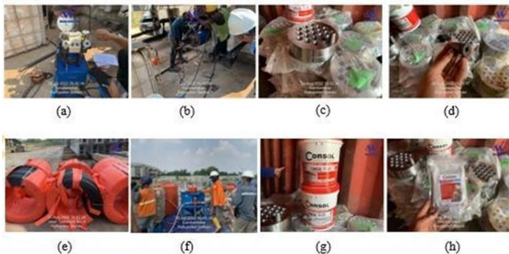
Gambar 2. 10 Alat dan Bahan pada Pekerjaan Stressing Girder.
