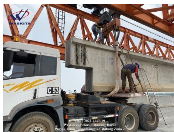
Gambar 3. 23 Menempatkan Sling Angkat Launcher Gantry
