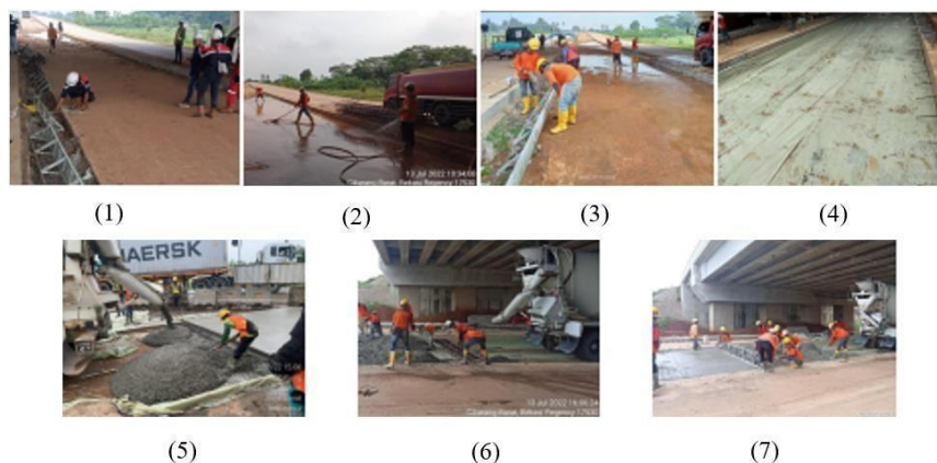
Gambar 2. 4 Metode Pelaksanaan Pekerjaan Rigid Manual (Kolektor SS Setu Utara).
