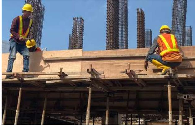
Gambar 3. 17 Pekerjaan Bekisting Balok
