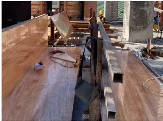
Gambar 3. 13 Pembuatan Bekisting
