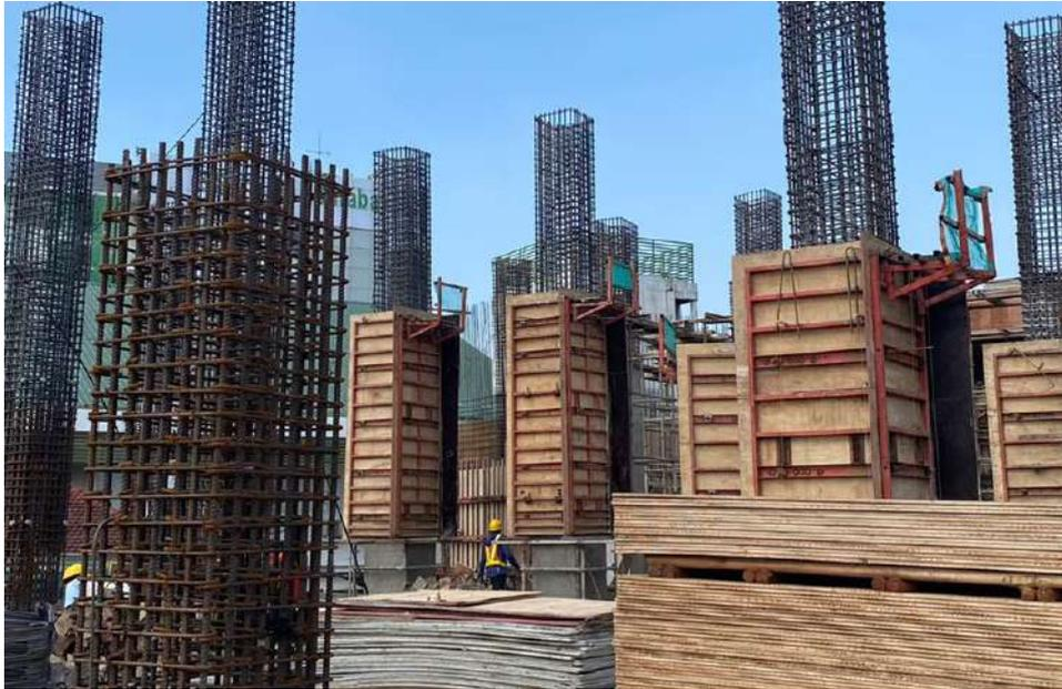
Gambar 3. 2 Pekerjaan Kolom
