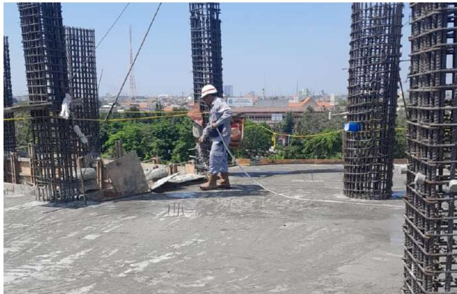
Gambar 3. 5 Pekerjaan Curing
