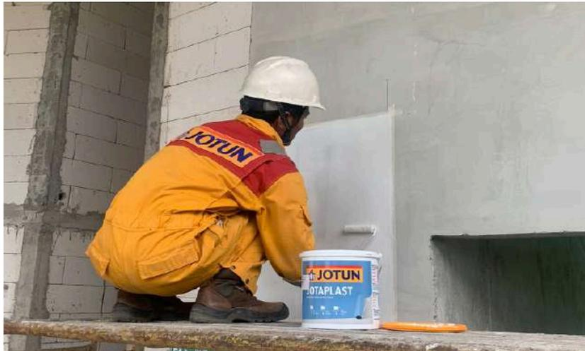
Gambar 3. 6 Pekerjaan Mock Up Cat Dinding
