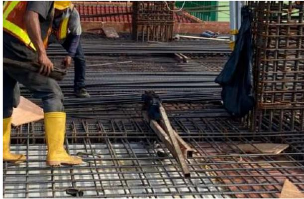
Gambar 4. 1 Pengecheckan tulangan pelat lantai
