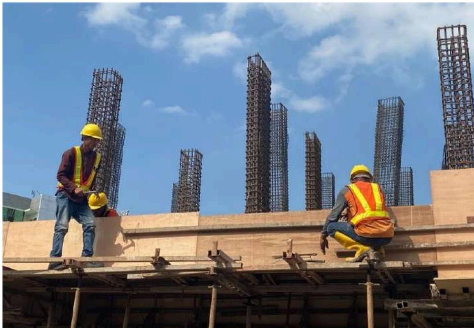
Gambar 3. 3 Pekerjaan Pemasangan Bekisting
