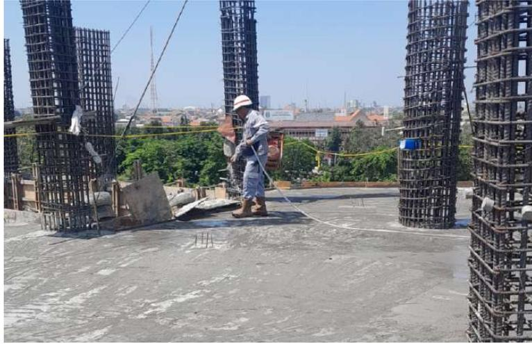
Gambar 3. 20 Pekerjaan Curing
