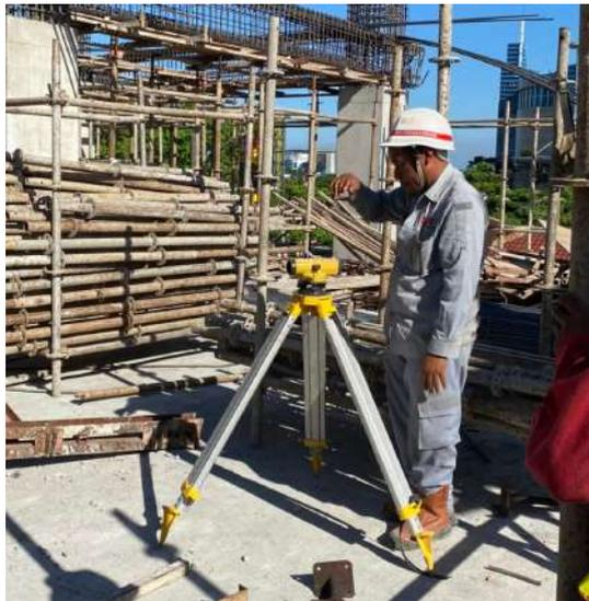
Gambar 3. 8 Pekerjaan marking dengan theodolite
