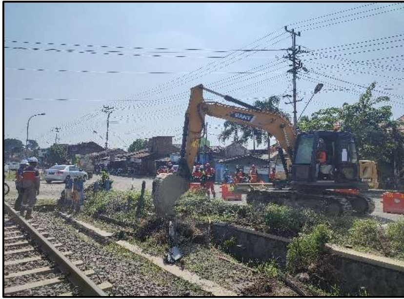
Gambar 2.5 Pekerjaan Pembersihan Lahan
