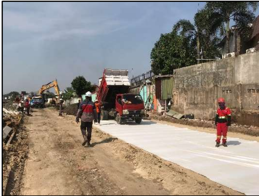
Gambar 2.10 Pekerjaan Pemasangan Geotekstile Sebagai Separator
