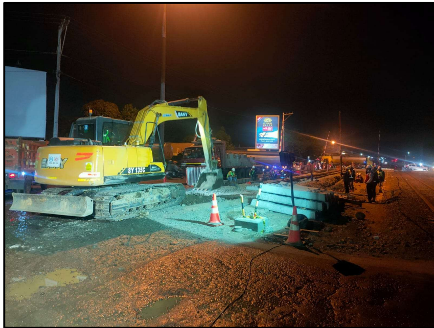
Gambar 2. 12 Pekerjaan Timbunan Dengan Material Berbutir
