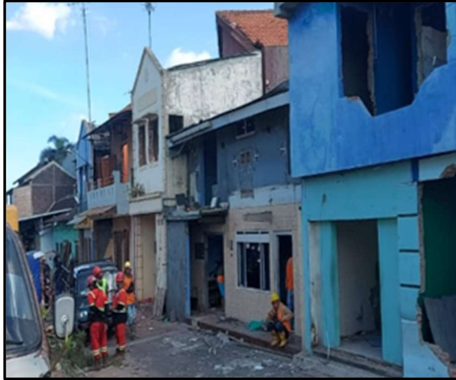
Gambar 2.23 Proses Pembongkaran Rumah Warga
