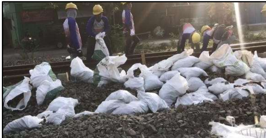
Gambar 2.32 Pengorekan Ballas dan Mengisi Karung Ballas
