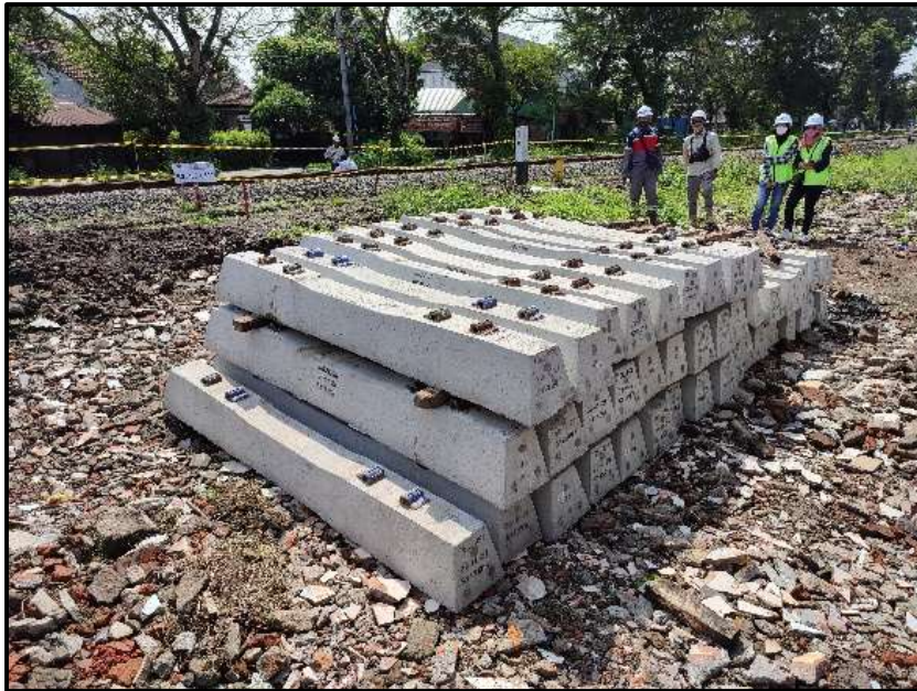
Gambar 2.15 Pengadaan Bantalan Beton
