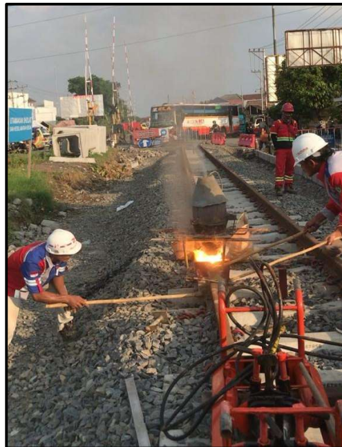
Gambar 2.27 Pekerjaan Pengelasan Rel
