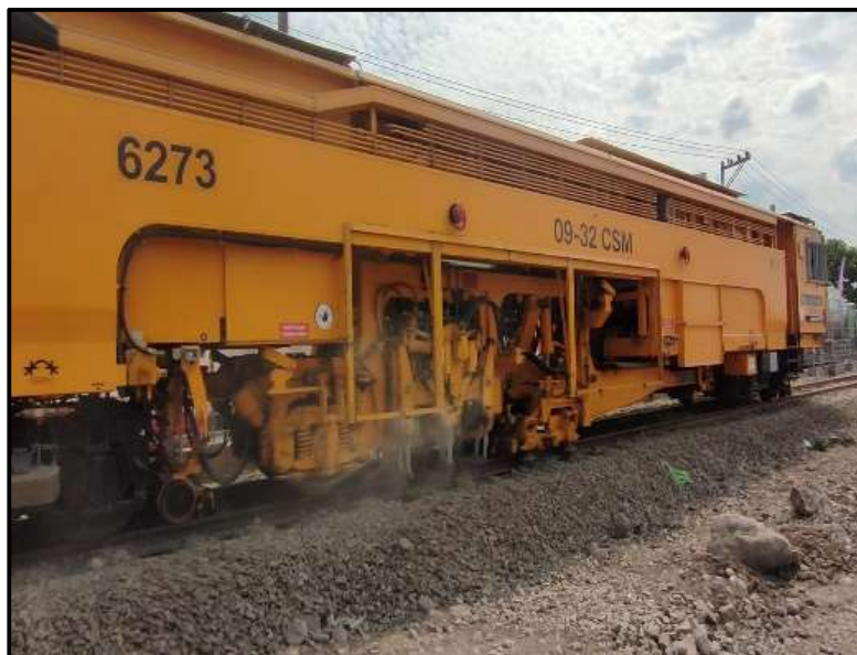
Gambar 2.36 Pekerjaan Angkat Listring Dengan Multi Tie Tamper
