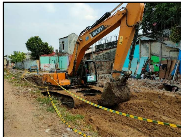
Gambar 2.7 Pekerjaan Galian Tanah
