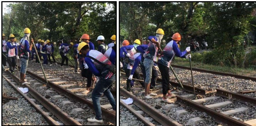
Gambar 2.33 Menggeser Track Eksisting
