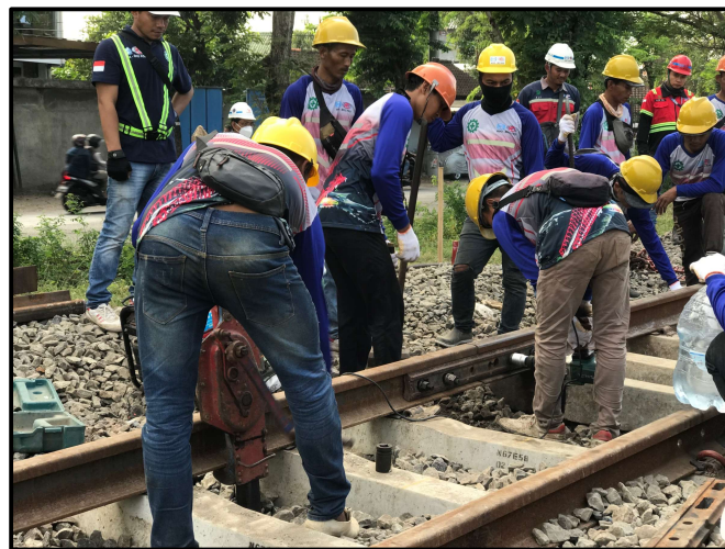
Gambar 2.34 Pekerjaan Angkat Listring Dengan HTT
