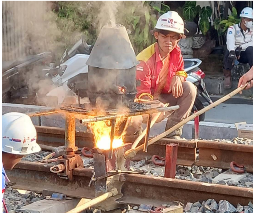
Gambar 2. 19 Proses Penuangan Bubuk Thermit ke Dalam Mold
