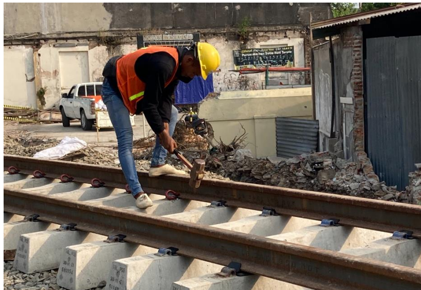
Gambar 2. 17 Proses Pemasangan Pendroll
