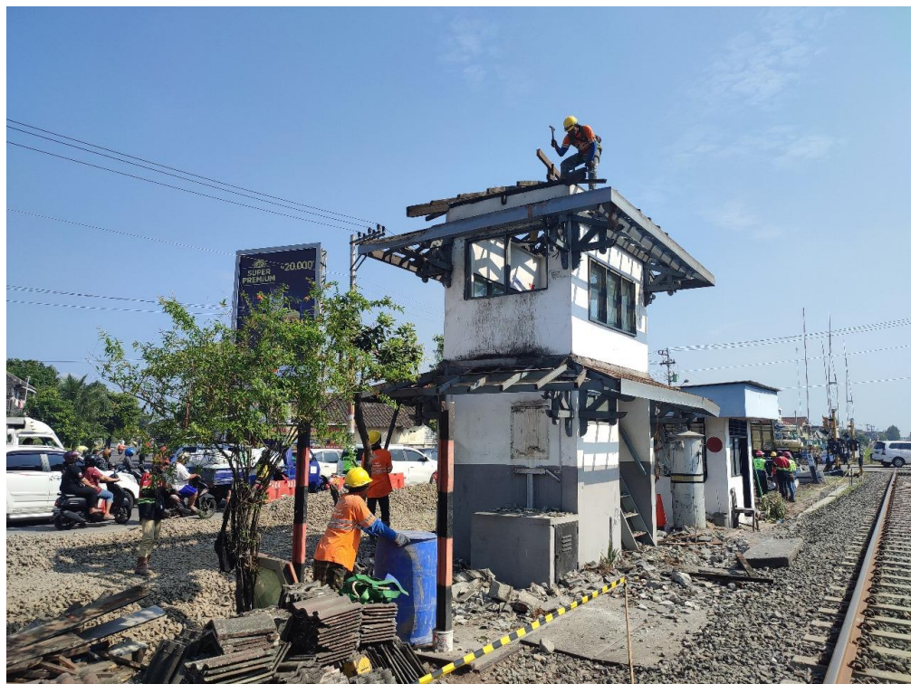
Gambar 8 Pembongkaran Gardu JPL Lama
