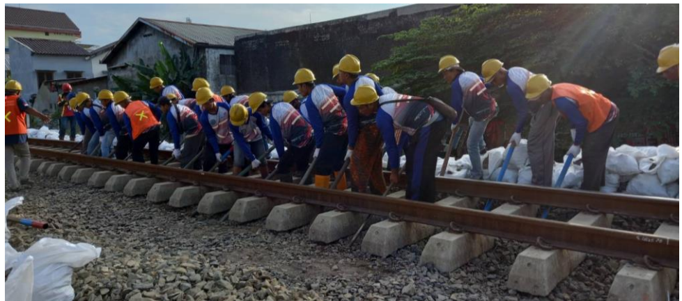
Gambar 2. 31 Proses Penggeseran Rel dan Bantalan dari Jalur Aktif Menuju Jalur Detour
