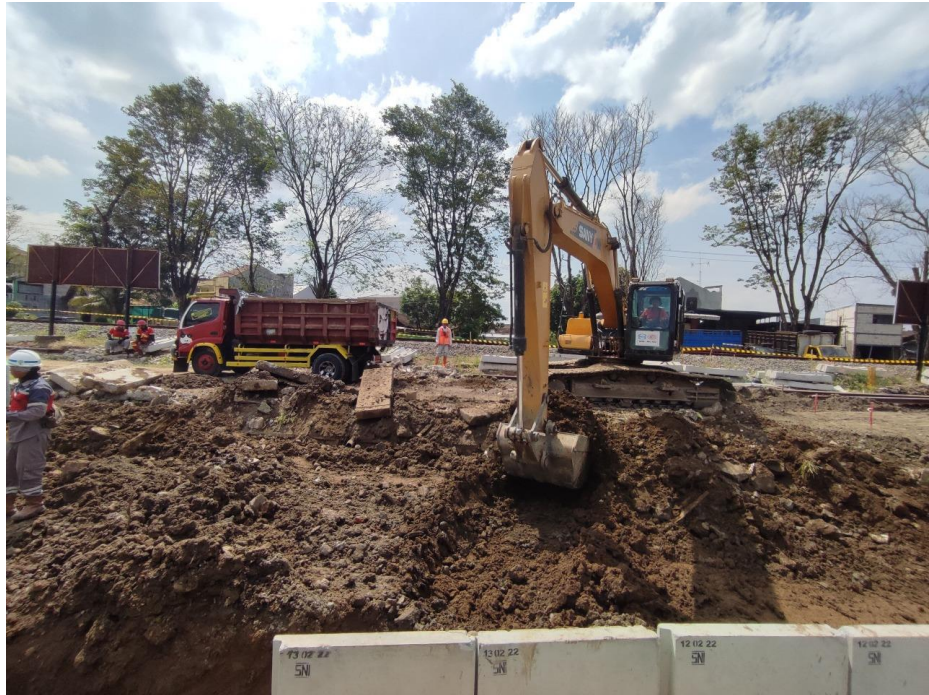
Gambar 2. 27 Proses Penggalian Tanah Dengan Excavator
