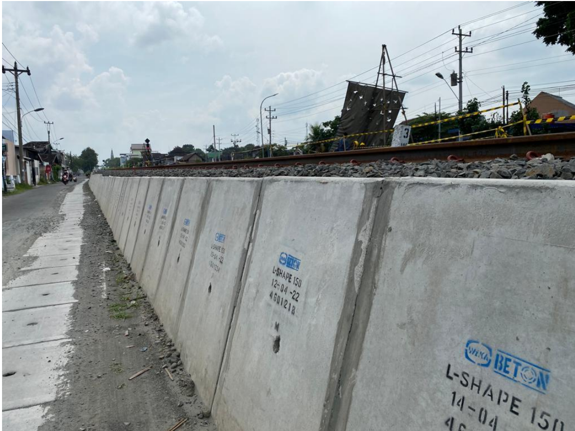
Gambar 3. 10 L-Shape yang Telah Terpasang
