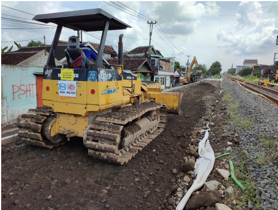
Gambar 1 Proses Penghamparan Subballast dengan Bulldozer
