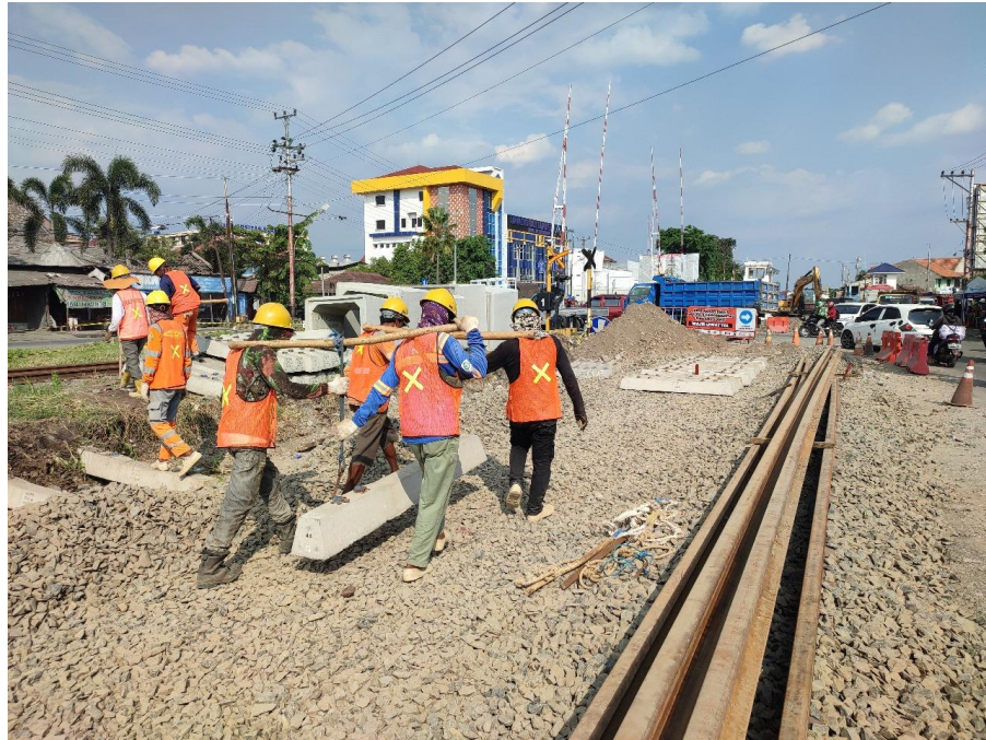
Gambar 2. 14 Proses Peletakan Bantalan Sesuai Jarak yang Ditentukan
