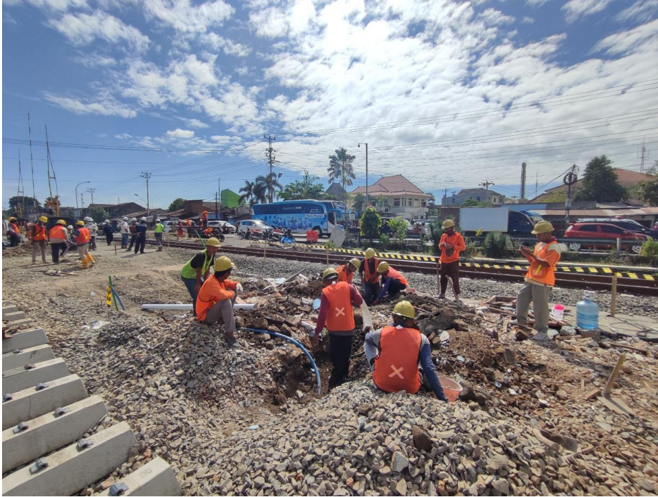
Gambar 3 Proses Gelar Kabel Persinyalan
