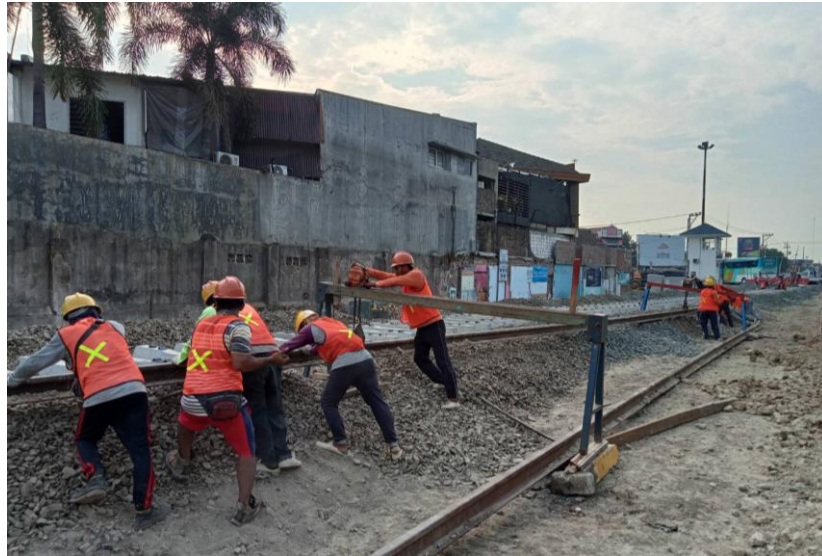
Gambar 2. 16 Proses Pengangkatan Rel Menuju Bantalan
