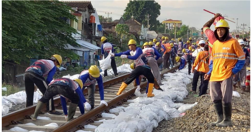
Gambar 2. 30 Proses Pemindahan Karung Ballast
