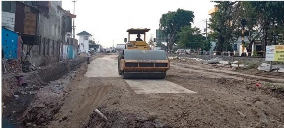
Gambar 2. 7 Proses Pemasatan dengan Vibro-Roller
