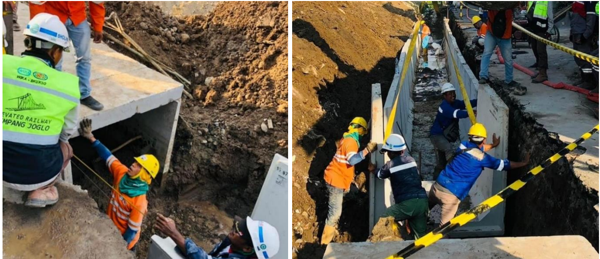
Gambar 3. 25 Pemasangan U-Ditch Pada STA 105+900
