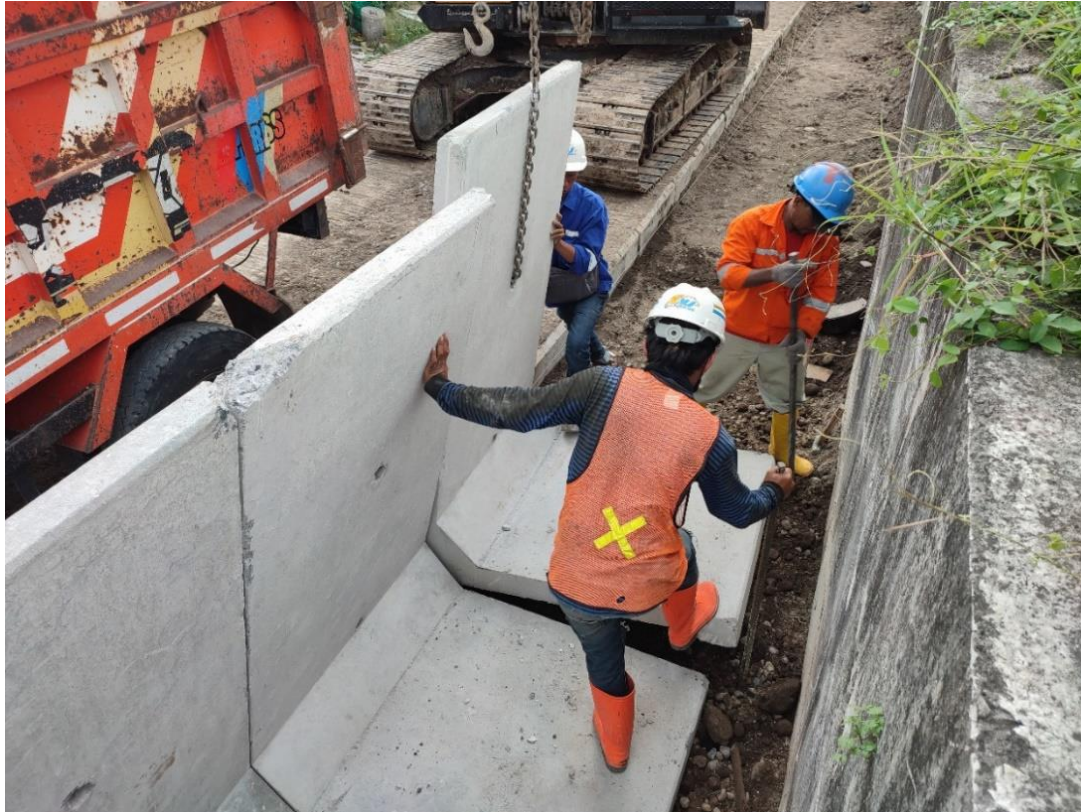
Gambar 3. 9 Proses Pemasangan L-Shape
