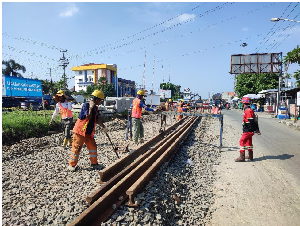
Gambar 12 Proses Pelangsiran Rel
