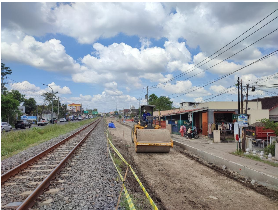
Gambar 2 Proses Pemadatan Tanah dengan Vibro Roller
