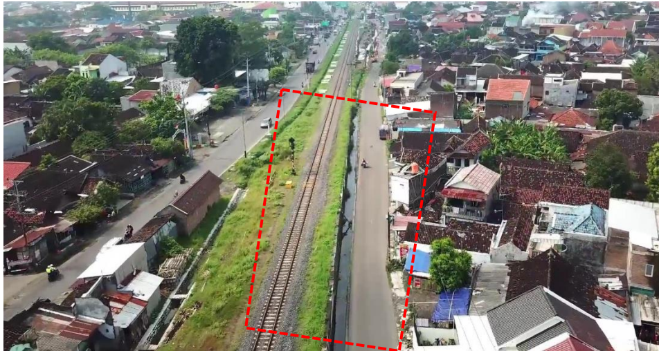
Gambar 20 Kondisi Eksisting Tubuh Baan dan Jalan Manunggal
