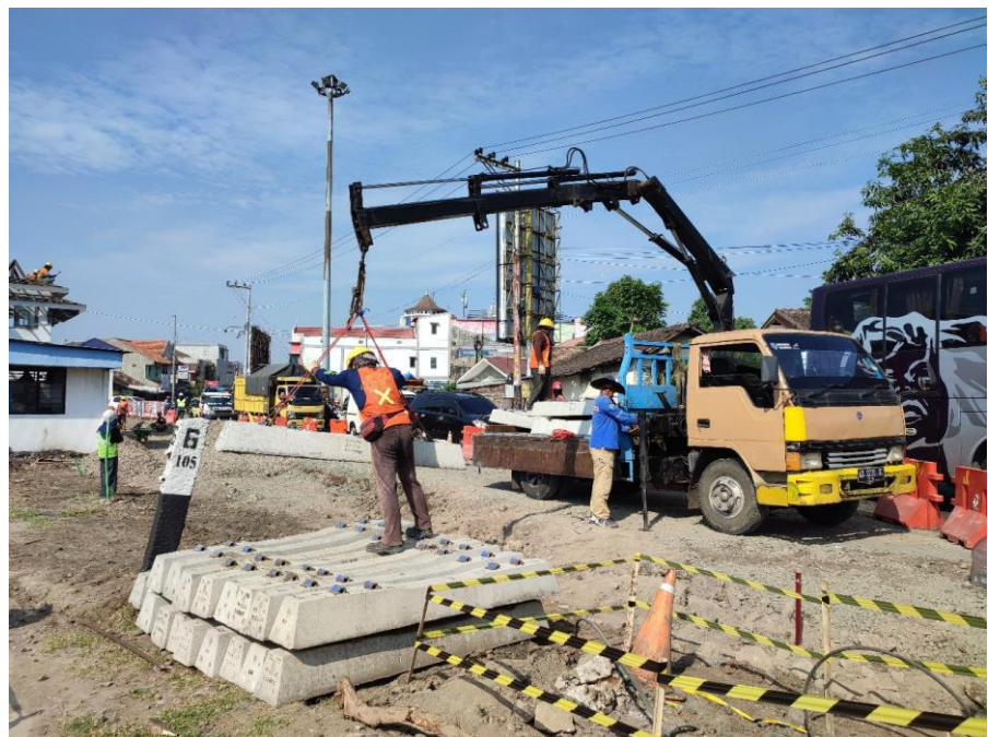
Gambar 2. 13 Proses Pengeceran Bantalan Menuju Masing-masing STA
