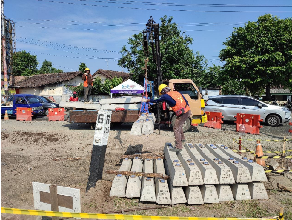
Gambar 11 Proses Pelangsiran Bantalan
