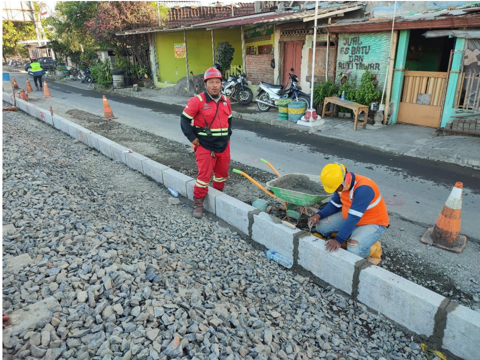
Gambar 5 Proses Pemasangan Kanstin
