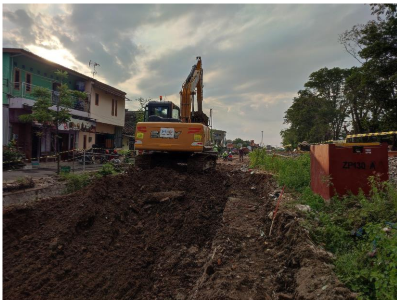
Gambar 2. 9 Proses Galian dengan Excavator
