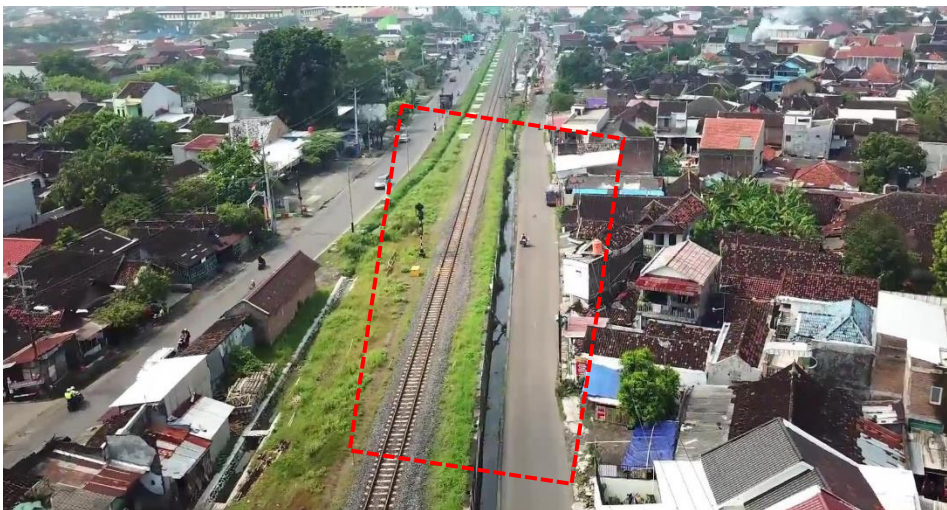
Gambar 3. 5 Kondisi Eksisting Tubuh Baan Track KM 105+175 – KM 105+335
