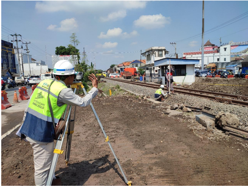
Gambar 13 Tim Surveyor Melakukan Pengecekan Elevasi Ballast
