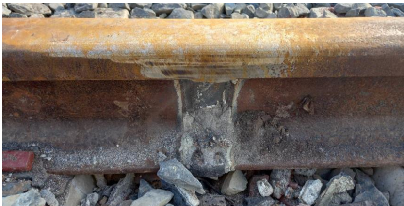
Gambar 2. 20 Hasil Akhir Las Thermit
