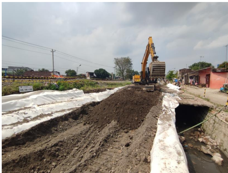
Gambar 2. 8 Proses Penghamparan Tanah dengan Excavator
