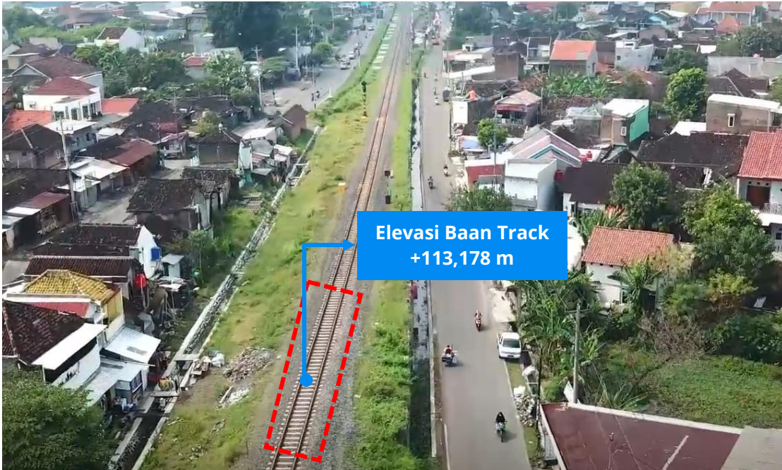
Gambar 3. 2 Kondisi Aktual Posisi Tubuh Baan Track KA KM 105+087,5 – KM 105+110
