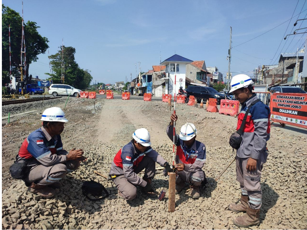
Gambar 9 Tim Surveyor Melakukan Pemasangan Patok Alinyemen
