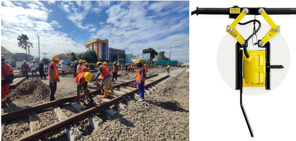
Gambar 2. 22 Proses Pekerjaan HTT dan Ilustrasi Alat HTT
