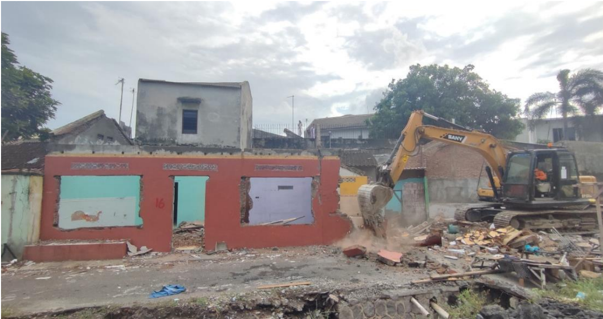
Gambar 3. 24 Proses Pembongkaran Rumah Untuk Pembebasan Lahan
