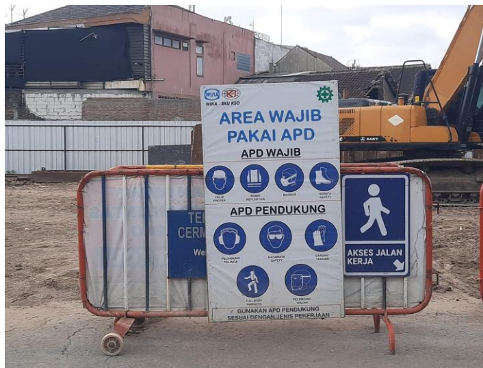
Gambar 2. 5 Pengaplikasian Rambu – Rambu Keselamatan dalam Proyek
