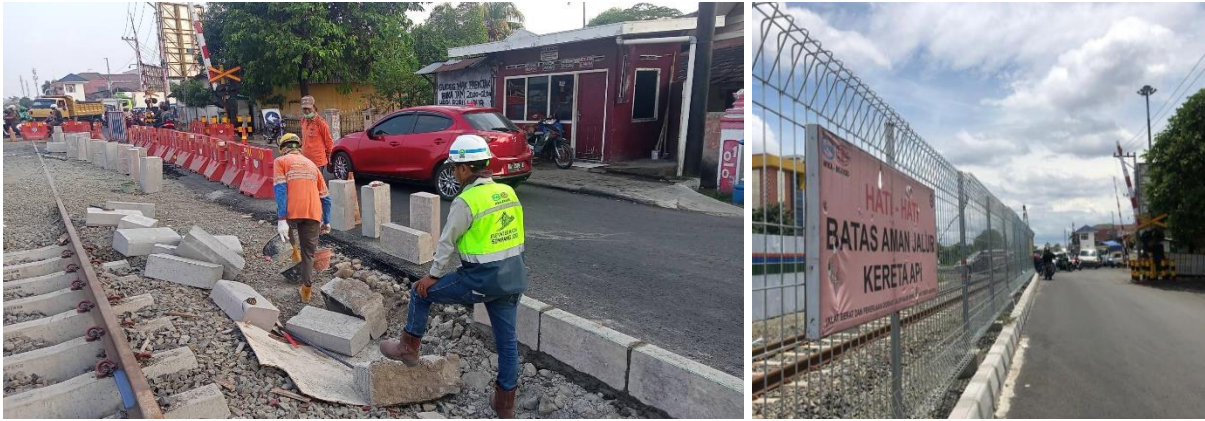
Gambar 3. 17 Pemasangan Kanstin dan Pagar BRC
