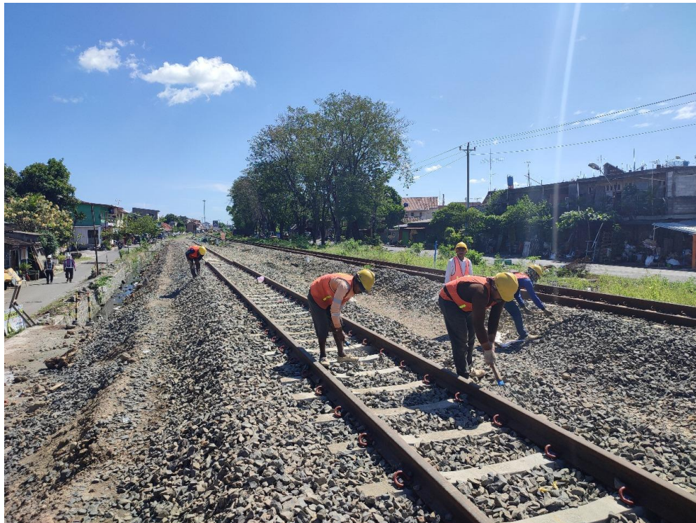
Gambar 10 Proses Pemasangan Pendroll
