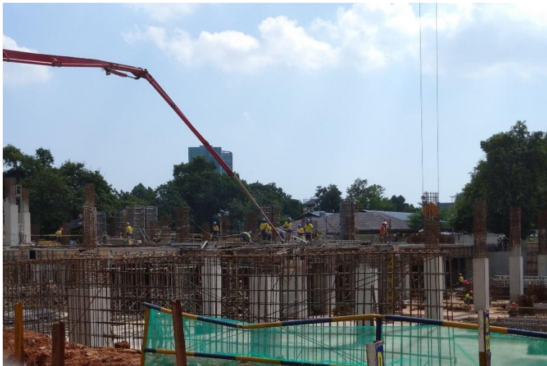
Gambar 41. Pekerjaan Pengecoran Pelat Lantai
