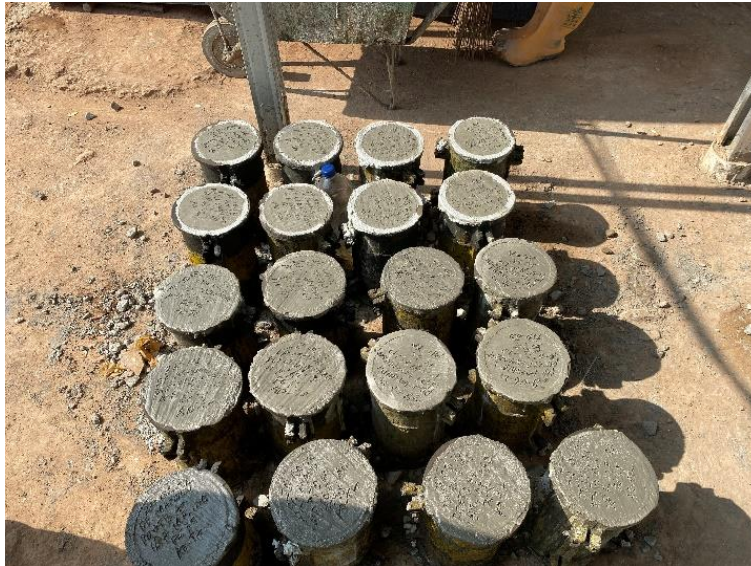
Gambar 100. Sampling Beton untuk Uji Kuat Tekan
