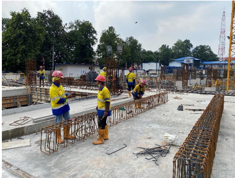
Gambar 29. Pekerjaan Pembesian Balok
