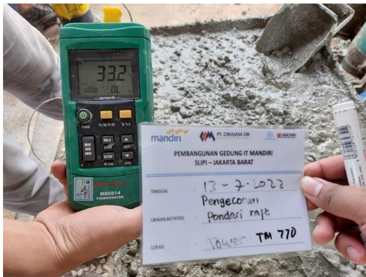
Gambar 99. Pengecekan Suhu Beton
