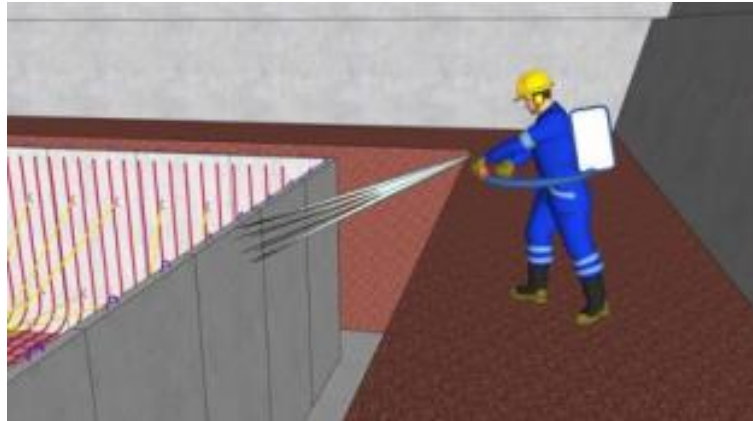
Gambar 69. Ilustrasi Pemberian Cairan Anti Rayap
