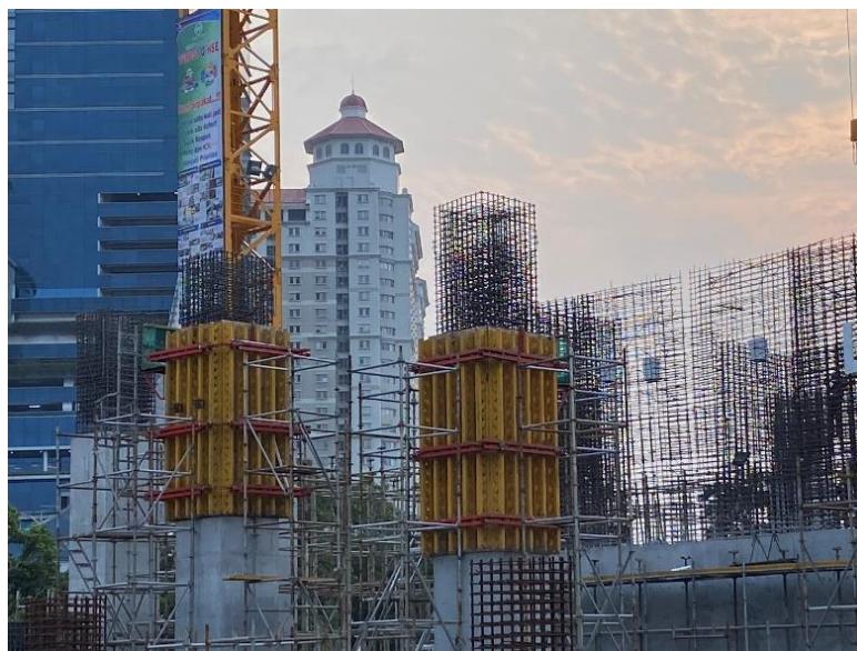
Gambar 51. Bekisting Kolom untuk Lantai Atas
