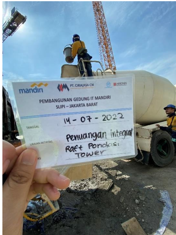
Gambar 102. Dokumentasi Penambahan Zat Aditif Integral
