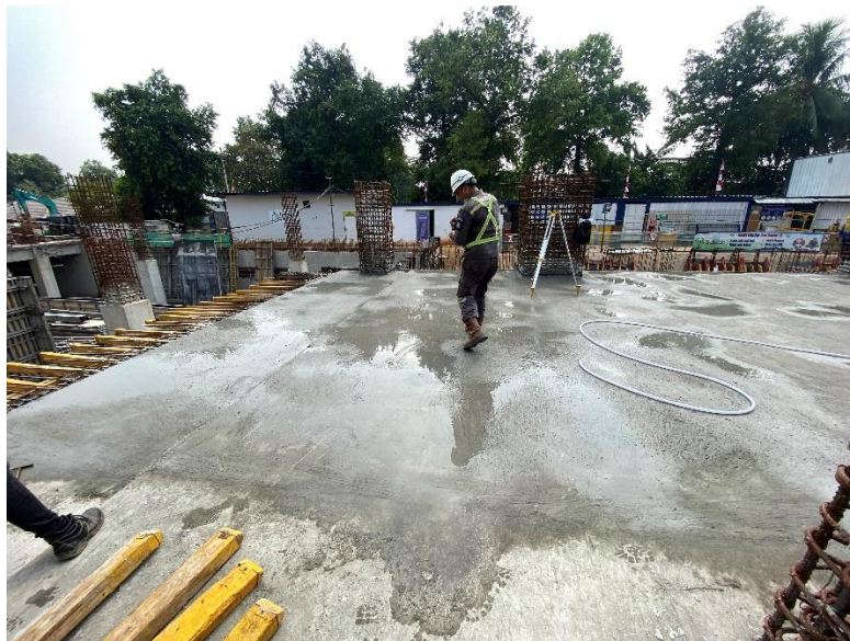
Gambar 43. Curing Pelat Lantai
