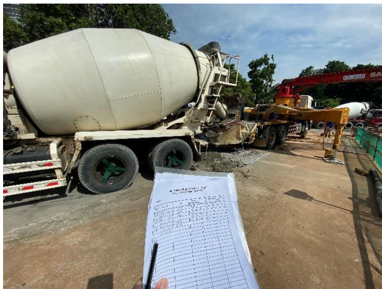
Gambar 101. Monitoring pada Pos Concrete Pump
