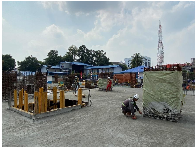
Gambar 47. Pekerjaan Marking Kolom
