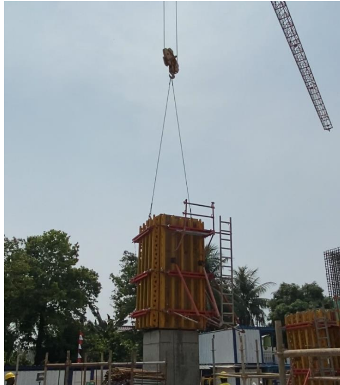
Gambar 54. Pembongkaran Bekisting Kolom
