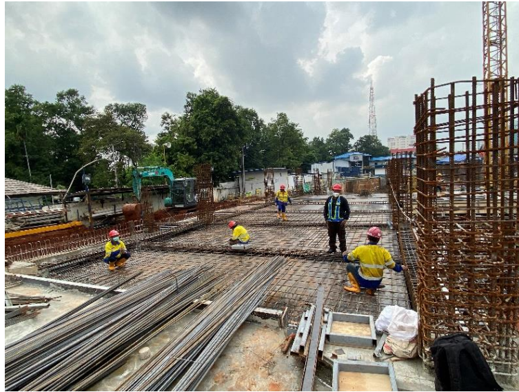
Gambar 38. Pekerjaan Pembesian Pelat Lantai
