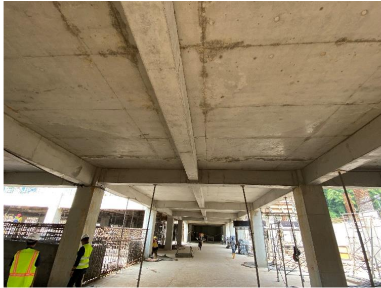
Gambar 44. Hasil Pekerjaan Pelat Lantai
