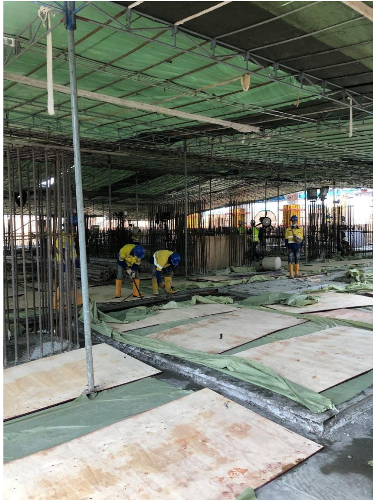
Gambar 78. Perawatan ( curing ) dengan Triplek dan Plastik Cor pada Raft Foundation
