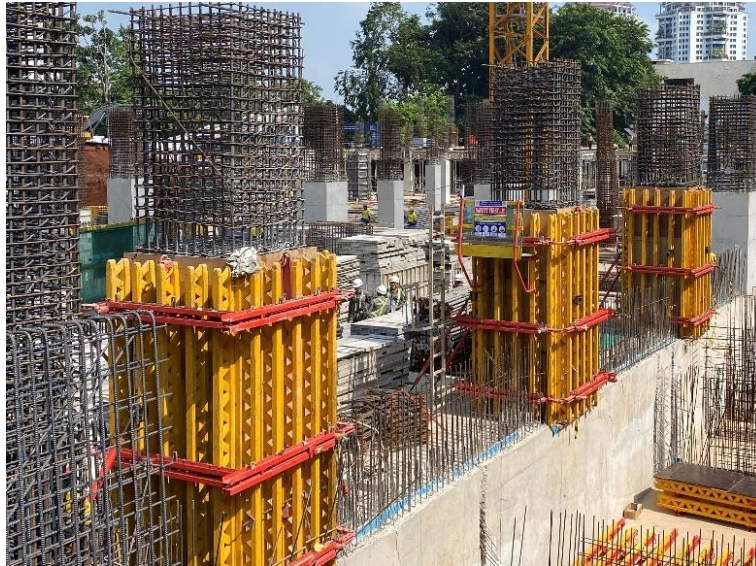
Gambar 50. Bekisting Kolom
