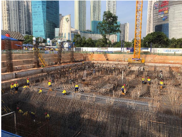
Gambar 67. Pembesian Raft Foundation Bagian Bawah
