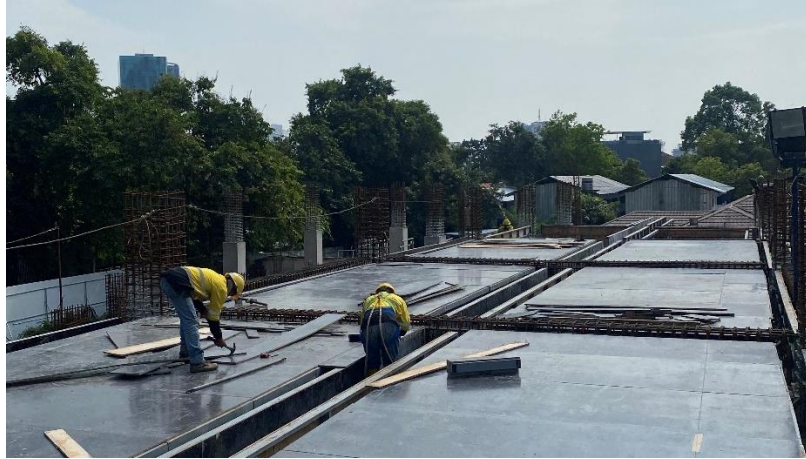
Gambar 36. Perakitan Bekisting Pelat Lantai
