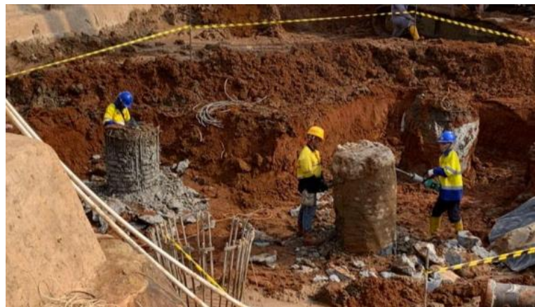
Gambar 59. Pekerjaan Pemotongan Bore Pile
