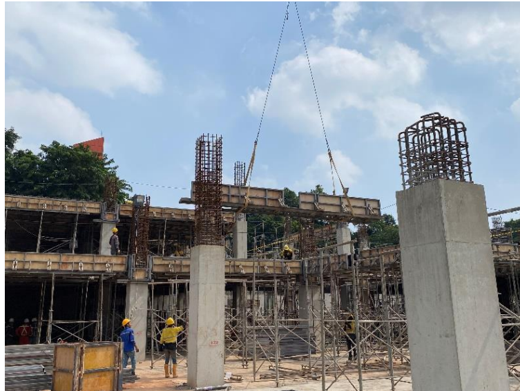
Gambar 27. Proses Pemasangan Bekisting dengan Tower Crane
