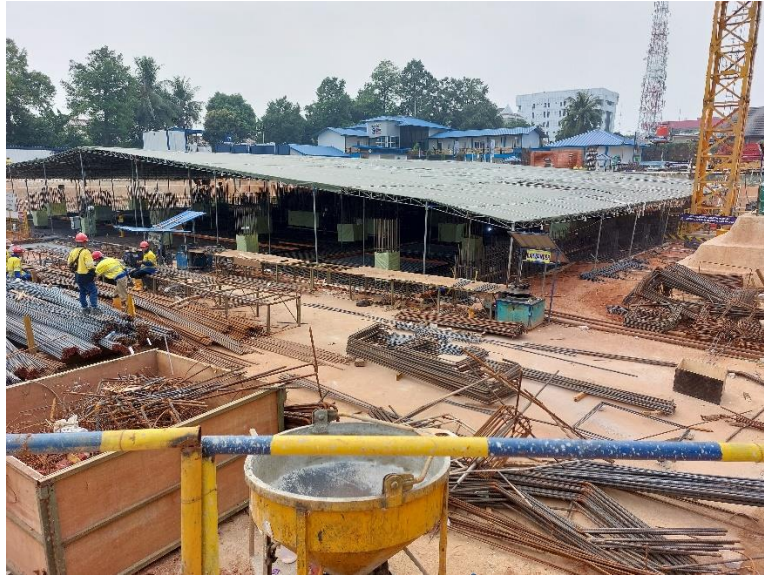
Gambar 77. Proteksi Tenda pada Raft Foundation
