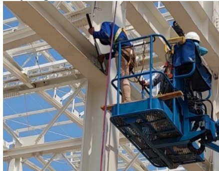
Gambar 5. 39 Proses Tightening Bolt oleh Teknisi
