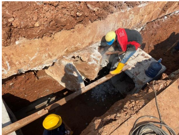
Gambar 5. 52 Pemasangan Box Culvert
