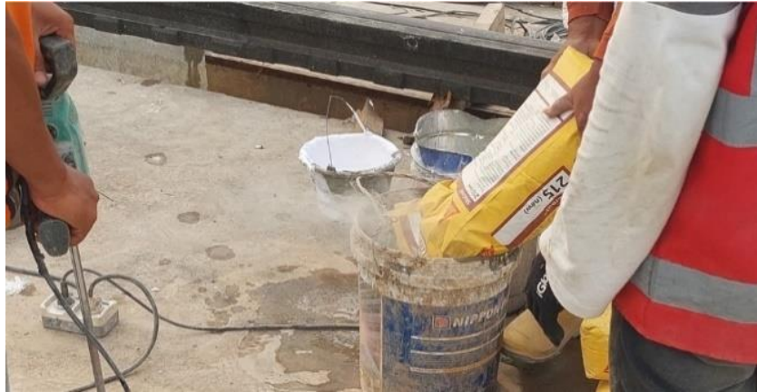
Gambar 5. 49 Pengadukan Material Air dengan Sika Grout
