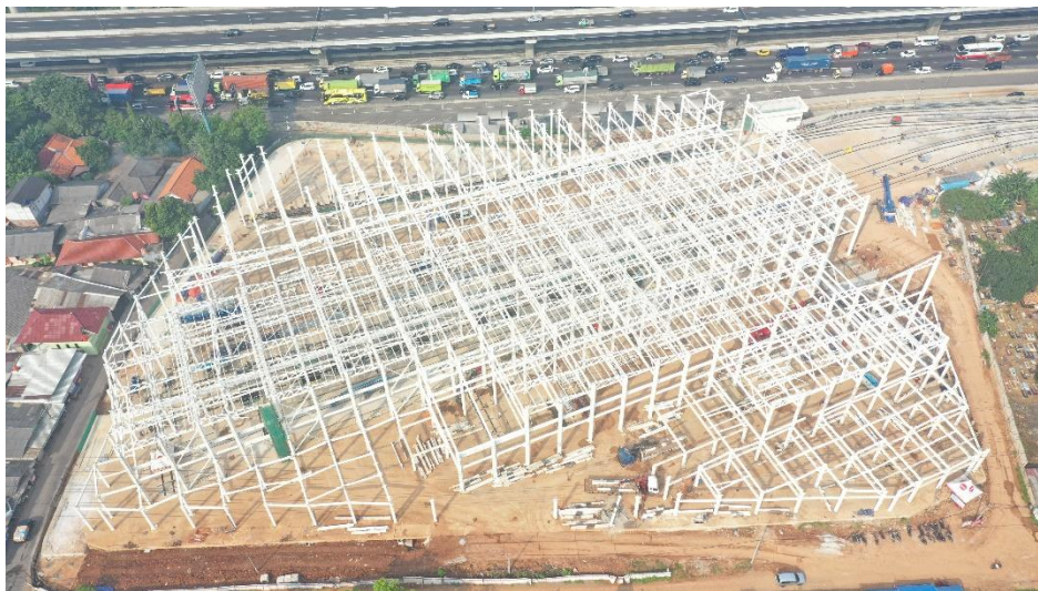
Gambar 2. 3 Lokasi Proyek Pembangunan Heavy Maintenance
