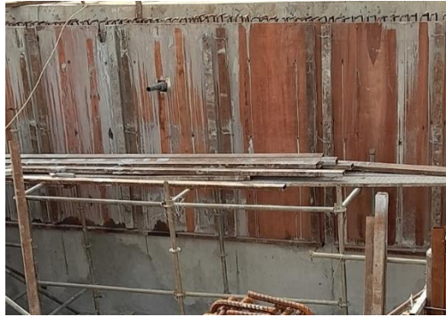
Gambar 4. 32 Bekisting dari Phenolic Film pada Pump Room
