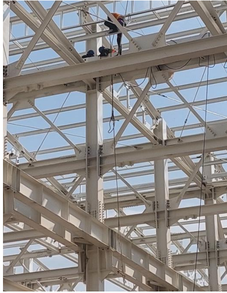
Gambar 5. 15 Proses Erection Sagrod
