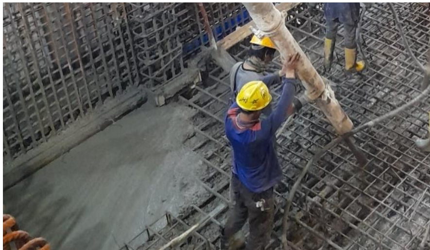
Gambar 4. 6 Beton Ready Mix pada Pump Room
