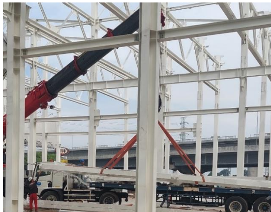
Gambar 5. 5 Unloading Rafters dari Truk Tronton ke Titik Tertentu
