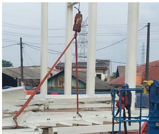
Gambar 5. 6 Pemandahan Material Rafters Menggunakan Mobile Crane
