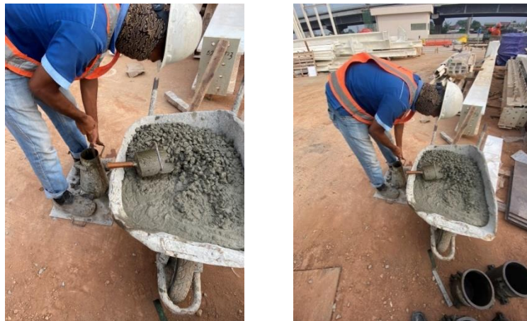
Gambar 5. 31 Teknisi Melakukan Slump Test
