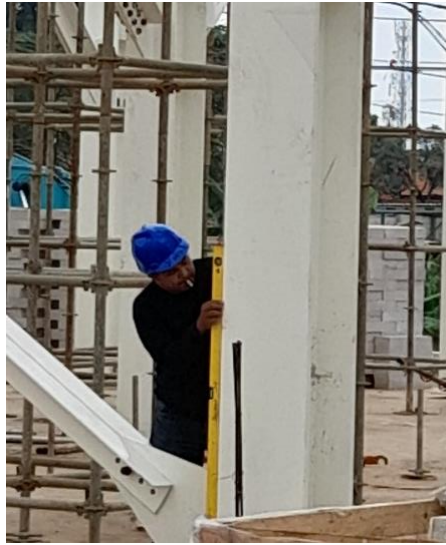
Gambar 5. 34 Waterpass di Bagian Bawah Kolom
