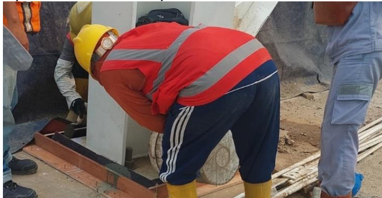
Gambar 5. 50 Pemerataan Material Sika Grout yang di Tuang pada Anchor
