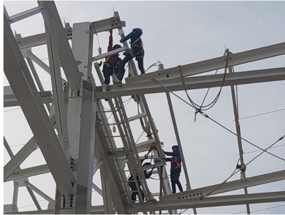
Gambar 5. 22 Pemasangan Fasad Kaca
