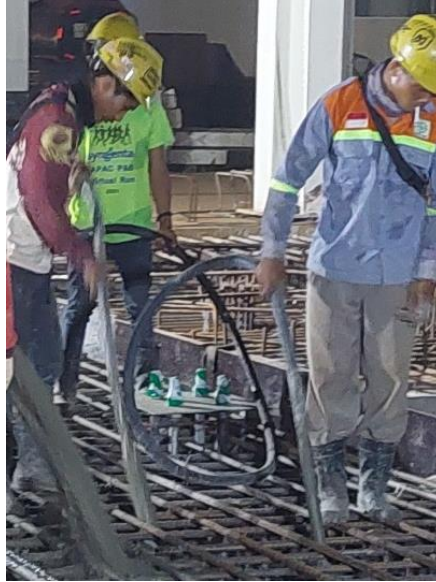
Gambar 4. 35 Pengecoran Slab Menggunakan Concrete Vibrator
