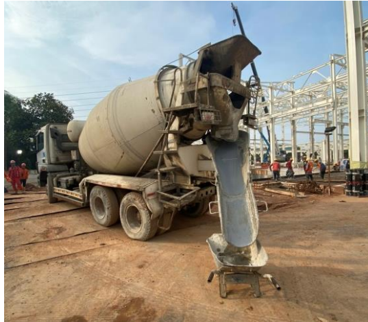
Gambar 5. 29 Proses Pengambilan Beton Segar dari Mixer Truck
