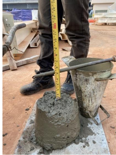
Gambar 5. 32 Pemeriksaan Nilai Slump
