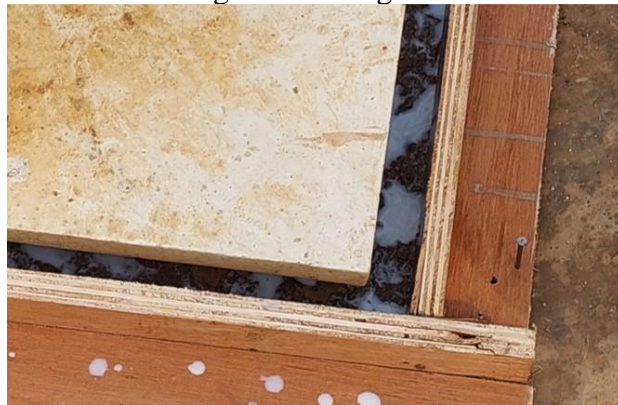
Gambar 5. 48 Pembuatan Bekisting di Lapangan
