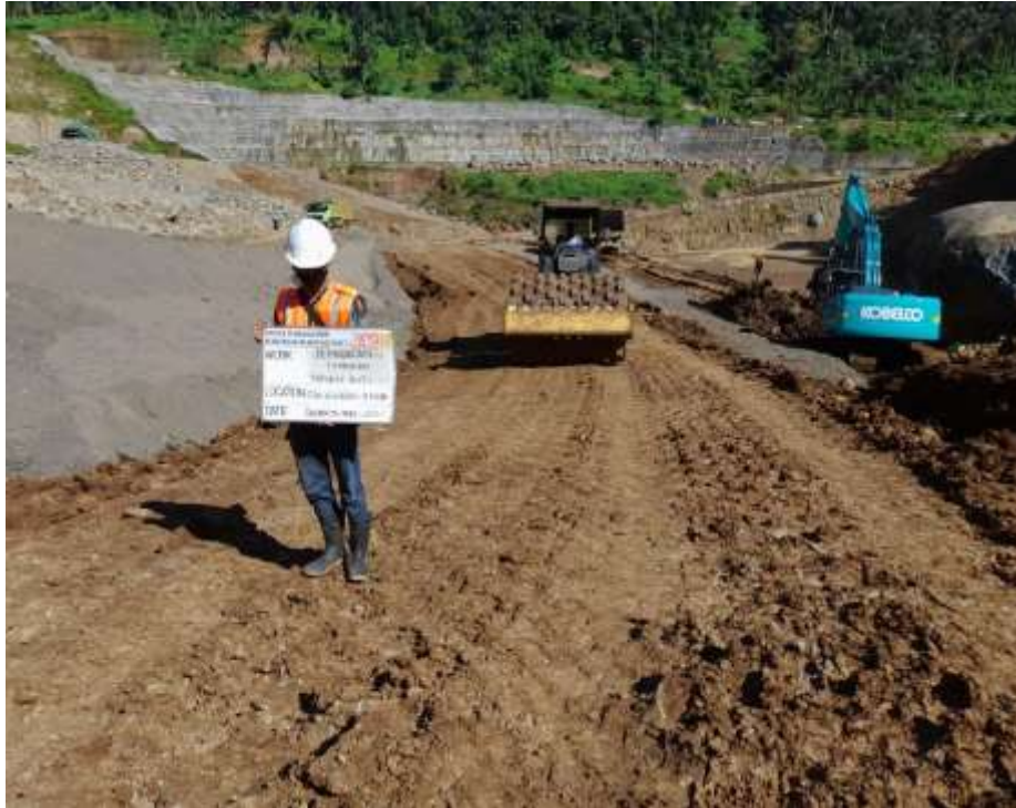
Gambar 9 Pemadatan Lapisan Tanah Inti Menggunakan Sheep Foot Roller
