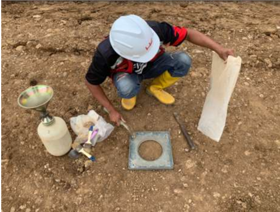
Gambar 24 Pemasangan pelat dasar
