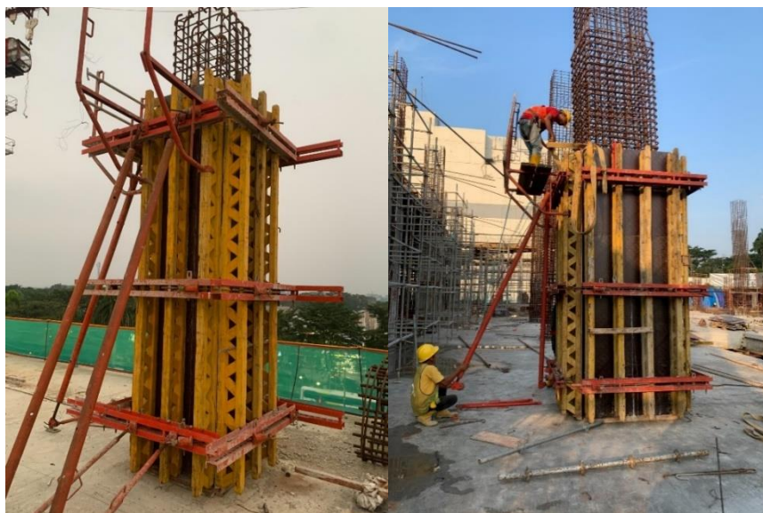
Gambar 2.15 Inspeksi bekisting kolom
