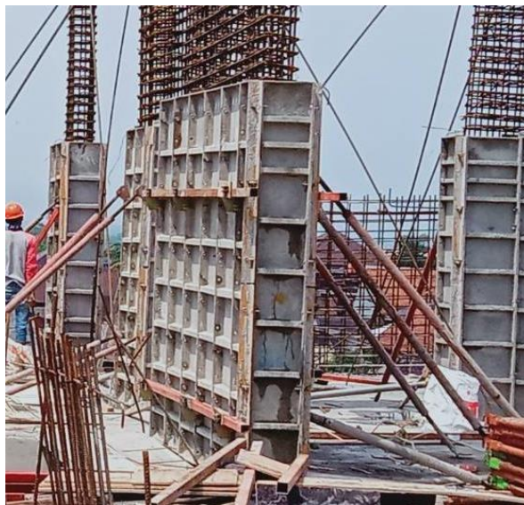
Gambar 2.31 Pemasangan bekisting shearwall
