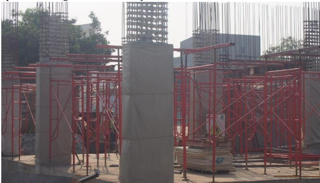
Gambar 2.17 Pelepasan bekisting kolom setelah 24 jam.
