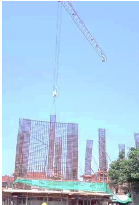
Gambar 2.29 Erection shearwall dengan bantuan tower crane.
