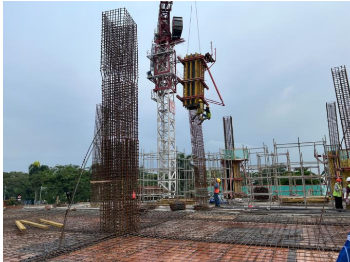
Gambar 2.14 Pemasangan bekisting kolom
