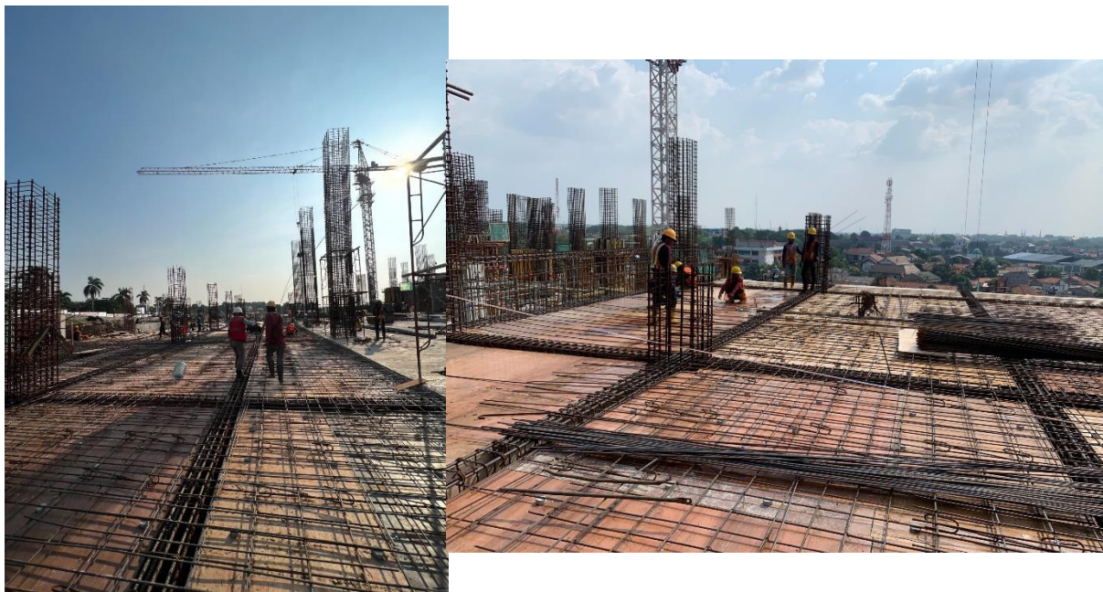
Gambar 2.22 Pekerjaan pembesian balok dan pelat lantai
