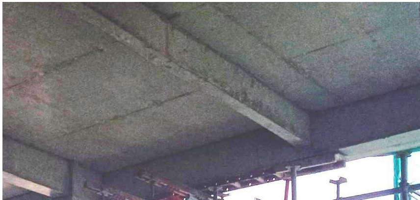
Gambar 2.25 Penampakan balok yang sudah siap
