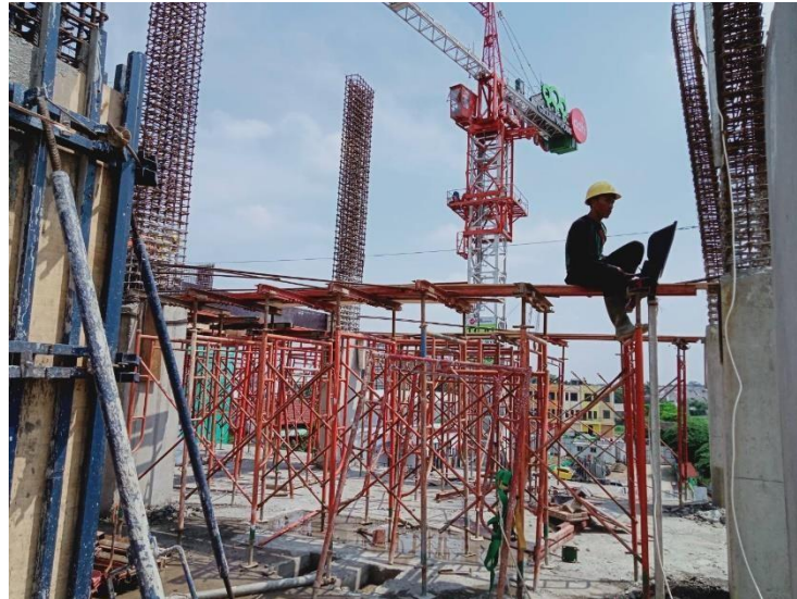
Gambar 2.21 Pembuatan bekisting untuk balok dan pelat lantai
