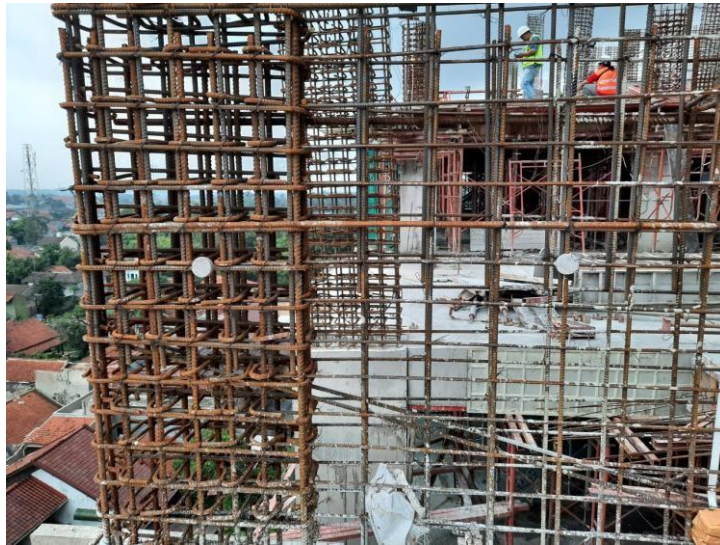
Gambar 2.30 Penyambungan tulangan shearwall
