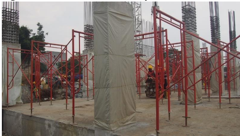
Gambar 2.20 Pemasangan perancah untuk balok dan pelat lantai.
