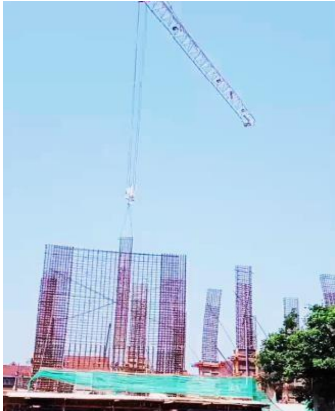
Gambar 2.12 Erection kolom dengan bantuan tower crane
