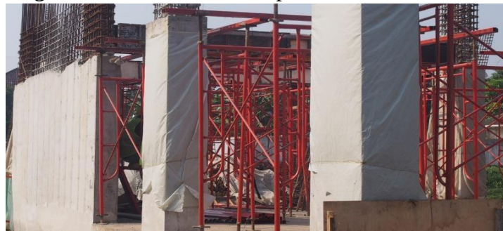
Gambar 2.33 Pelepasan bekisting shearwall setelah 24 jam
