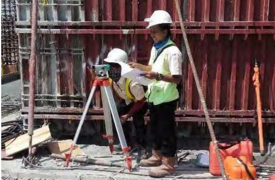
Gambar 2.19 Pekerjaan marking as dan elevasi kepala kolom
