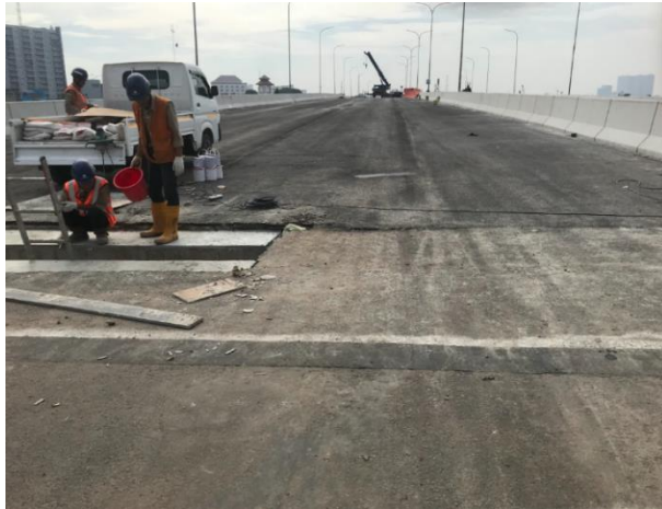
Gambar 4.15 Pekerjaan pada sisi kiri jalan
