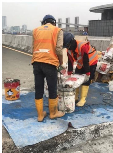
Gambar 4.18 Pekerjaan mixing beton untuk grouting
