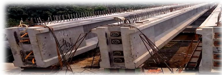
Gambar 3.10 PC-I yang sudah di grouting
