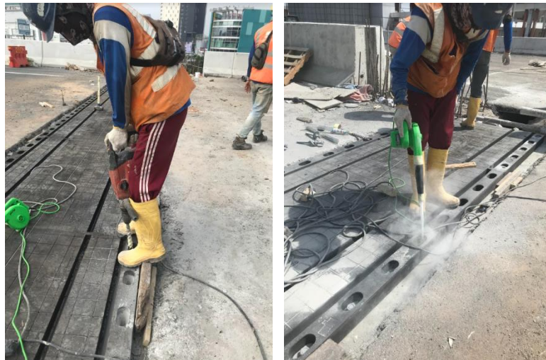
Gambar 4.22 Pengeboran dan pembersihan lubang angkur expansion joint
