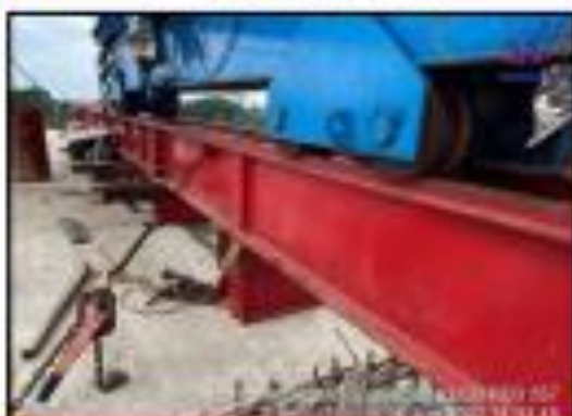
Bracing LCB sudah terinstall
