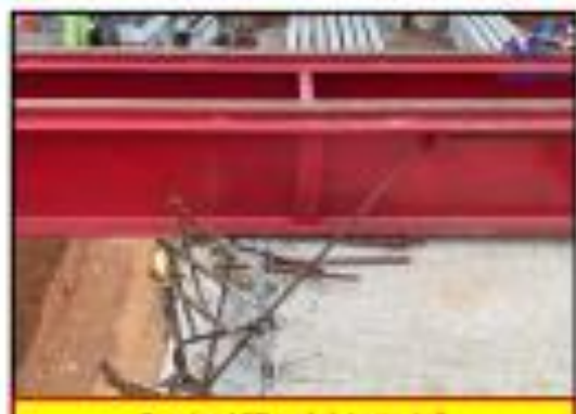
Bracing LCB sudah terinstall
