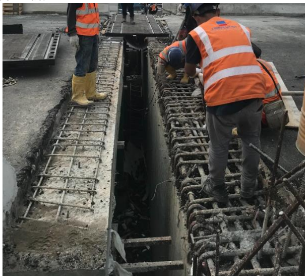
Gambar 4.16 Kondisi permukaan setelah pengangkatan aspal
