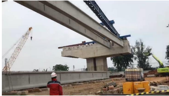
Gambar 4.7 Proses peletakan girder di atas bearing pad
