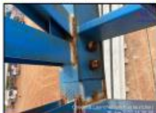
Pin dan cutter pada joint Trusa Launcher terinstall lengkap
