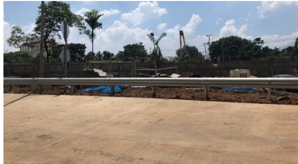
Gambar 5.4 Guardrail pada offramp
