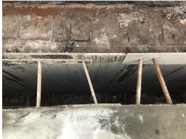
Gambar 4.17 Pemasangan bekisting untuk pekerjaan grouting
