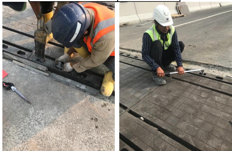
Gambar 4.23 Chemical joint, pemasangan angkur, dan Pemberian torsi pada baut
