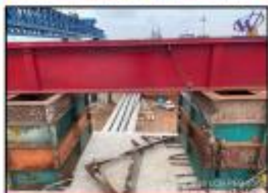
Bracing LCB sudah terinstall
