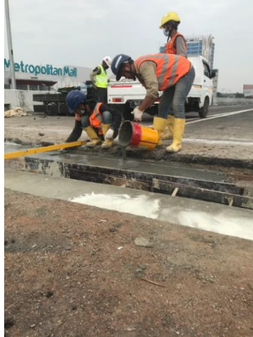
Gambar 4.19 Pekerjaan penghamparan dan perataan beton pada pekerjaan grouting
