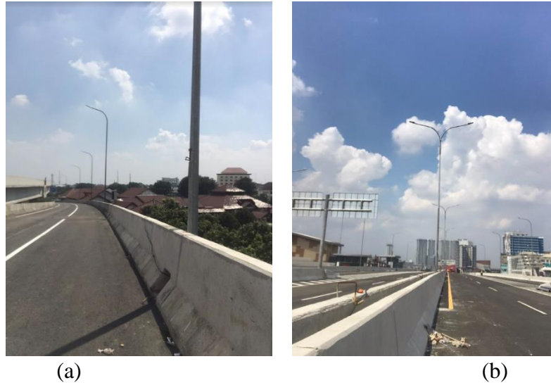
Gambar 5.1 (a) Penerangan jalan umum tipe tunggal; (b) Penerangan jalan umum tipe kupu-kupu
