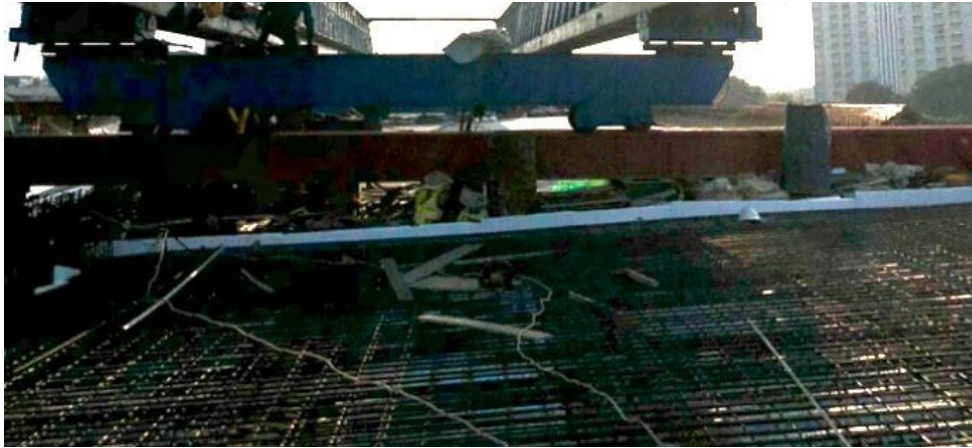
Gambar 3.18 Styrofoam Pembatas Slab
