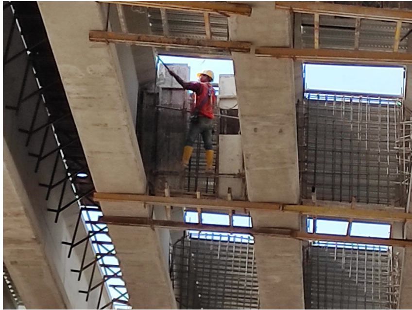
Gambar 3.9 Pemasangan Bekisting Samping Diafragma
