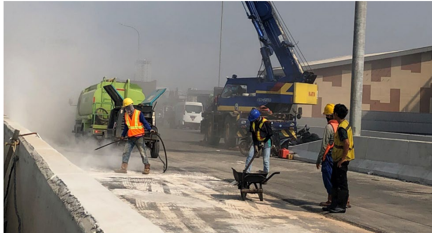
Gambar 3.25 Pembersihan Lokasi dengan Air Compressor
