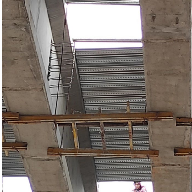
Gambar 3.2 Pemasangan Bekisting Bawah Diafragma
