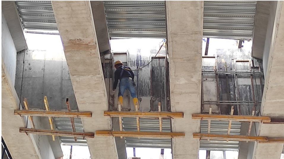
Gambar 3.10 Pembongkaran Bekisting Diafragma
