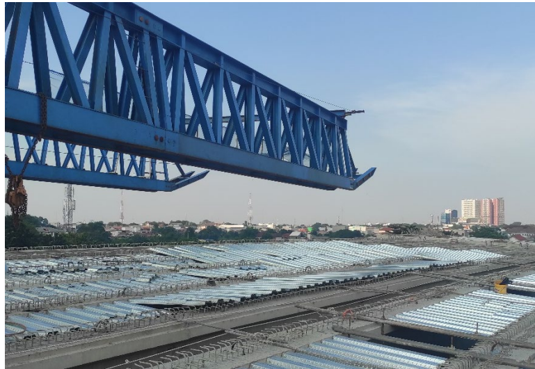
Gambar 3.13 Pemasangan Steel Deck
