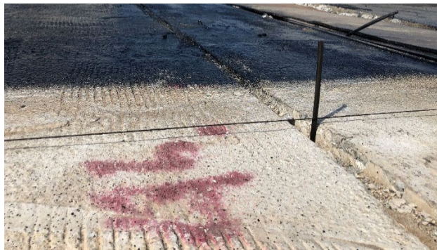
Gambar 3.26 Marking Batas Pekerjaan Aspal
