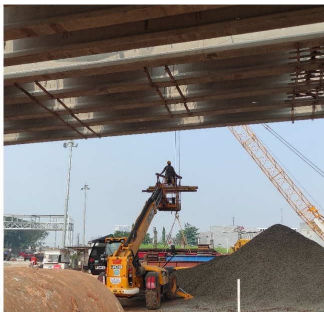
Gambar 3.3 Pemasangan Balok Melintang
