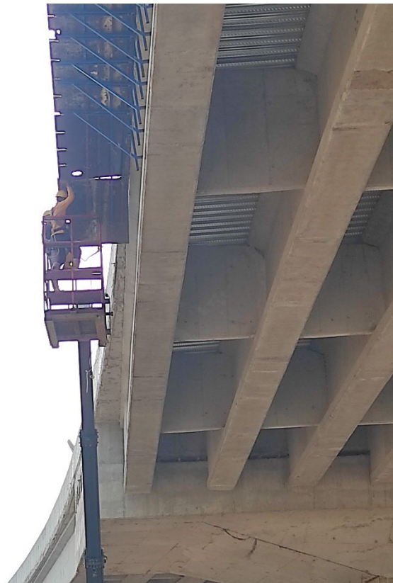
Gambar 3.21 Pembongkaran Bekisting Outer Slab
