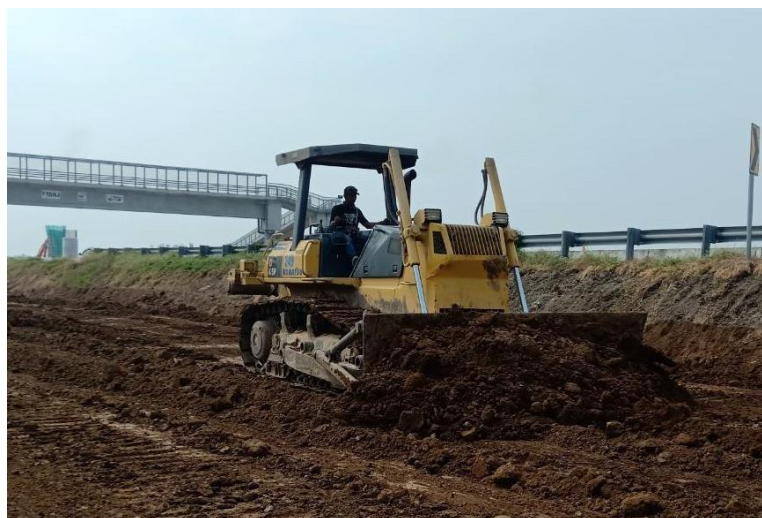
Gambar 3.9 Proses Penghamparan Tanah Timbunan Menggunakan Bulldozer
