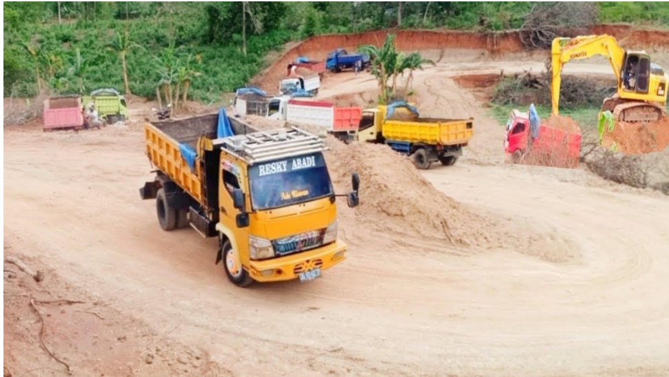
Gambar 5.5 Keluar Masuk kendaraan di dalam proyek
