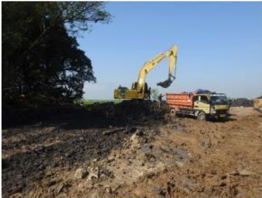
Gambar 3.5 Loading Tanah ke Dalam Dump Truck
