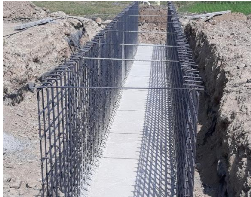
Gambar 3.26 Pembesian Box Culvert
