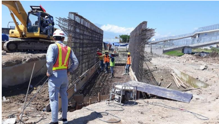
Gambar 3.33 Proses Pemasangan Tulangan Underpass dan Bekisting Lantai Underpass
