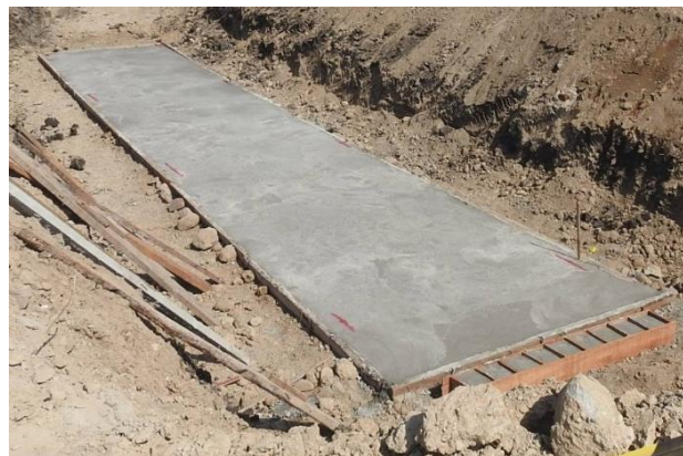
Gambar 3.25 Pengecoran Lantai Kerja
