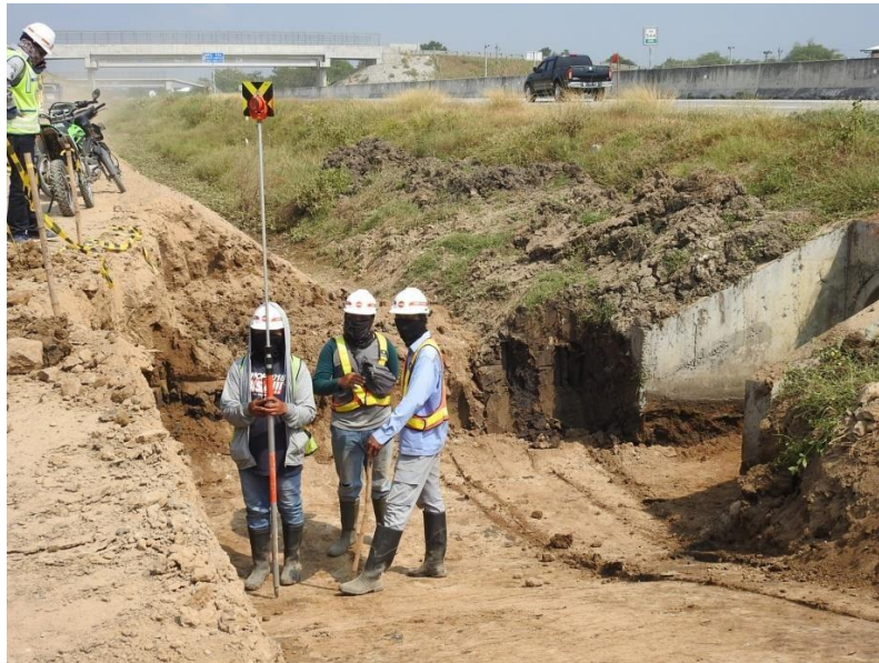
Gambar 3.3 Marking Lokasi Pekerjaan
