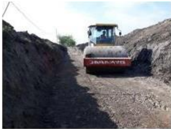
Gambar 3.24 Pemadatan Tanah Dasar
