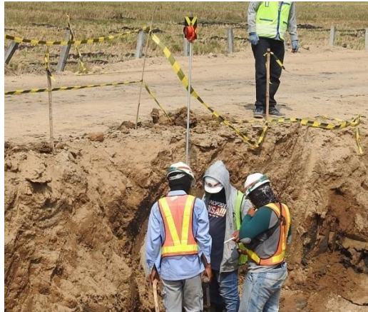
Gambar 3.23 Pengukuran dan Pemasangan Patok
