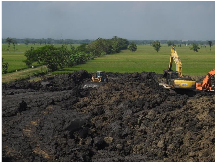
Gambar 3.4 Proses Pengupasan Tanah Menggunakan Bulldozer dan Excavator
