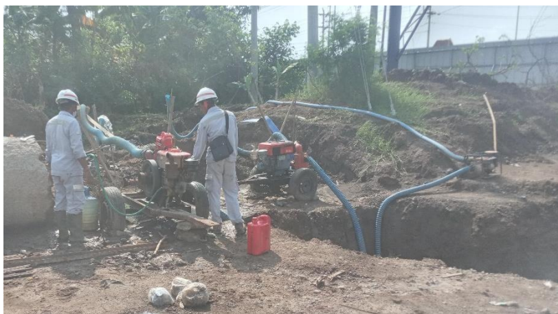
Gambar 5.1 Proses dewatering pada footing
