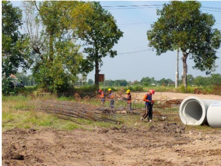
Gambar 3.19 Proses Fabrikasi Baja Tulangan Bored Pile
