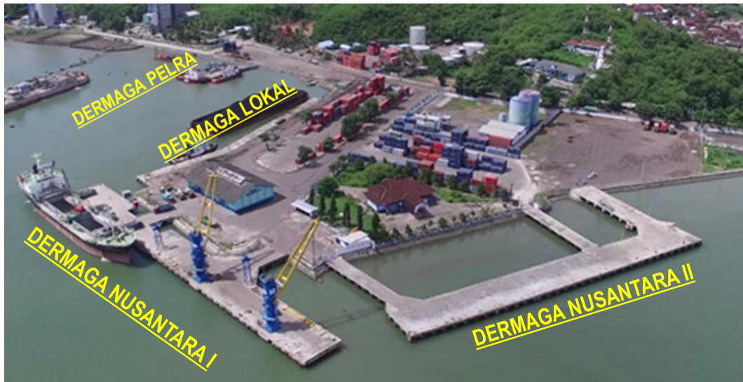
Gambar II-2 Kondisi Pelabuhan Lembar
