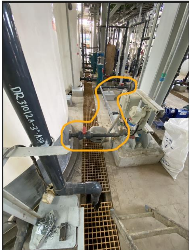
Gambar 5. 9 Keadaan Tangki Setelah Digrouting
