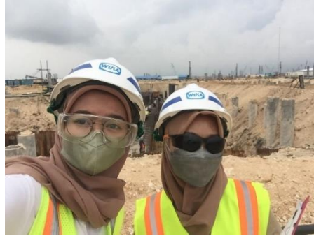
Gambar 4. 3 Pemakaian Helm Safety
