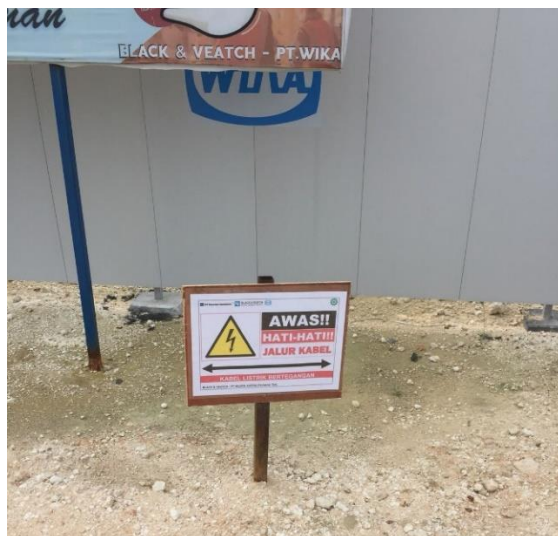
Gambar 4. 13 Peringatan Jalur Kabel
