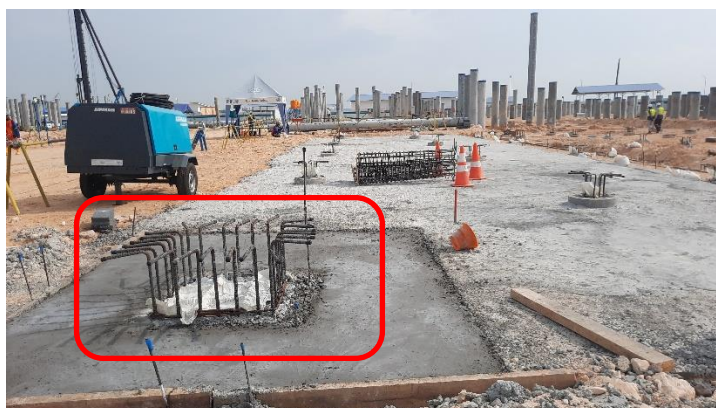
Gambar 6. 3 PHT Modifikasi pada Area Filtered Water Pumps Shed
