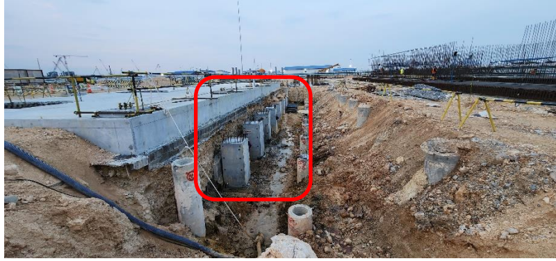
Gambar 6. 4 PHT Modifikasi pada Area Filtered Water Tank
