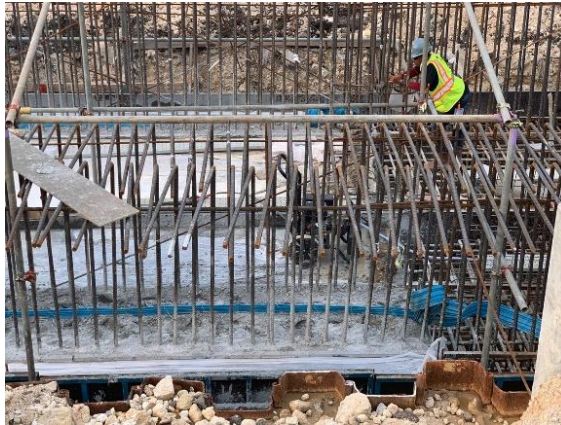
Gambar 5. 13 Penggunaan Water Stop pada Pengecoran Pondasi RO Building
