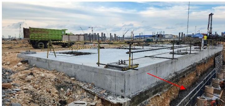
Gambar 6. 5 Plain Concrete Sebelum Dibuka Bekistingnya
