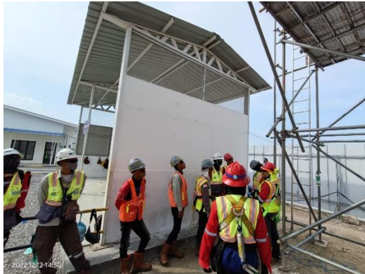
Gambar 4. 37 Training Bekerja di Ketinggian (Sumber: Dokumentasi HSE)
