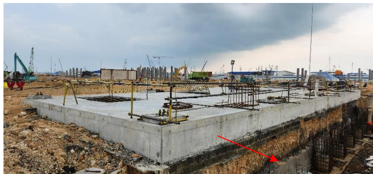
Gambar 6. 6 Plain Concrete Setelah Dibuka Bekistingnya
