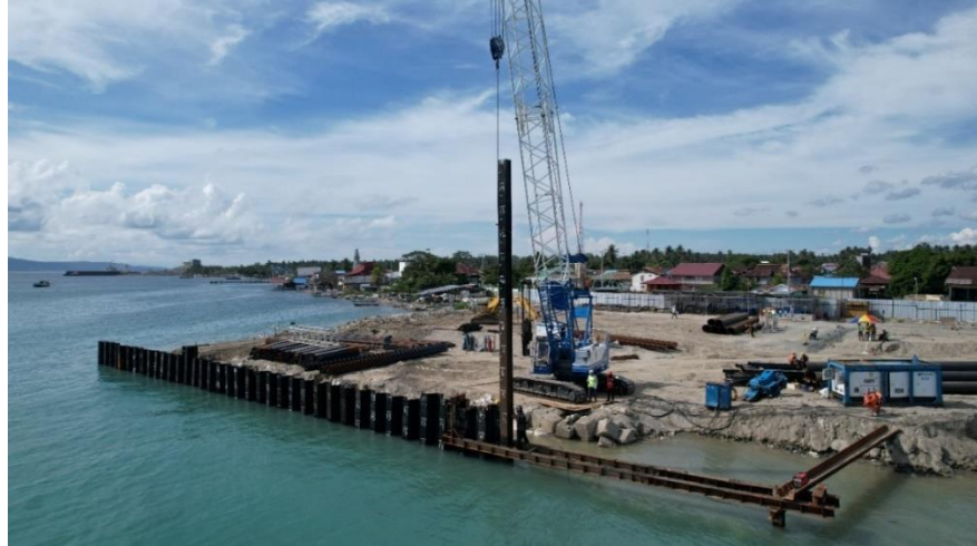
Gambar 3.18 Peletakan Sheetpile pada Guide Beam (Sumber: PT. Wijaya Karya, 2022)
