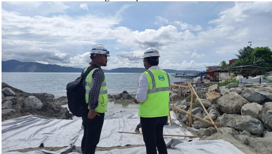
Gambar 2.50 Pelaksana dan Quantity Surveyor pada saat Opname Pemasangan Geotextile (Sumber: Dokumentasi Pribadi, 2022)
