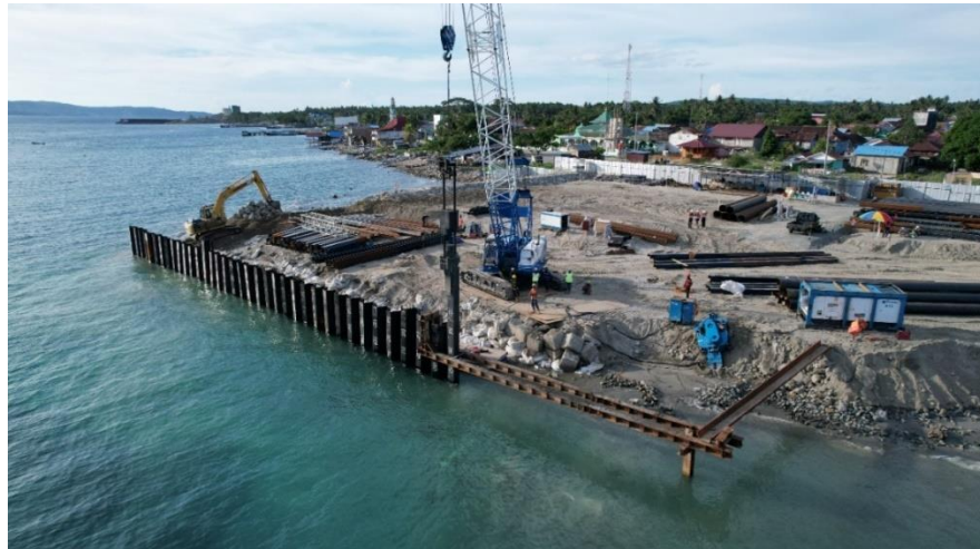
Gambar 3.19 Pemancangan Sheetpile Segmen 11 (Sumber: PT. Wijaya Karya, 2022)
