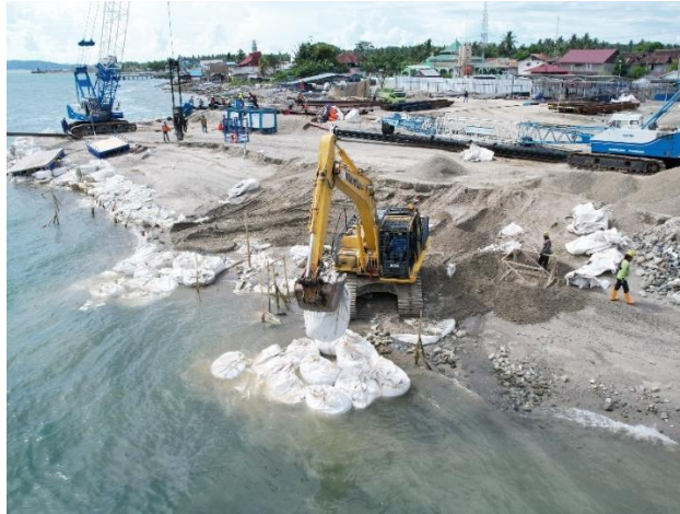
Gambar 3.14 Penggunaan Jumbo-bag untuk Mengurangi Pasir yang Hilang Terbawa Arus (Sumber: PT. Wijaya Karya, 2022)
