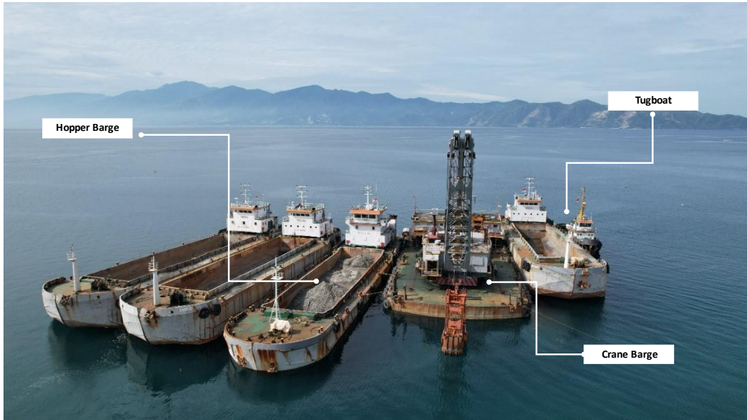
Gambar 2. 61 Peralatan Dredging (Sumber: PT Wijaya Karya, 2022)
