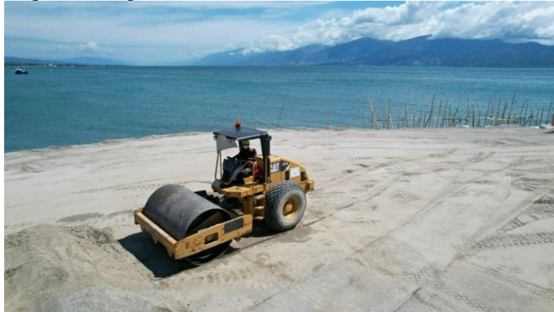
Gambar 3.9 Pemadatan dengan Vibro Roller (Sumber: PT. Wijaya Karya, 2022)
