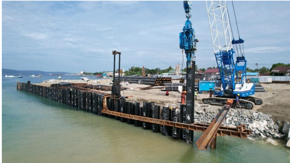
Gambar 3.21 Pemancangan Menggunakan Vibro Hammer (Sumber: PT. Wijaya Karya, 2022)
