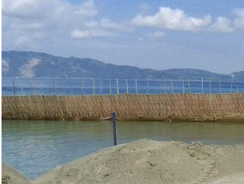
Gambar 3.12 Penggunaan Sesek Bambu sebagai Pengganti Turap (Sumber: PT. Wijaya Karya, 2022)
