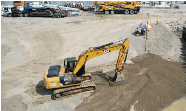
Gambar 3.2 Excavator PC 200 (Sumber: PT. Wijaya Karya, 2022)
