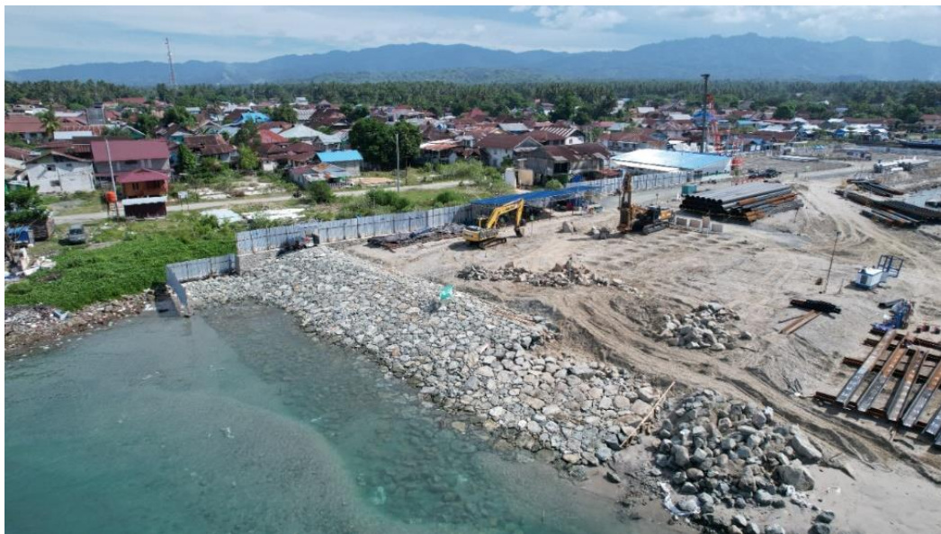
Gambar 2.37 Konstruksi Rock Armour (Sumber: PT. Wijaya Karya, 2022)
