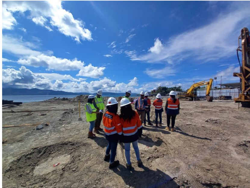
Gambar 2.51 Dokumentasi Opname Pekerjaan CDC (Sumber: Dokumentasi Pribadi, 2022)
