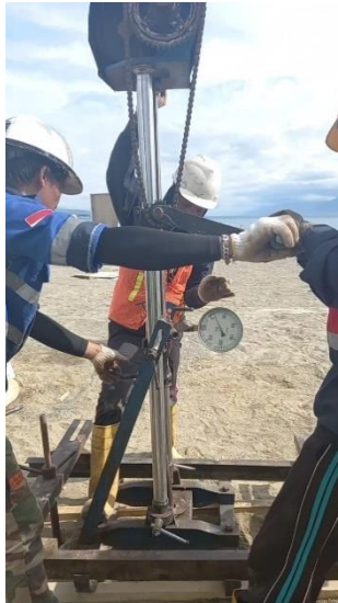
Gambar 3.11 Uji CPTu (Sumber: Dokumentasi Pribadi, 2022)
