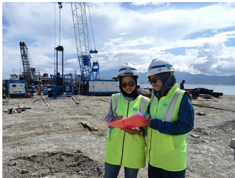
Gambar 2.52 Proses Perhitungan Jumlah Lubang CDC (Sumber: Dokumentasi Pribadi, 2022)
