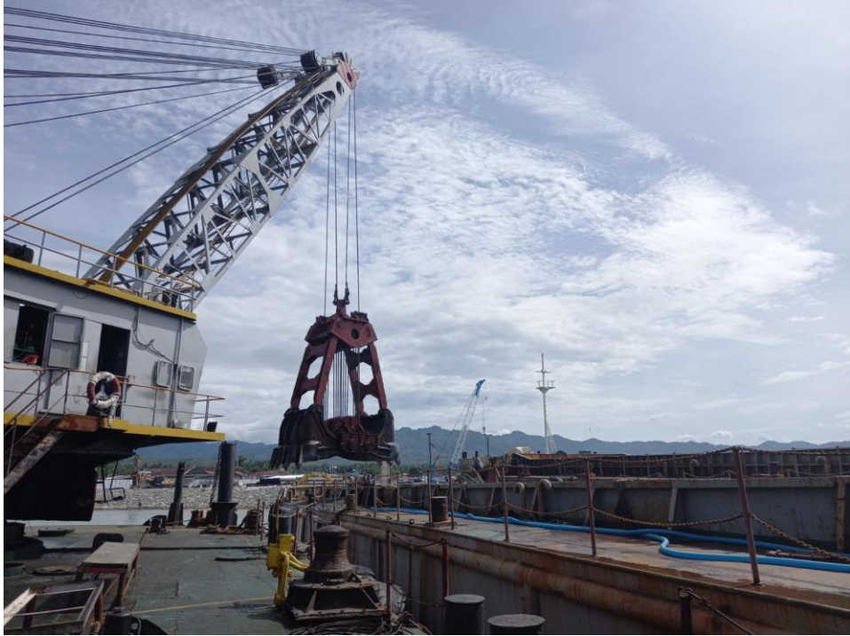
Gambar 2.63 Clam Shell pada Crane Barge (Sumber: Dokumentasi Pribadi, 2022)
