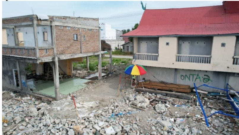
Gambar 3.16 Surveyor pada saat Stakeout Koordinat Sheetpile Segmen 11 (Sumber: PT. Wijaya Karya, 2022)
