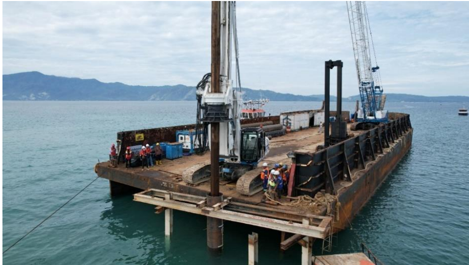
Gambar 3.44 Pre-boring pada Pemancangan Dermaga (Sumber: PT. Wijaya Karya, 2022)
