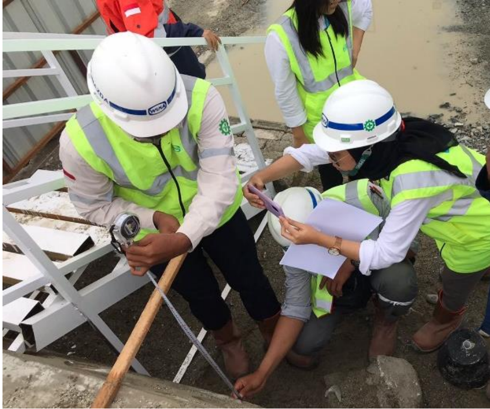
Gambar 2.53 Opname Pekerjaan Pasangan Batu untuk Gate (Sumber: Dokumentasi Pribadi, 2022)
