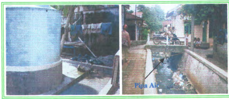
Gambar 5.32 Hidran Umum Wilayah Pasar dan Pipa Saluran Air Bersih Sumber : hasil pengamatan, 2004
