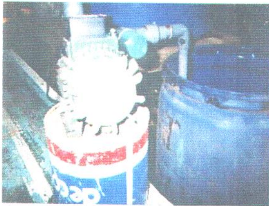
Gambar 5. Bak pengumpul dan pompa
