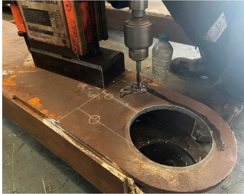
Gambar 4. 9 Proses Drilling Pada Pressure Rod Bottom
