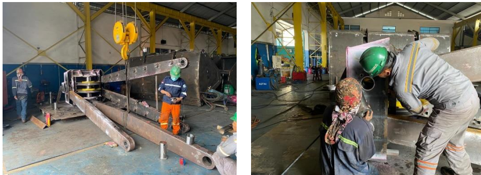
Gambar 4. 11 Proses Assembly Pada Pressure Rod dan Grab Head
