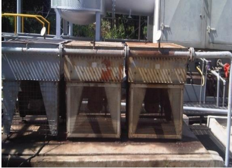
Gambar 2.6. Gambar dan spesifikasi Lube Oil Cooler [5].
