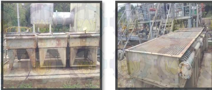
Gambar 3.6 Bentuk dan desain Lube Oil Cooler
