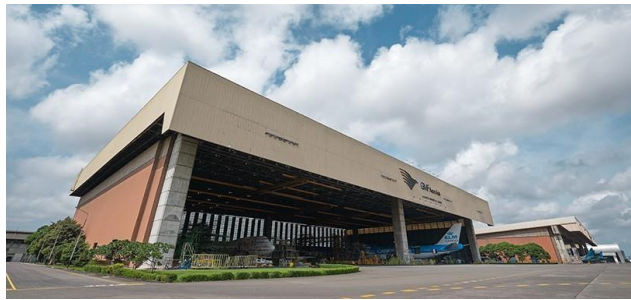
Gambar 2.3 Hanggar 1 PT. GMF AeroAsia (Sumber: https://www.gmf-aeroasia.co.id/hanggar-overview )
