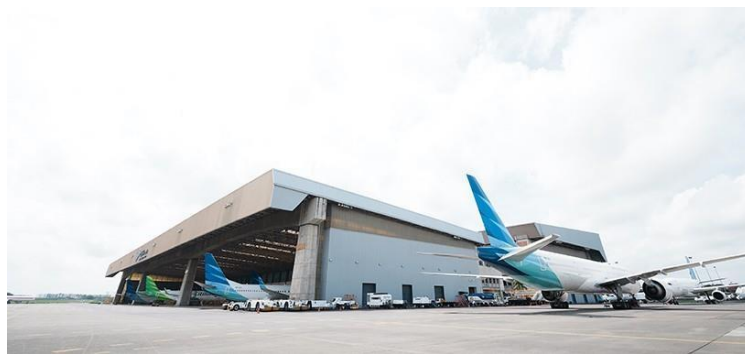
Gambar 2.4 Hanggar 2 PT. GMF AeroAsia (Sumber: https://www.gmf-aeroasia.co.id/hanggar-overview )
