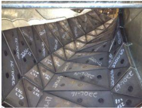
Gambar 1.2 Chute liners pada konveyor
